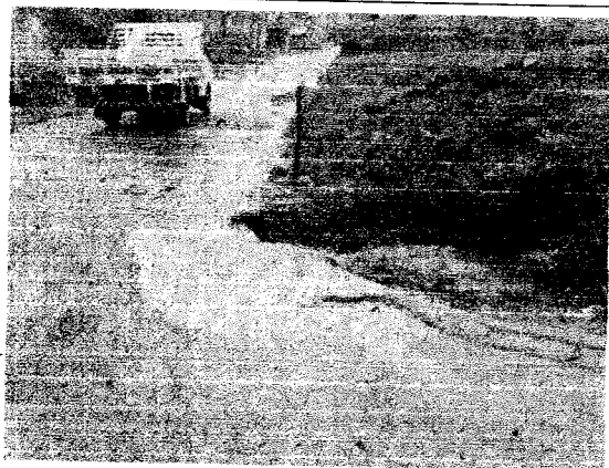
Foto 11. Vista da Rua dos Vitoriosos no ponto de confluência com a Estrada de Pirapora. Nota-se em primeiro plano o caminho da água para a passagem sob a Estrada de Pirapora.
