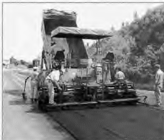
Aplicação de asfalto borracha
