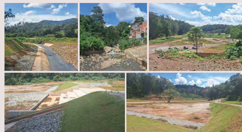
Figura 48: Fotos da implantação da infraestrutura de macrodrenagem no Núcleo Reservação
