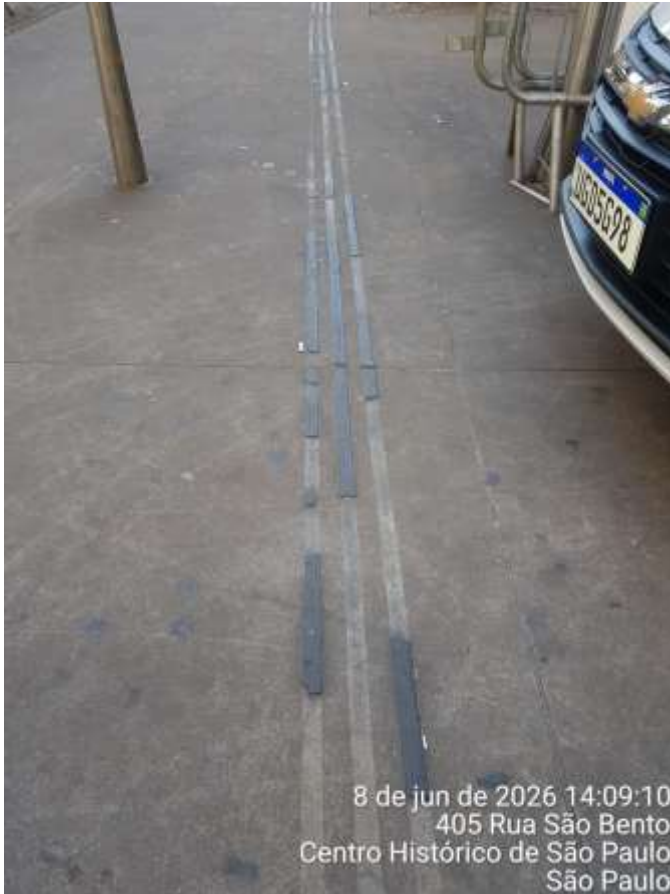
Falhas e peso sobre o Piso Podotátil
