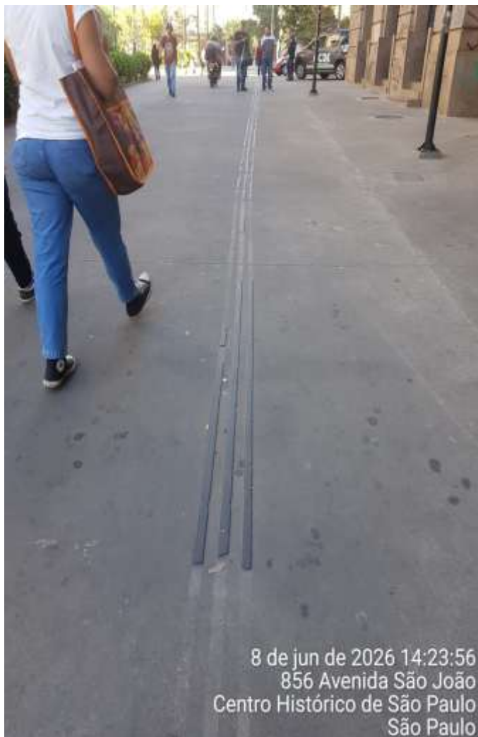
Falhas e/ou ausência do Piso Podotátil
