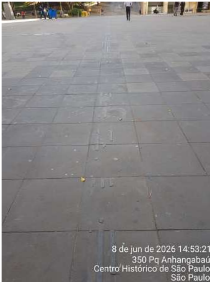
Falhas e/ou ausência do Piso Podotátil
