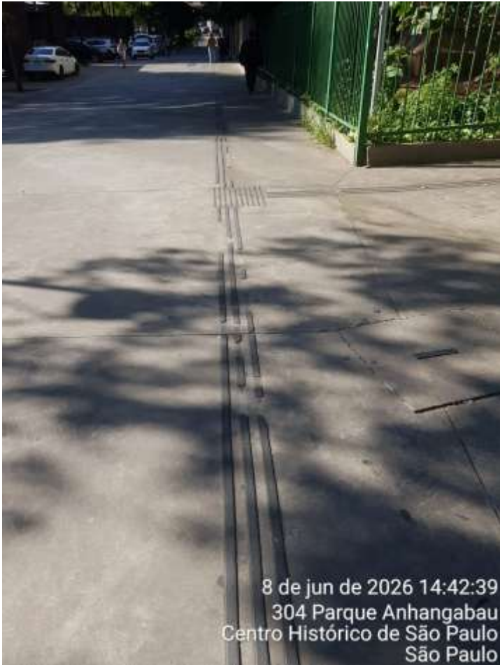
Falhas e/ou ausência do Piso Podotátil
