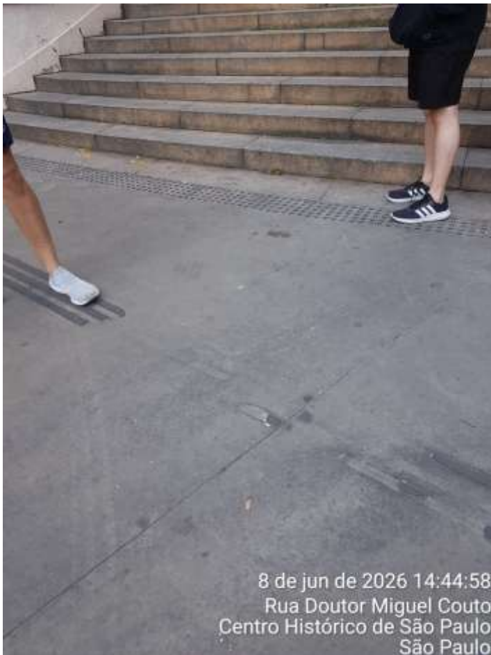
Falhas e/ou ausência do Piso Podotátil
