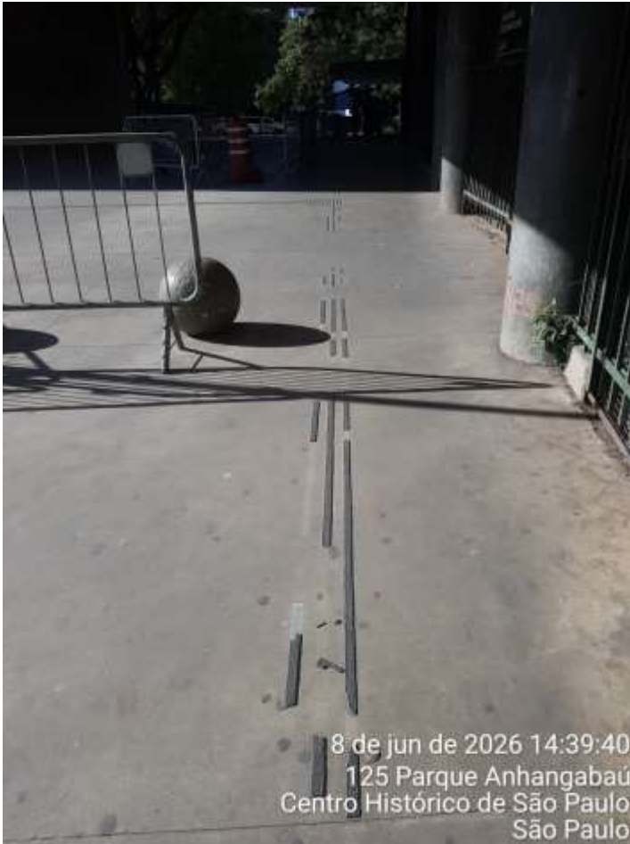
Falhas e/ou ausência do Piso Podotátil
