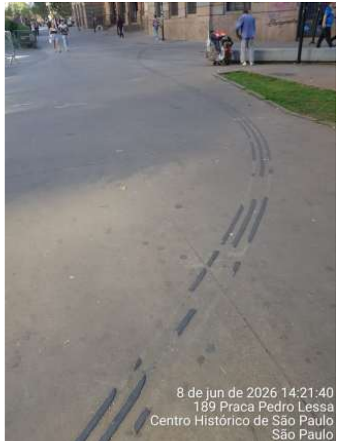
Falhas e/ou ausência do Piso Podotátil
