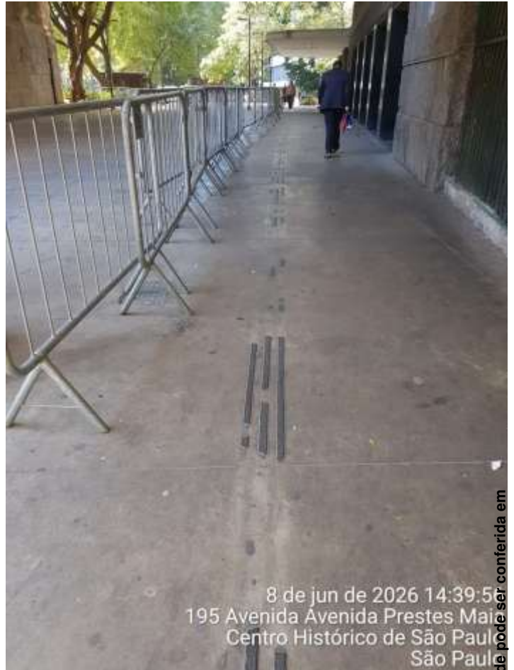
Falhas e/ou ausência do Piso Podotátil
