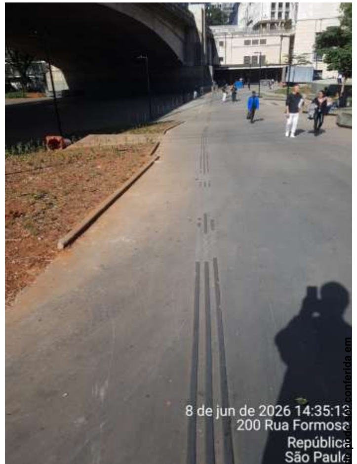
Falhas e/ou ausência do Piso Podotátil
