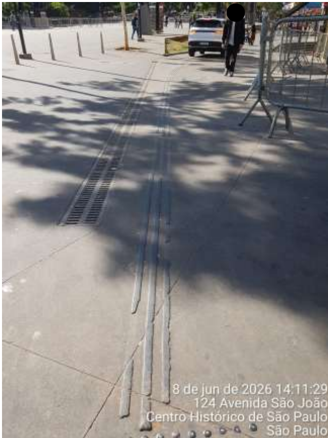
Falhas e/ou ausência do Piso Podotátil
