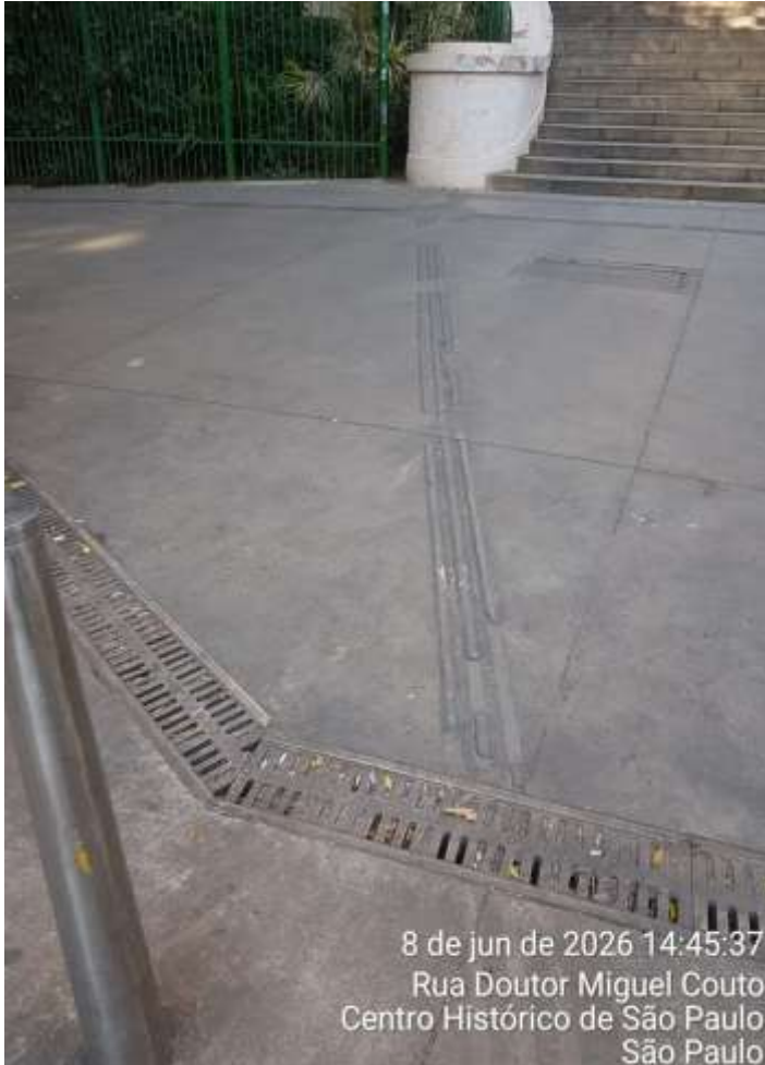
Falhas e/ou ausência do Piso Podotátil
