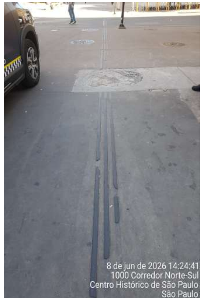
Falhas e/ou ausência do Piso Podotátil
