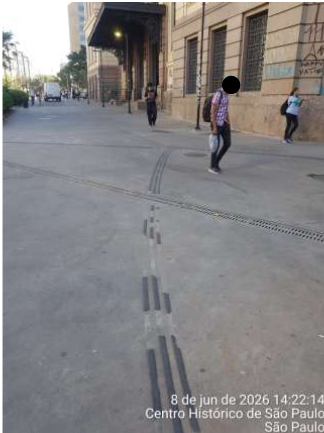
Falhas e/ou ausência do Piso Podotátil
