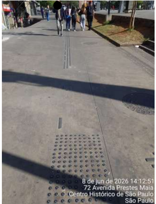
Falhas e/ou ausência do Piso Podotátil
