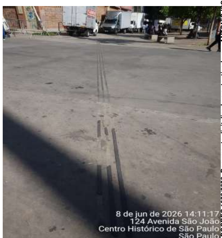
Falhas do Piso Podotátil
