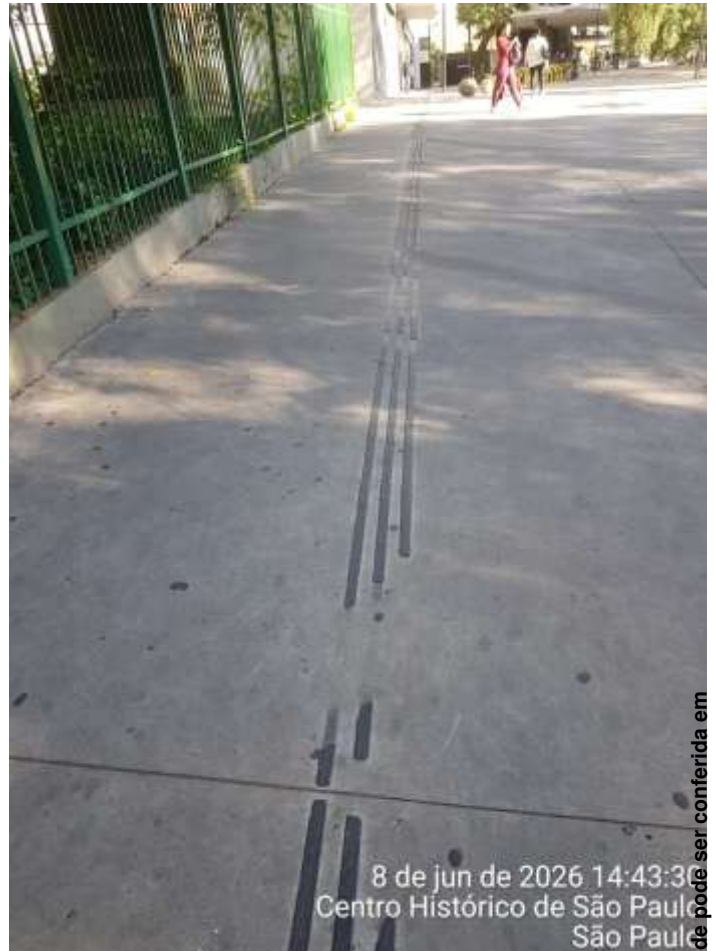
Falhas e/ou ausência do Piso Podotátil
