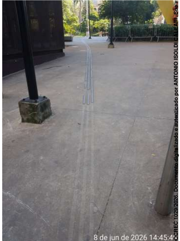
Falhas e/ou ausência do Piso Podotátil
