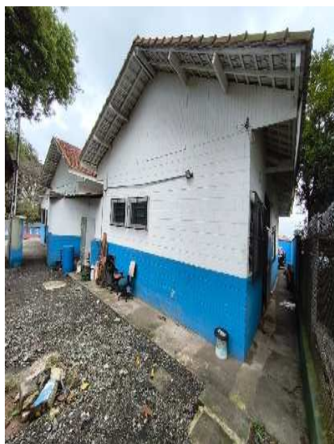
Foto 14: Lateral e fundo da unidade.
