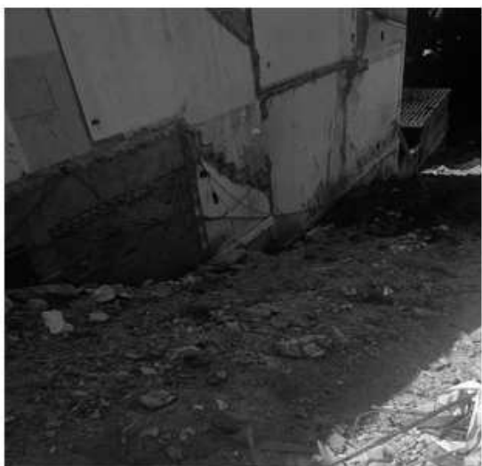
Foto 08. Local da demolição
