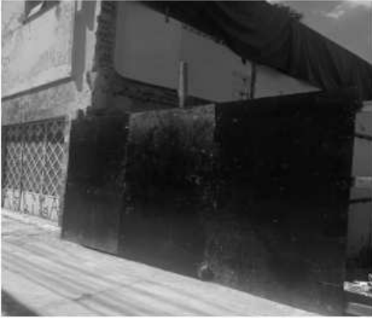
Foto 01. Frente do imóvel demolido
