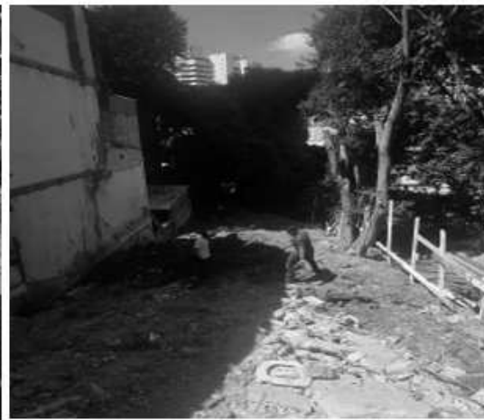
Foto 03. Imóvel 395 onde ocorre demolição
