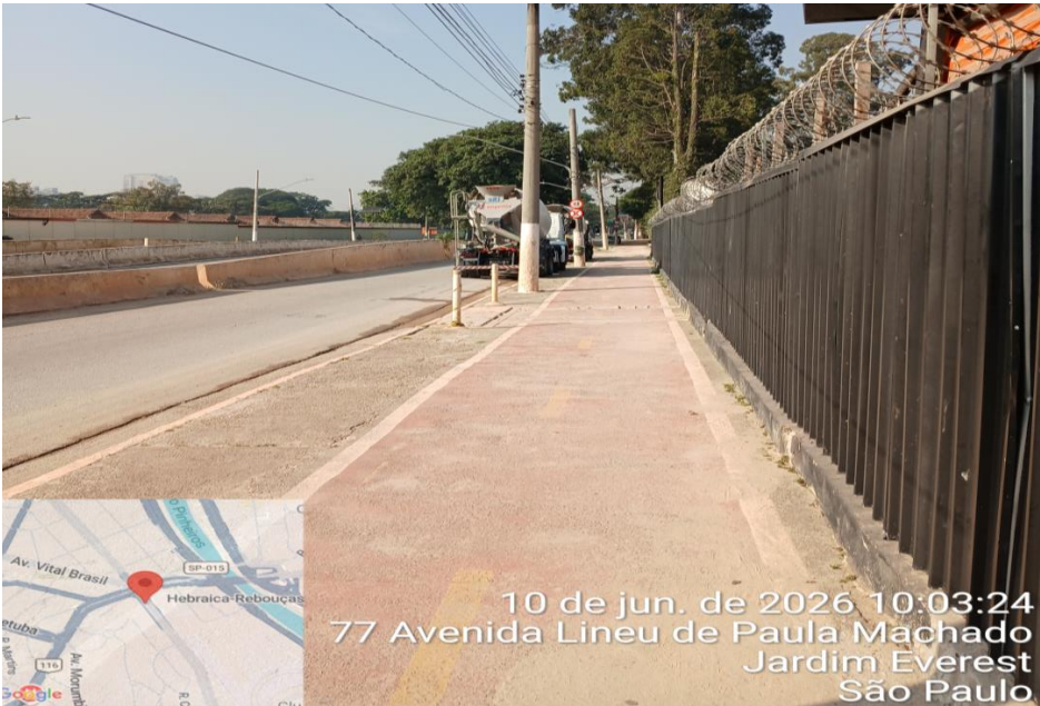
FOTO 1 – Avenida Lima de Paula Machado – Acesso ao túnel
