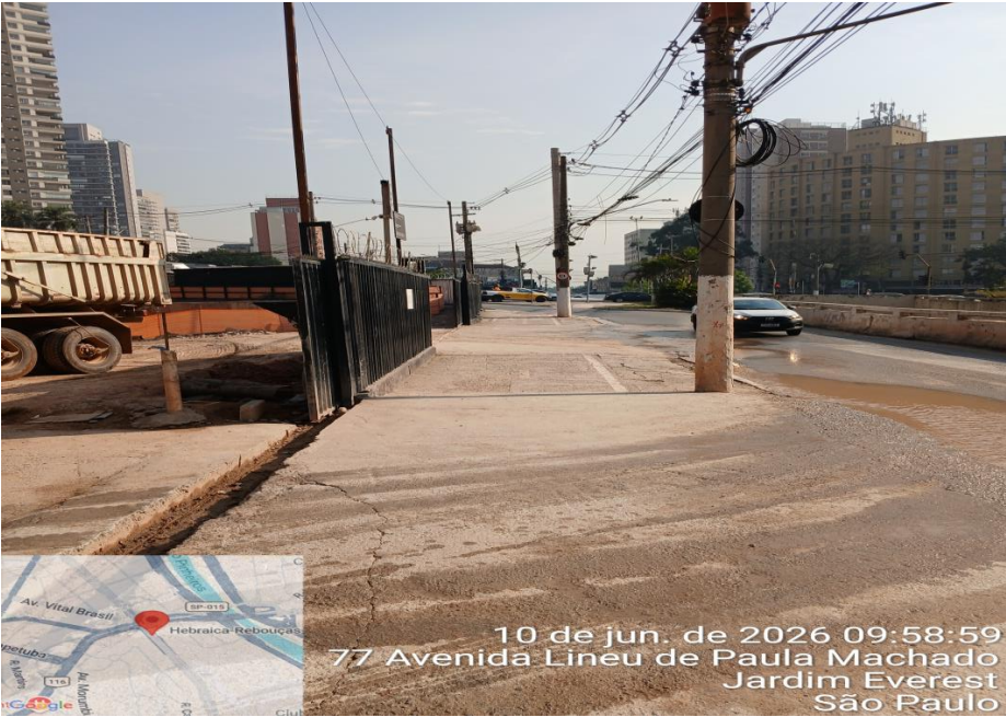
FOTO 3 – Avenida Lima de Paula Machado – Acesso ao túnel
