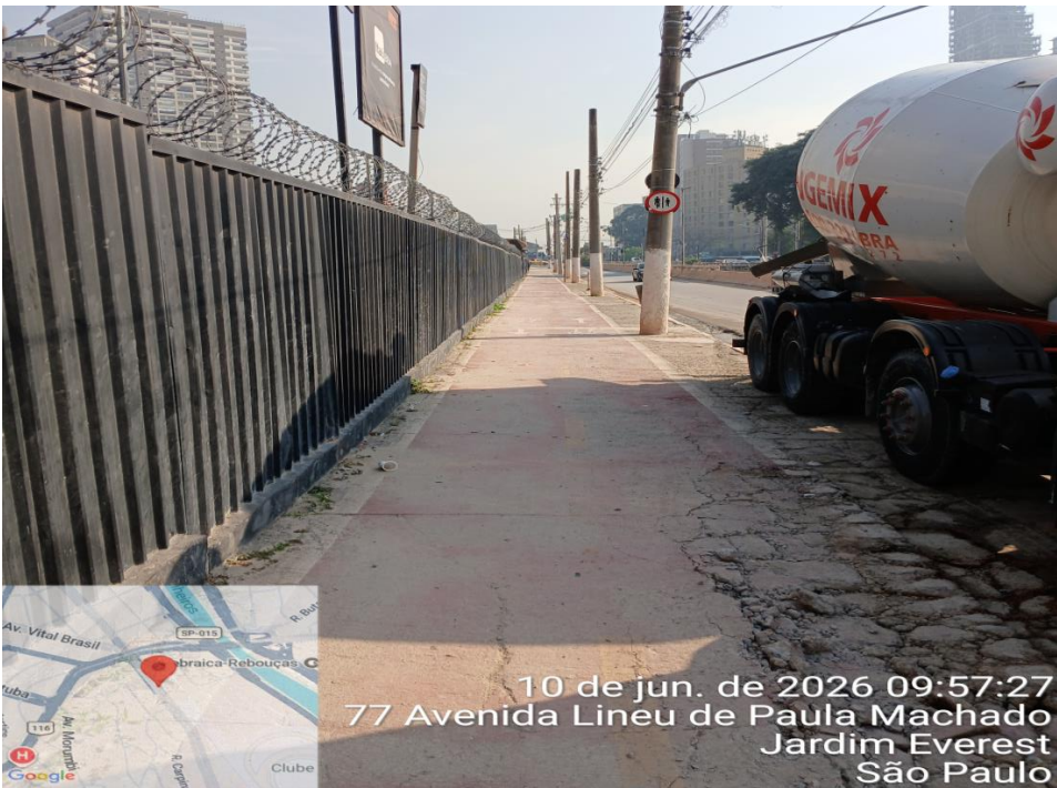
FOTO 2 – Avenida Lima de Paula Machado – Acesso ao túnel
