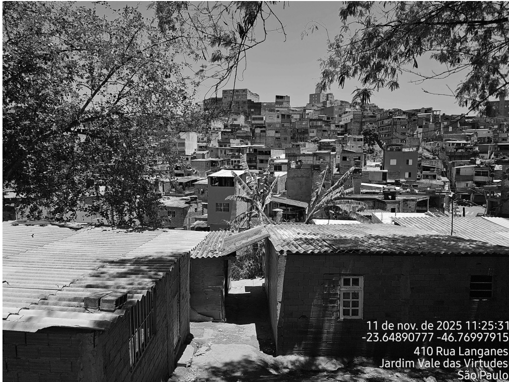
Figura 10 -Detalhe de região localizada nas proximidades do ponto 3 (SEI 118660761).
