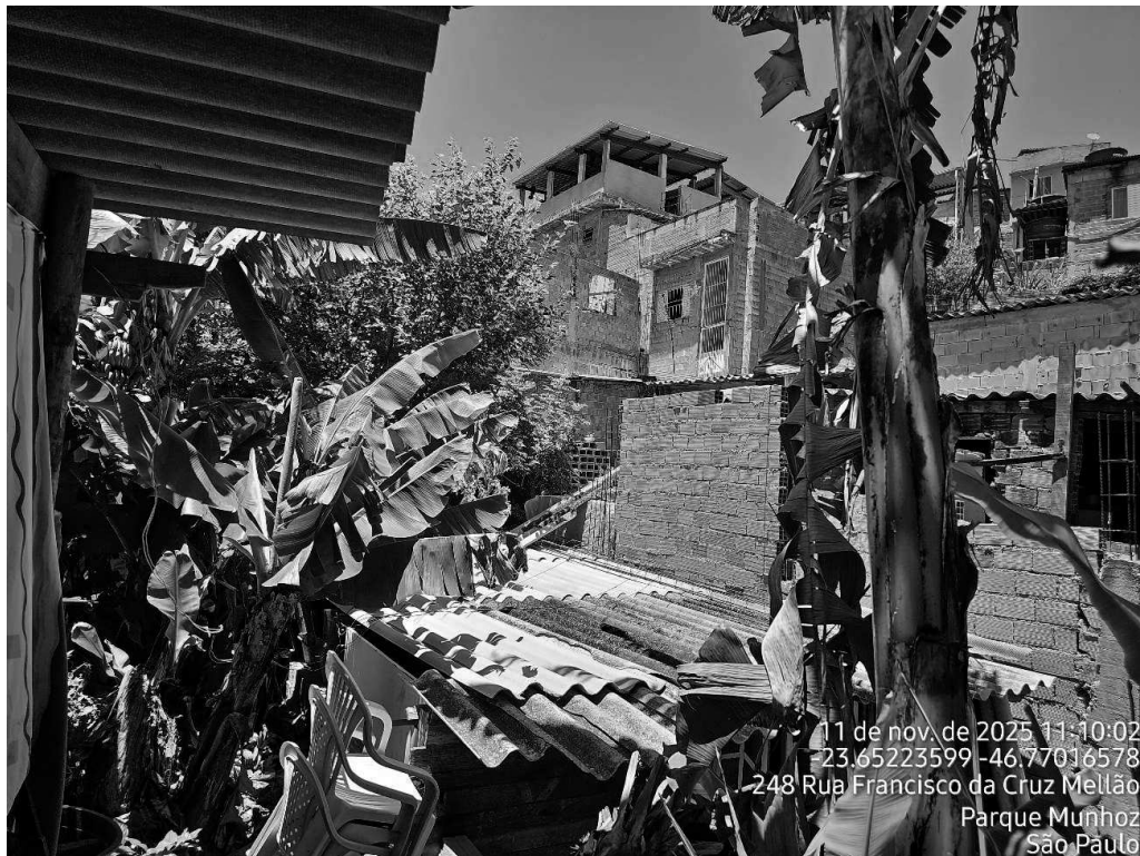
Figura 3-Detalhe de região localizado nas proximidades do ponto 1 (SEI 118660761).
