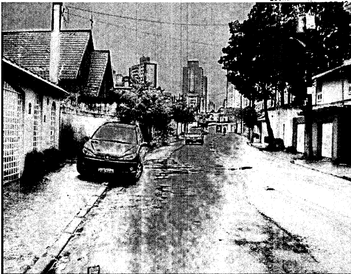
Figura 13: Situação da vizinhança, antes da implantação do empreendimento ROSSI - Nov. 2009
