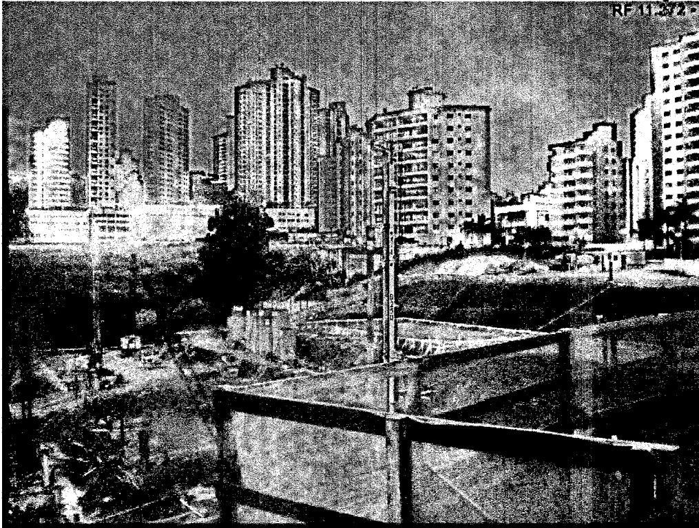
Figura 14: Canteiro de obra, objeto de recomendações na aprovação do empreendimento pela SVMA – Nov. 2009.
