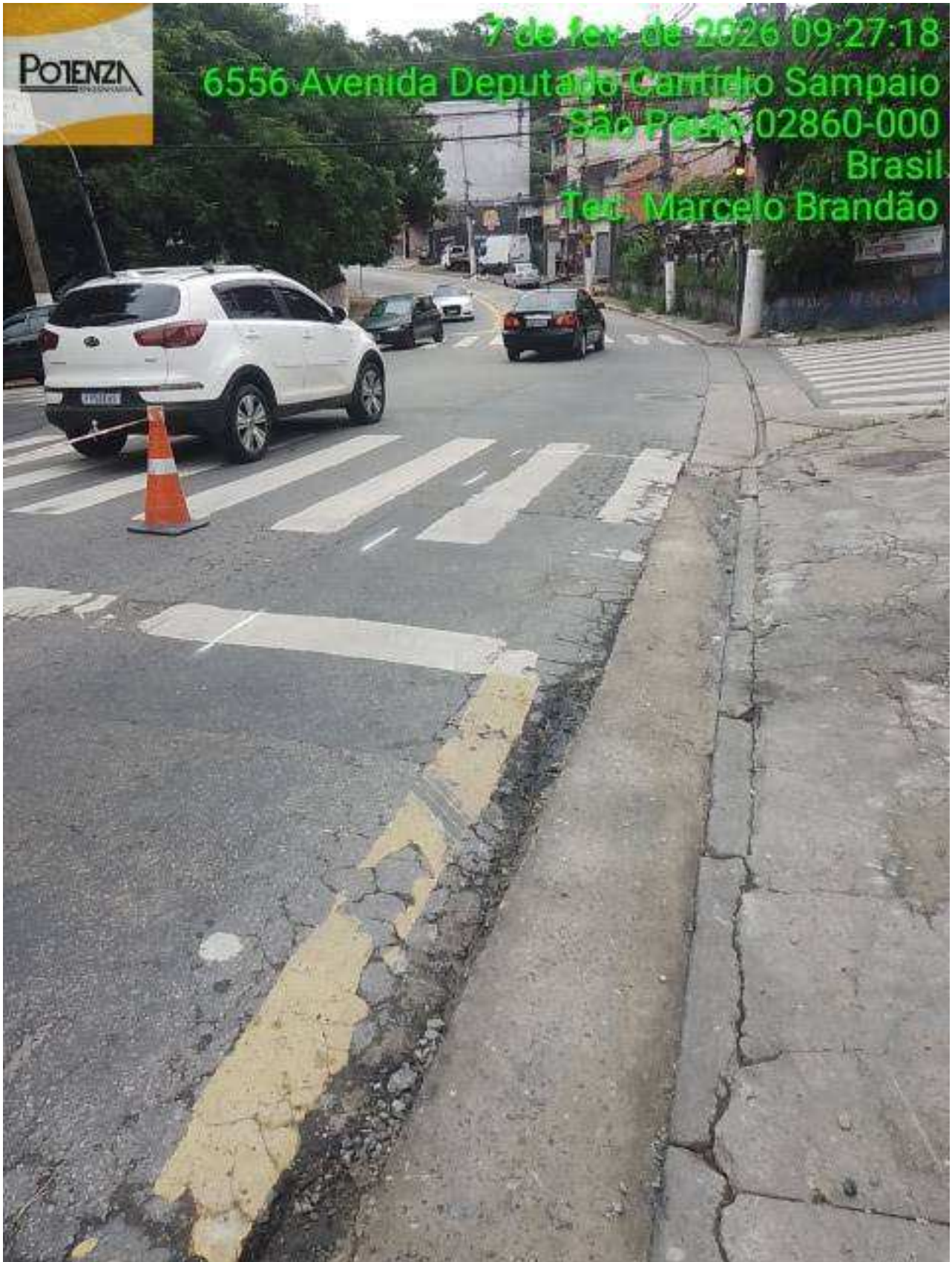
10 | Demarcação da caixa: Item de OS Origem: 15107518 - (Foto Capturada Em: 08/02/26 19:31, Por: mxintadm)
