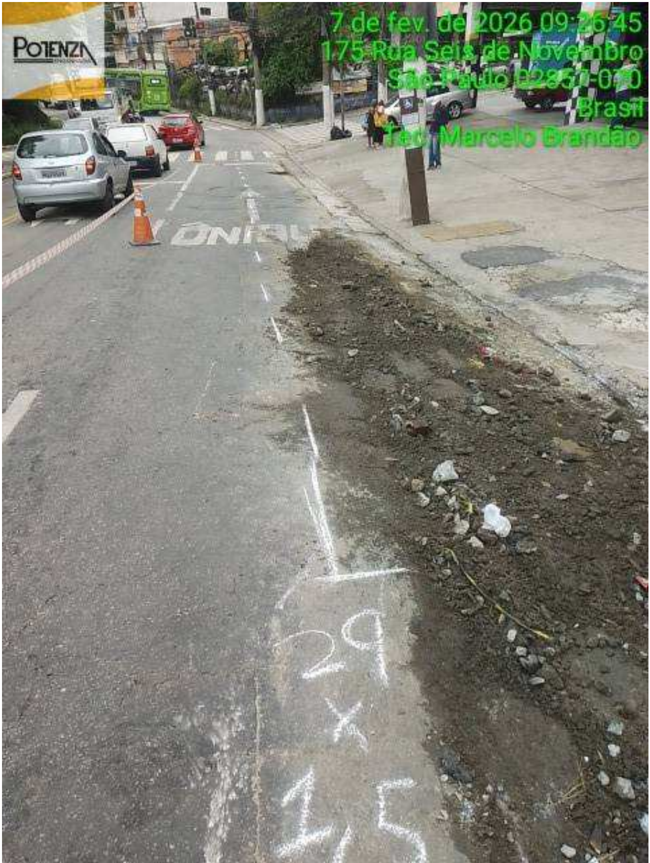
2 | Demarcação da caixa: Item de OS Origem: 15107518 - (Foto Capturada Em: 08/02/26 19:31, Por: mxintadm)
