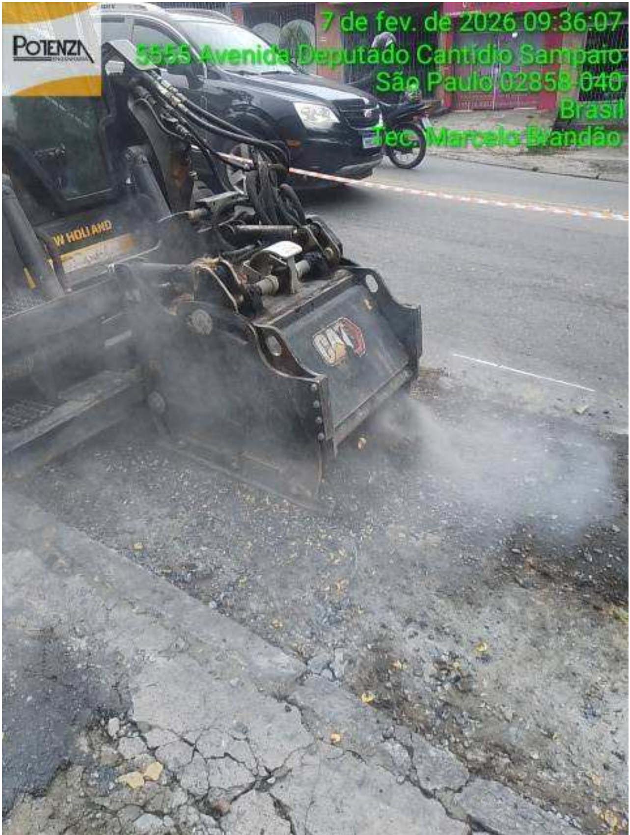
13 | RECORTE → Fresadora e serra clipper: Item de OS Origem: 15107518 - (Foto Capturada Em: 08/02/26 19:32, Por: mxintadm)
