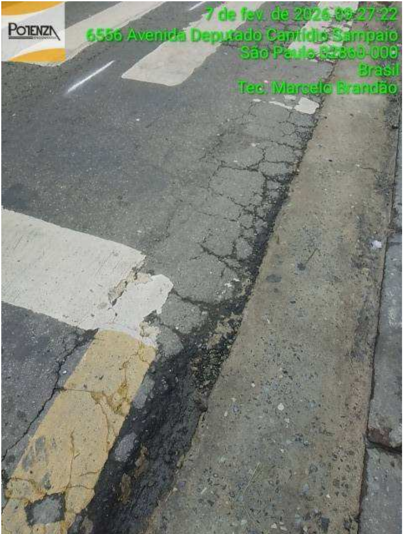
11 | Demarcação da caixa: Item de OS Origem: 15107518 - (Foto Capturada Em: 08/02/26 19:31, Por: mxintadm)
