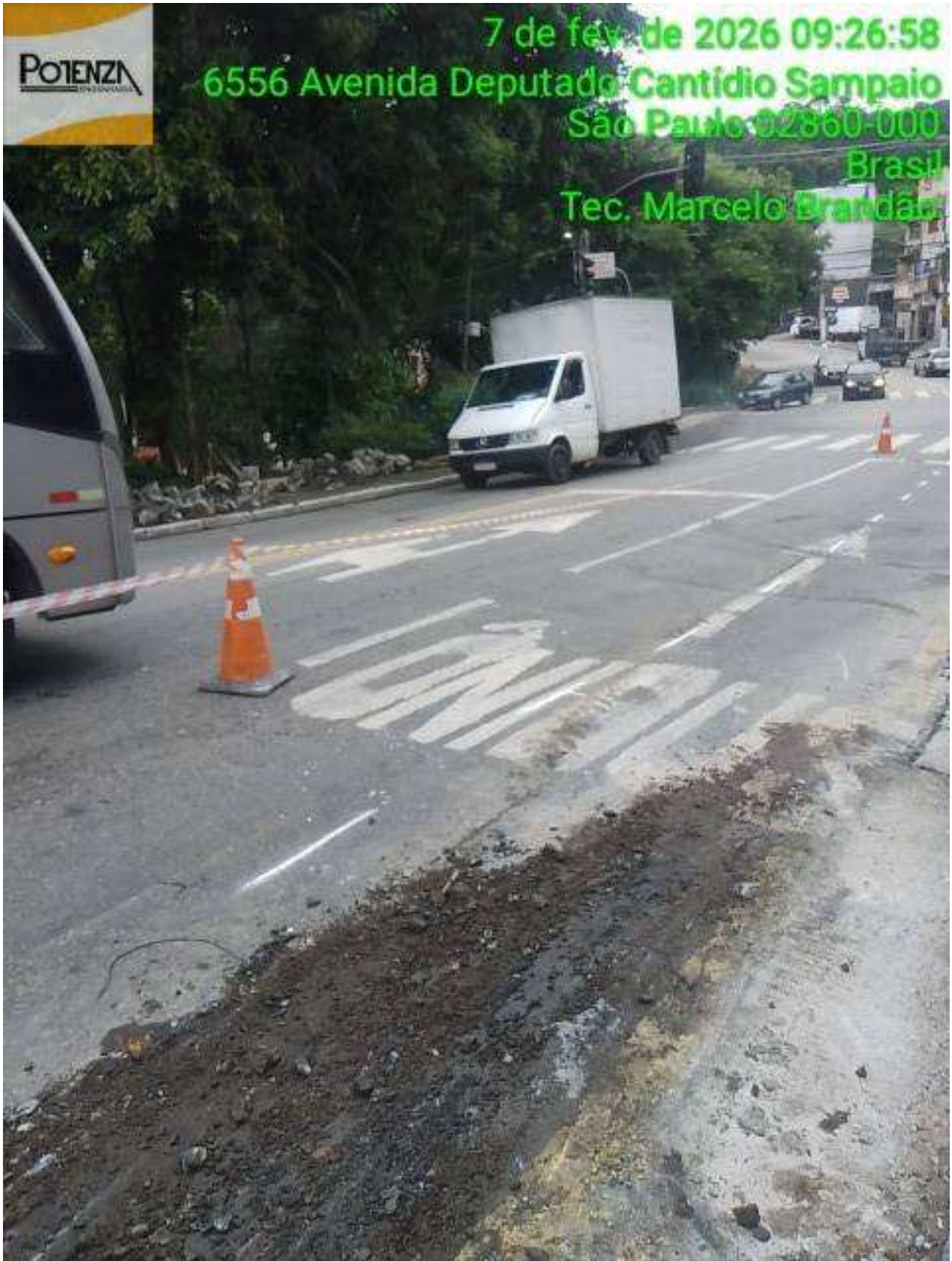
6 | Demarcação da caixa: Item de OS Origem: 15107518 - (Foto Capturada Em: 08/02/26 19:31, Por: mxintadm)
