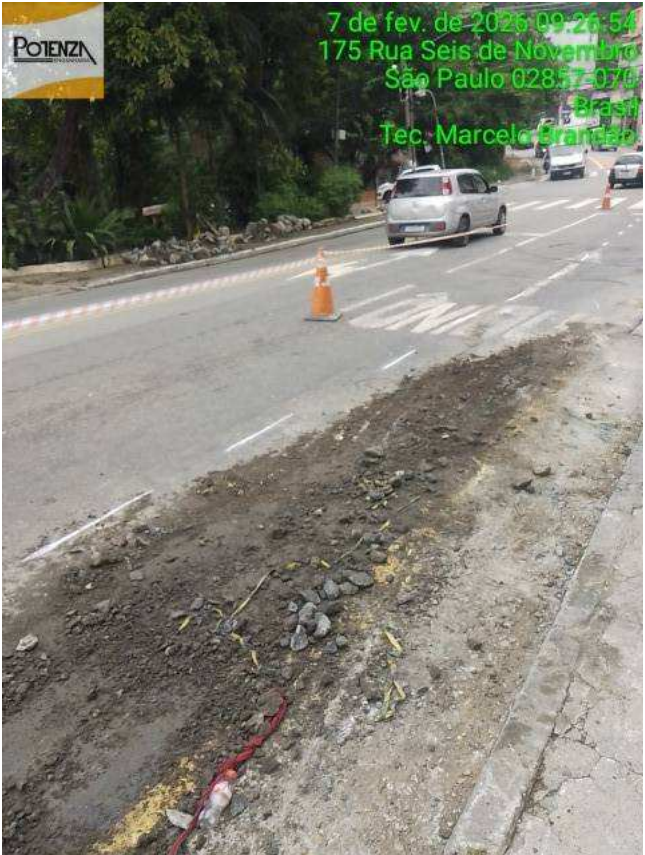
5 | Demarcação da caixa: Item de OS Origem: 15107518 - (Foto Capturada Em: 08/02/26 19:31, Por: mxintadm)
