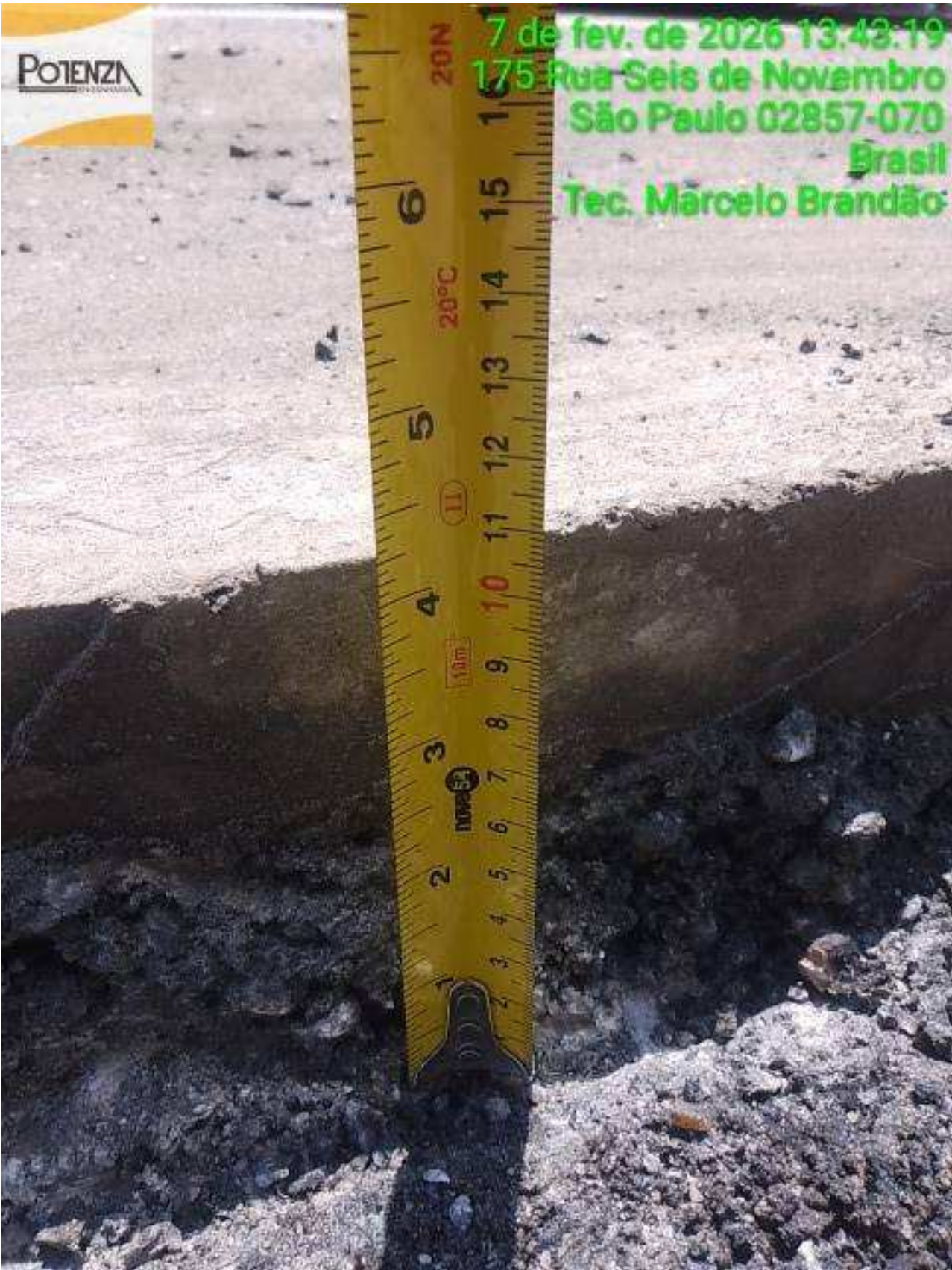
5 | APLICAÇÃO → Aplicação da Emulsão: Item de OS APLICAÇÃO DE MASSA DA CONCORDÂNCIA Origem: 15107519 - (Foto Capturada Em: 08/02/26 19:39, Por: mxintadm)
