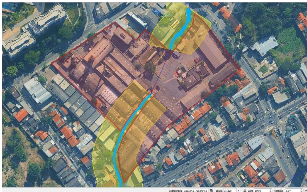
Figura 1 - Área de Preservação Permanente destacada em amarelo, com delimitação de aproximadamente 30 metros, conforme determinado pela legislação vigente, para o “Córrego Poli”, indicado em massas d'água azul-claro. Trechos do Córrego canalizados em galeria fechada destacados em linha tracejada azul-escuro. Área do lote em vermelho.
