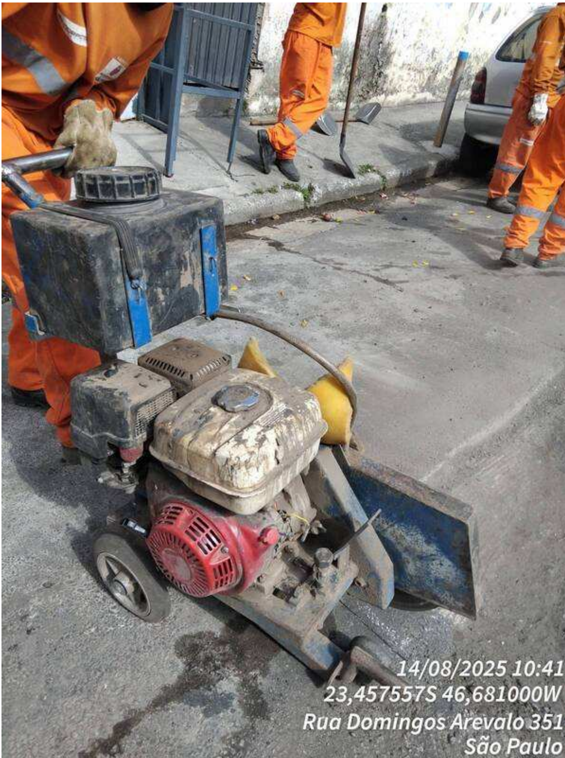
5 | RECORTE → Fresadora e serra clipper. Item de OS Origem: 13328385 - (Foto Capturada Em: 14/08/25 14:41, Por: mxintadm)
