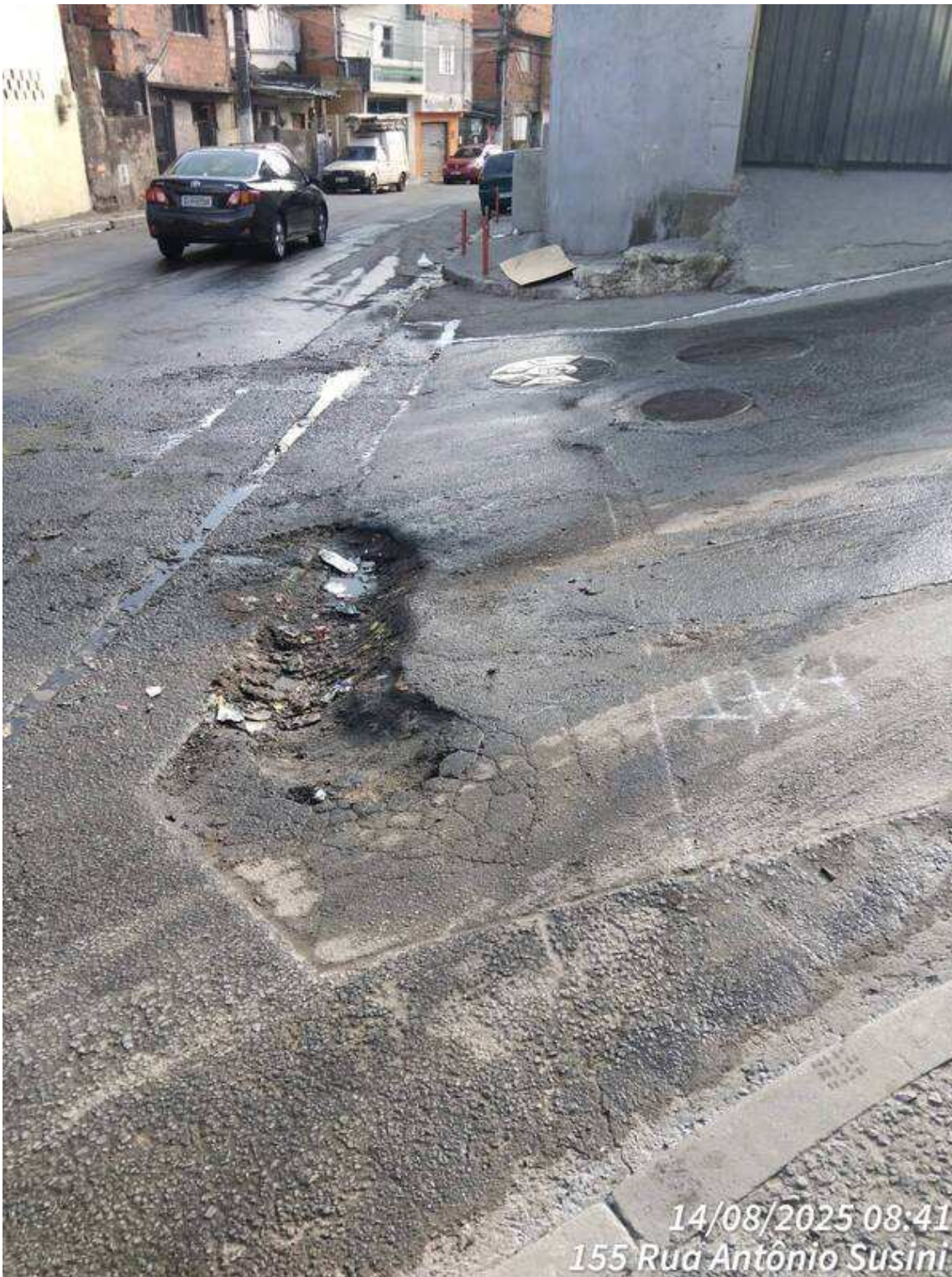
3 | Demarcação da caixa: Item de OS Origem: 13328385 - (Foto Capturada Em: 14/08/25 12:12, Por: mxintadm)
