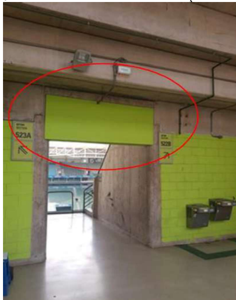
Figura 3 – Vomitério modificado com redução da altura livre
