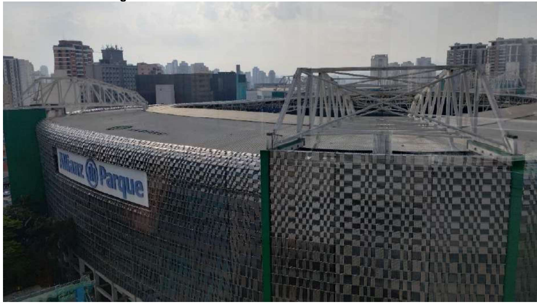
Figura 27 – Detalhe das fachadas em folha metálica vazada.
