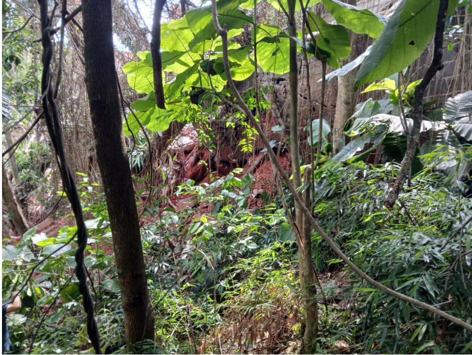
Foto 5: Vista inclinada do deslizamento, observa-se trecho do muro rompido com rachaduras.
