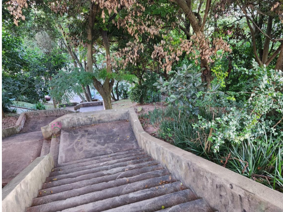
Foto 9: Escadaria que conecta a R. Praça Santo Epifânio com a R. José Piragibe (vista do topo da praça).
