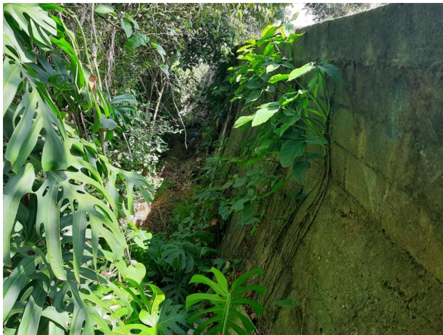
Foto 2: Talude com muro de contenção abaixo do nível da Rua Praça Santo Epifânio.
