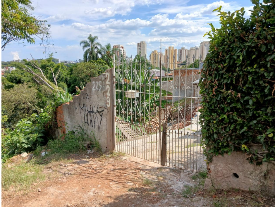
Foto 1: Portão de acesso à residência localizada no topo da encosta: R. Praça Santo Epifânio, 225/229.
