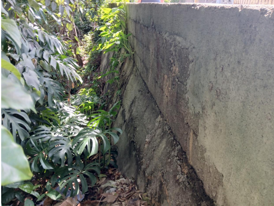
Foto 11: Detalhe da parte de trás do talude com muro de contenção abaixo do nível da Rua Praça Santo Epifânio.
