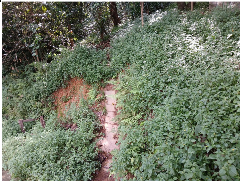
Foto 15: Detalhe do sistema de drenagem superficial próximo a base da escadaria da praça.
