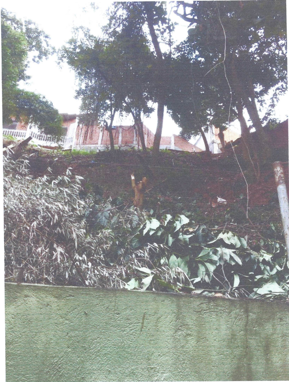
(imagem F) Junho de 2021: árvores cortadas, toda as áreas roçadas com o corte de toda a vegetação em crescimento, de porte intermediário e rasteira
