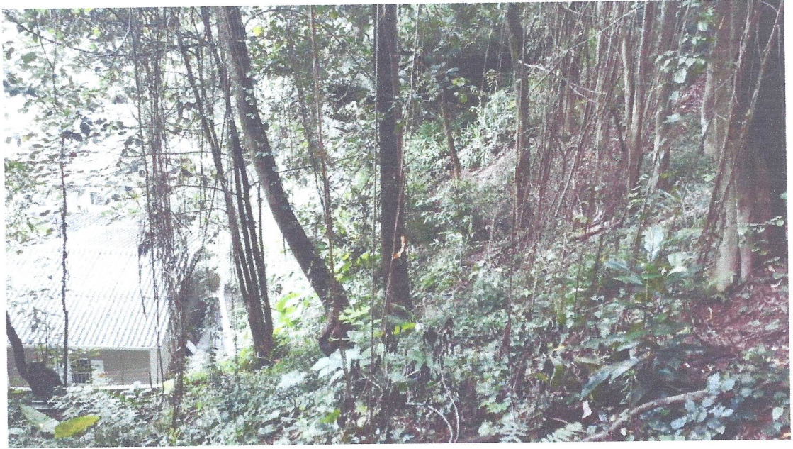
(imagem E) Residências sob risco de desmoronamento do muro de arrimo aterrado, construído em terreno particular (parte inferior esquerda)
