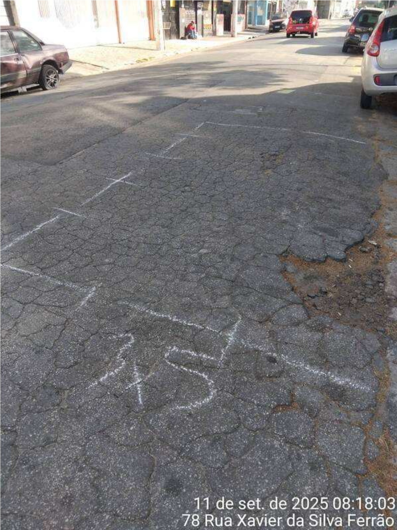
3 | Demarcação da caixa: Item de OS Origem: 13934001 - (Foto Capturada Em: 11/09/25 20:55, Por: mxintadm)
