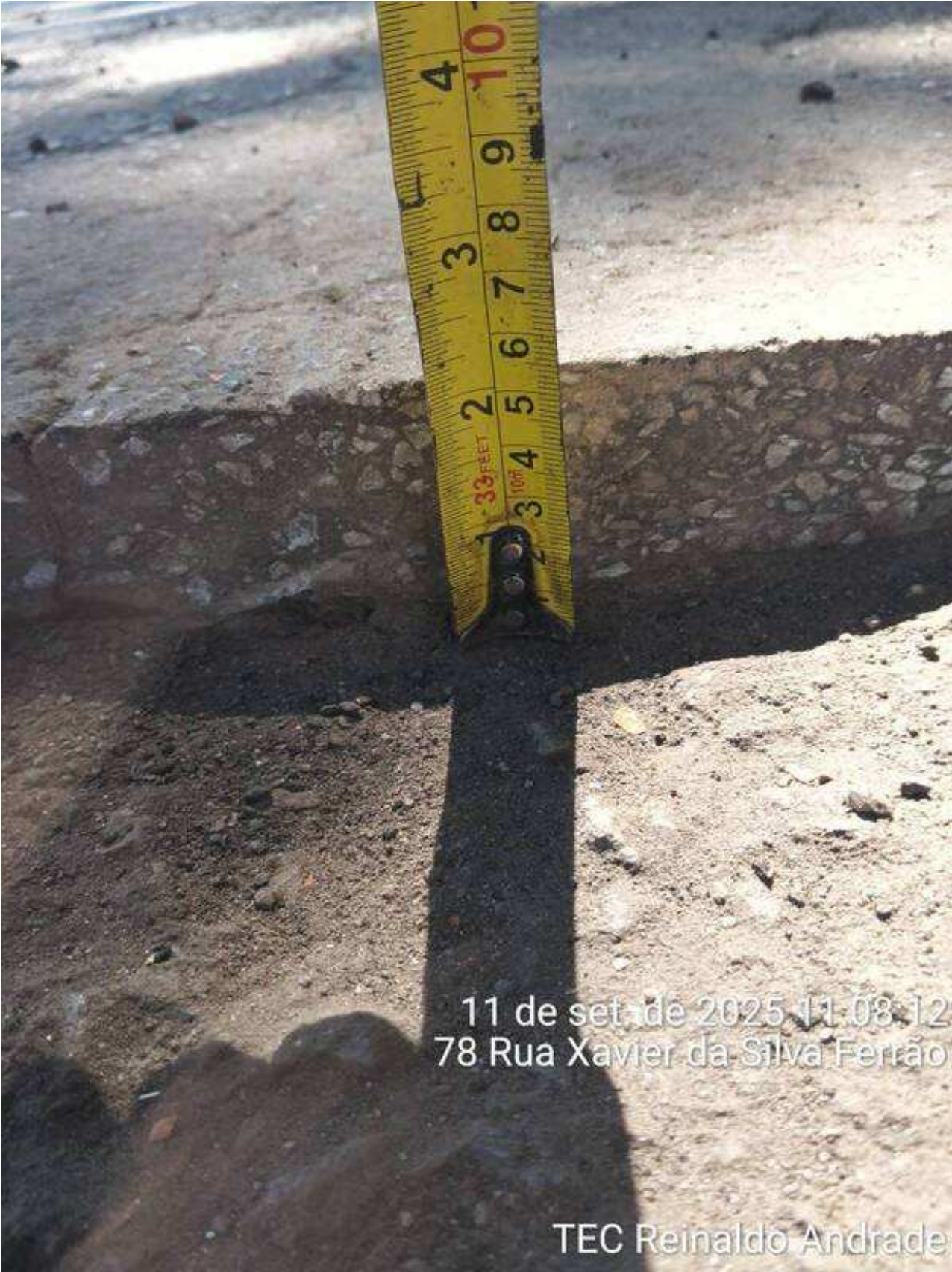
9 | PROFUNDIDADE → Registro da profundidade mais funda da caixa com uso da trena: Item de OS APLICAÇÃO DE MASSA Origem: 13934002 - (Foto Capturada Em: 11/09/25 22:37, Por: mxintadm)
