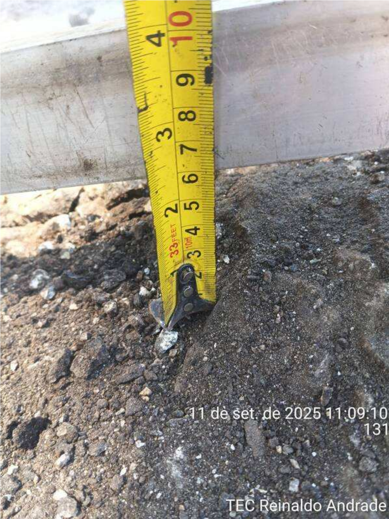
10 | APLICAÇÃO → Aplicação da Emulsão: Item de OS Origem: 13870897 - (Foto Capturada Em: 11/09/25 22:34, Por: mxintadm)
