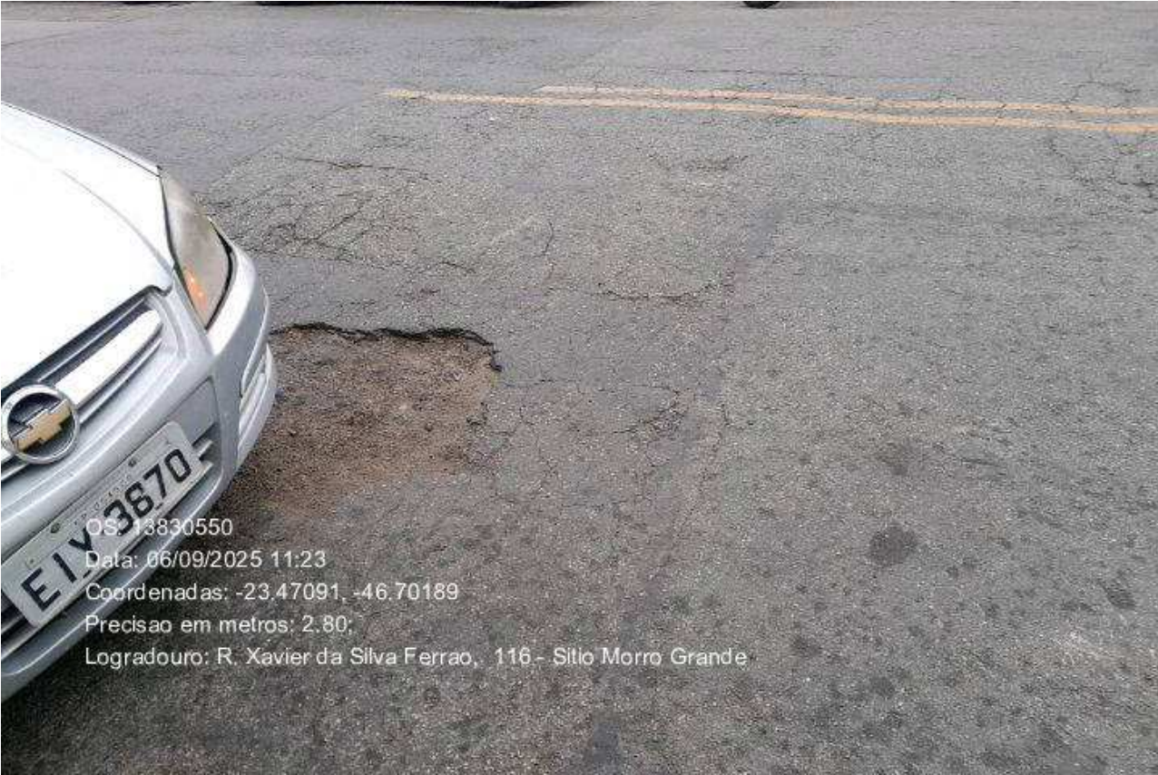
3 | OS TAPA BURACO CONSERVACAO PAVIMENTO Origem: 13830550 - (Foto Capturada Em: 06/09/25 11:23, Por: Tiago Soares Pompeu)
