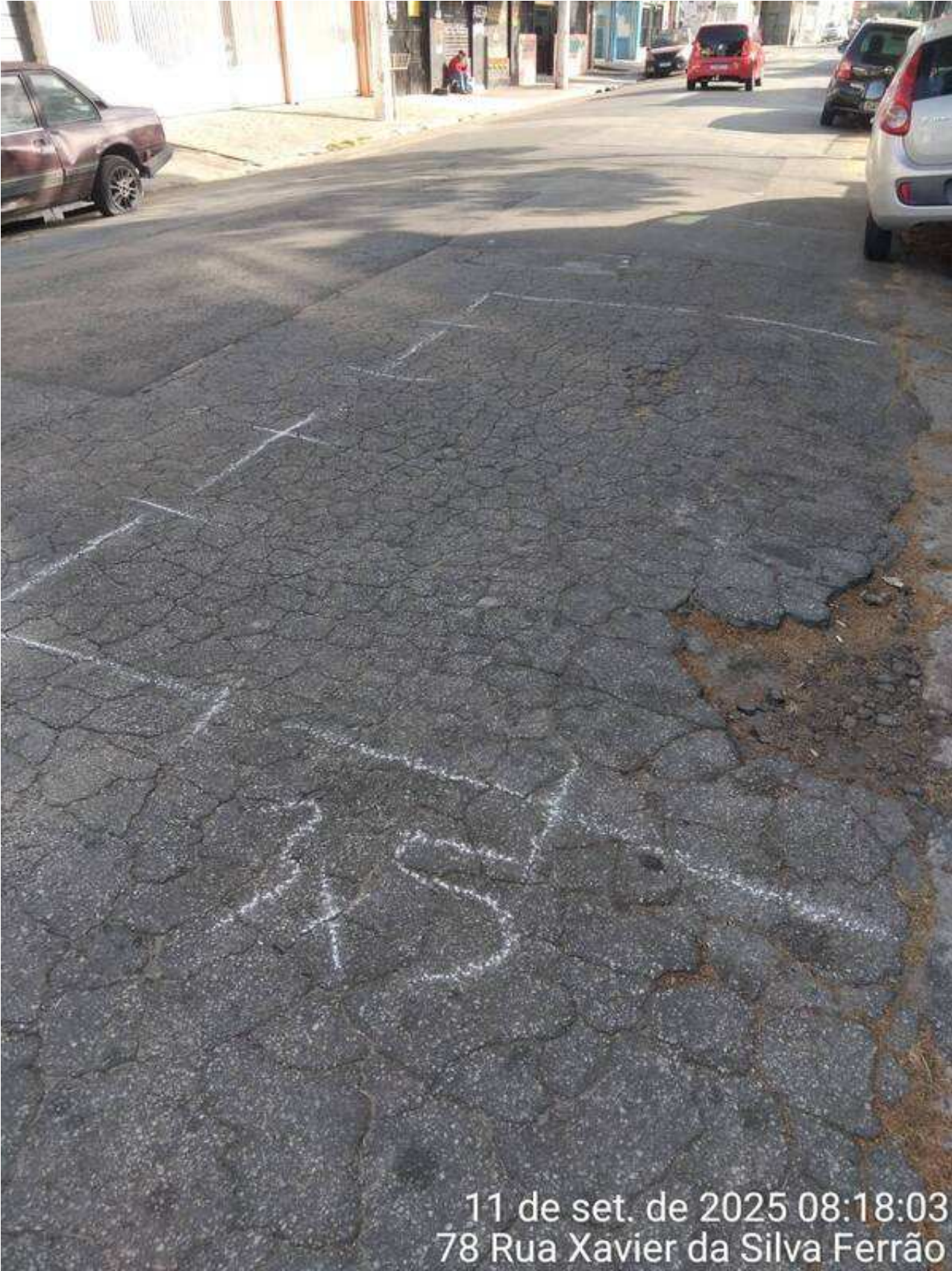
4 | RECORTE → Fresadora e serra clipper: Item de OS Origem: 13934001 - (Foto Capturada Em: 11/09/25 20:56, Por: mxintadm)
