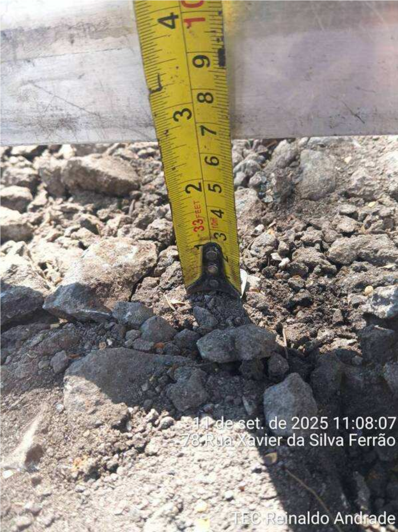
10 | APLICAÇÃO → Aplicação da Emulsão: Item de OS APLICAÇÃO DE MASSA Origem: 13934002 - (Foto Capturada Em: 11/09/25 22:38, Por: mxintadm)
