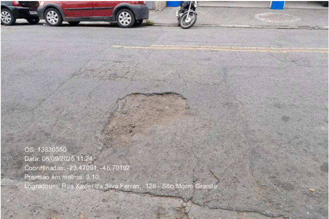
5 | OS TAPA BURACO CONSERVACAO PAVIMENTO Origem: 13830550 - (Foto Capturada Em: 06/09/25 11:25, Por: Tiago Soares Pompeu)
