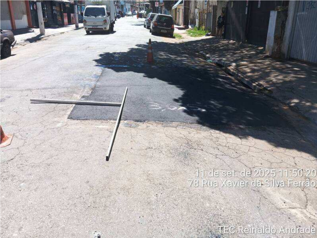
7 | COMPACTAÇÃO → Base: Item de OS APLICAÇÃO DE MASSA Origem: 13934002 - (Foto Capturada Em: 11/09/25 22:37, Por: mxintadm)
