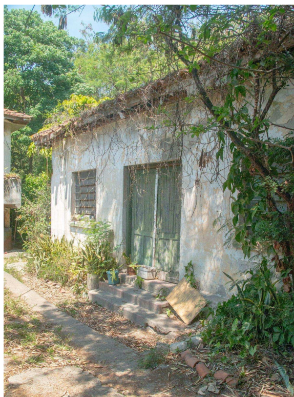
Figura 04 - Registros in loco do casarão lateral. Fonte: Gabinete Nabil Bonduki, em 30 de setembro de 2025.
