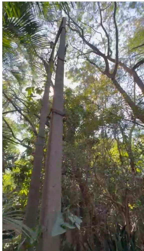
Figura 06 - Registros in loco do poste e alinhamento de energia. Fonte: Gabinete Nabil Bonduki, em 30 de setembro de 2025.
