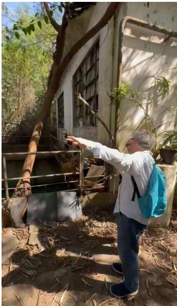
Figura 05 - Registros in loco do reservatório e laboratório de análise das águas. Fonte: Gabinete Nabil Bonduki, em 30 de setembro de 2025.
