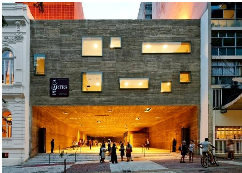
(Figura 4: Vão livre ligando a Av. São João ao centro do trecho que liga a Rua Conselheiro Crispiniano à Rua Formosa).
