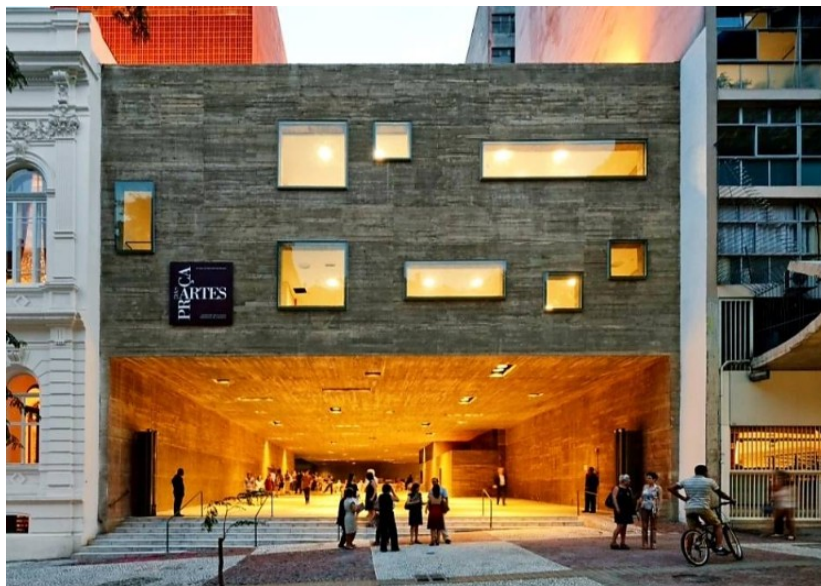
(Figura 4: Vão livre ligando a Av. São João ao centro o trecho que liga a Rua Conselheiro Crispiniano à Rua Formosa).
