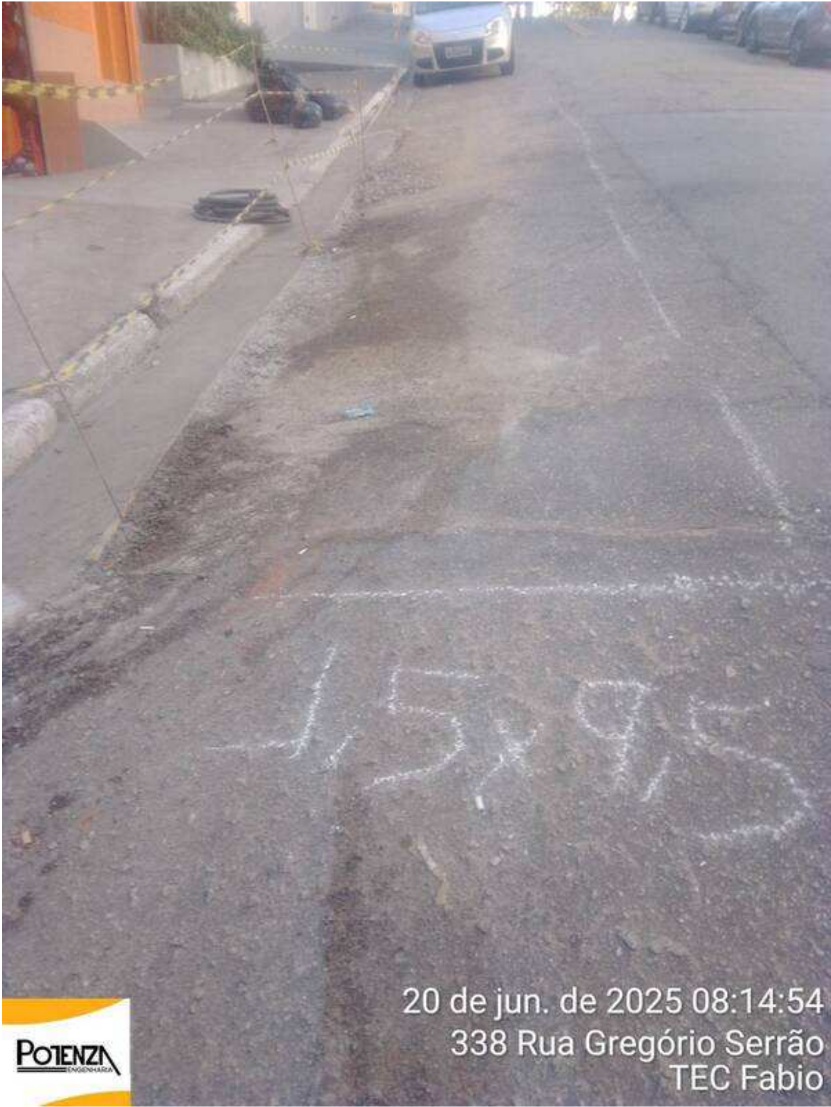
5 | RECORTE → Fresadora e serra clipper: Item de OS Origem: 12680290 - (Foto Capturada Em: 23/06/25 07:11, Por: mxintadm)
