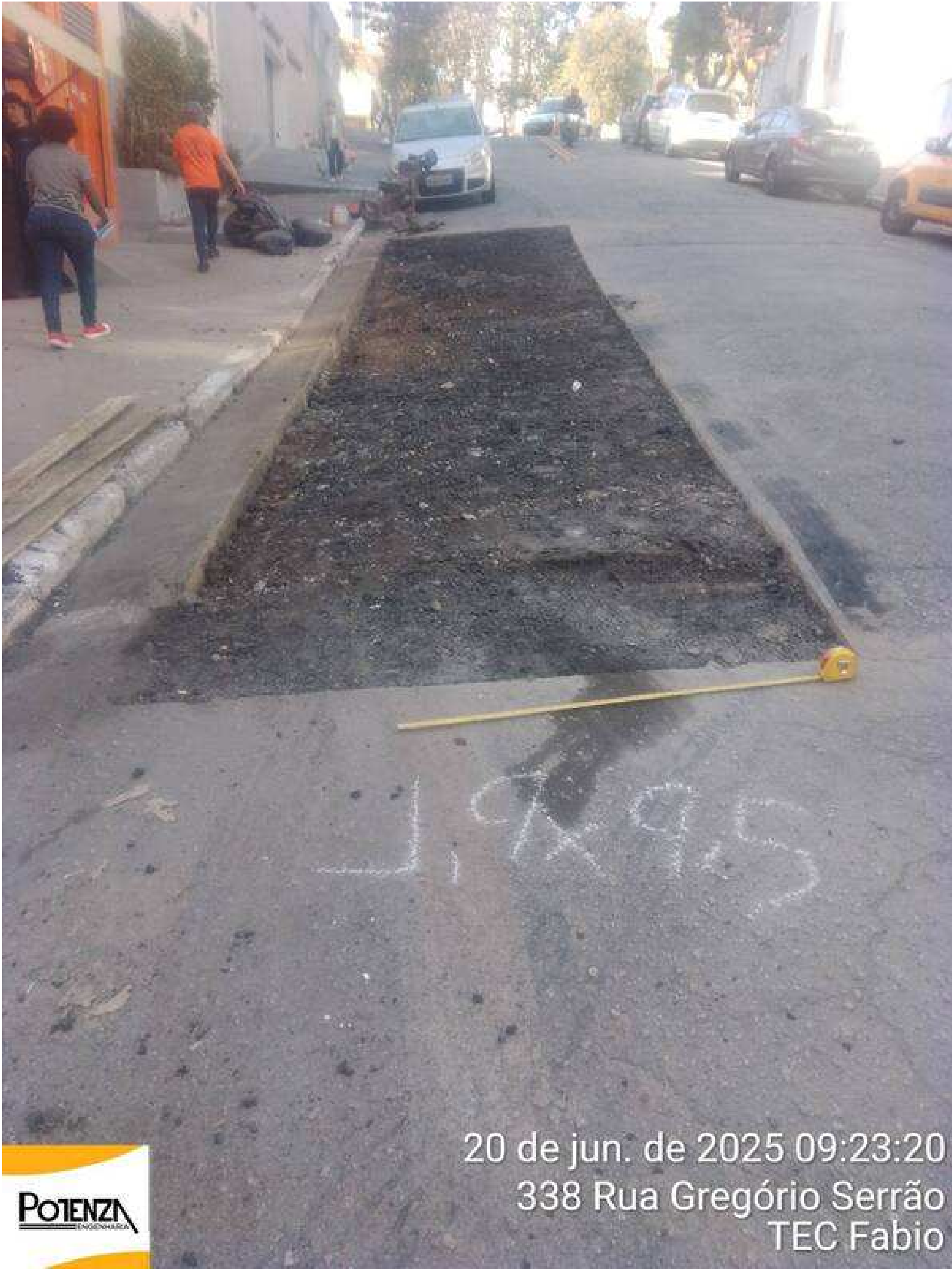
2 | PROFUNDIDADE → Registro da profundidade mais funda da caixa com uso da trena: Item de OS APLICAÇÃO DE MASSA DA CONCORDÂNCIA Origem: 12680291 - (Foto Capturada Em: 24/06/25 03:15, Por: mxintadm)
