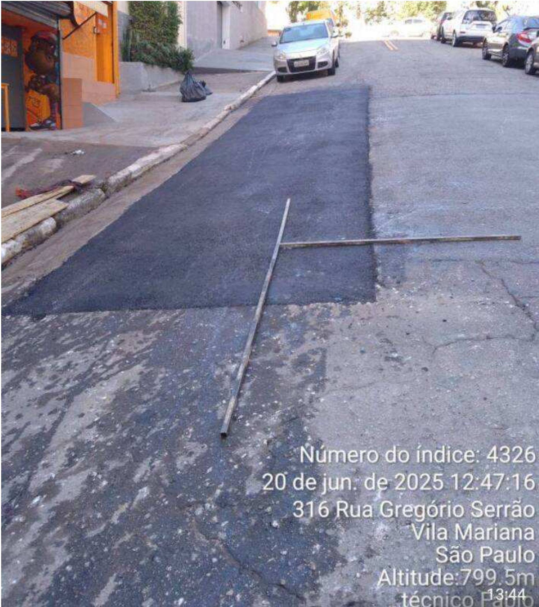
11 | ACABAMENTO → Nível com régua após caixa pronta: Item de OS APLICAÇÃO DE MASSA DA CONCORDÂNCIA Origem: 12680291 - (Foto Capturada Em: 24/06/25 03:20, Por: mxintadm)
