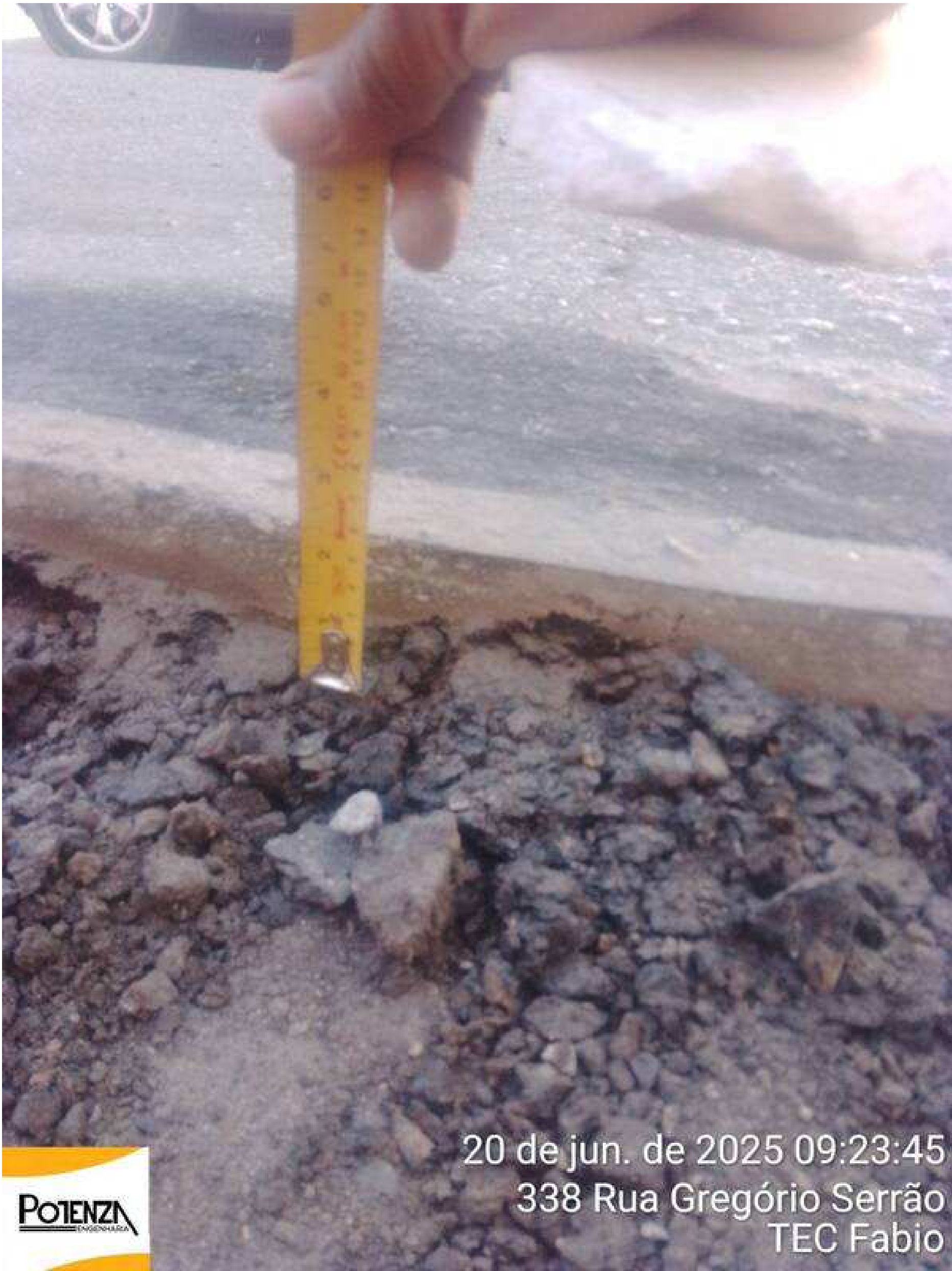
3 | PROFUNDIDADE → Registro da profundidade mais rasa da caixa com uso da trena: Item de OS APLICAÇÃO DE MASSA DA CONCORDÂNCIA Origem: 12680291 - (Foto Capturada Em: 24/06/25 03:15, Por: mxintadm)
