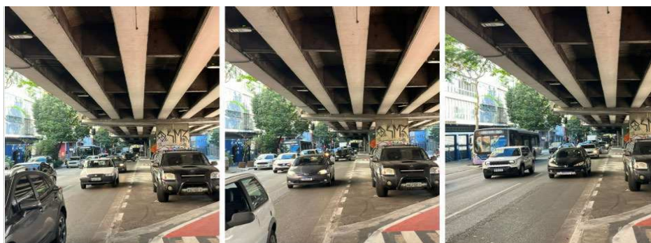
Figura 3 - operação dos ônibus no trecho do estacionamento. Fonte: SPTTrans/DT/SPA/GTU (30/05/2025).
