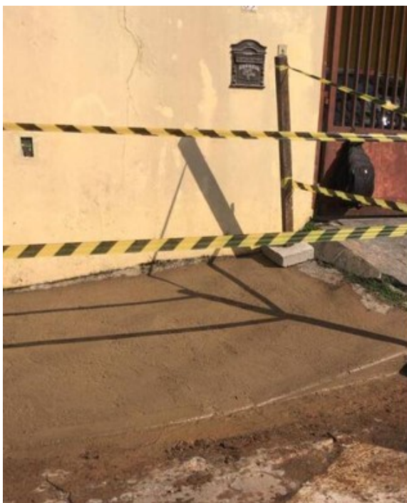
OS 7697087 – CONSERVAÇÃO DE LOGRADOUROS PÚBLICOS RUA DOMINGO DE GOIS – RAMPAS DE ACESSIBILIDADE
