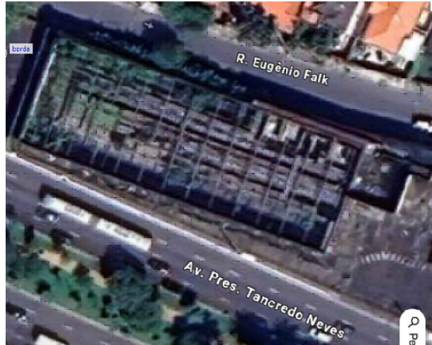
Imóvel a ser recuperado ou demolido
