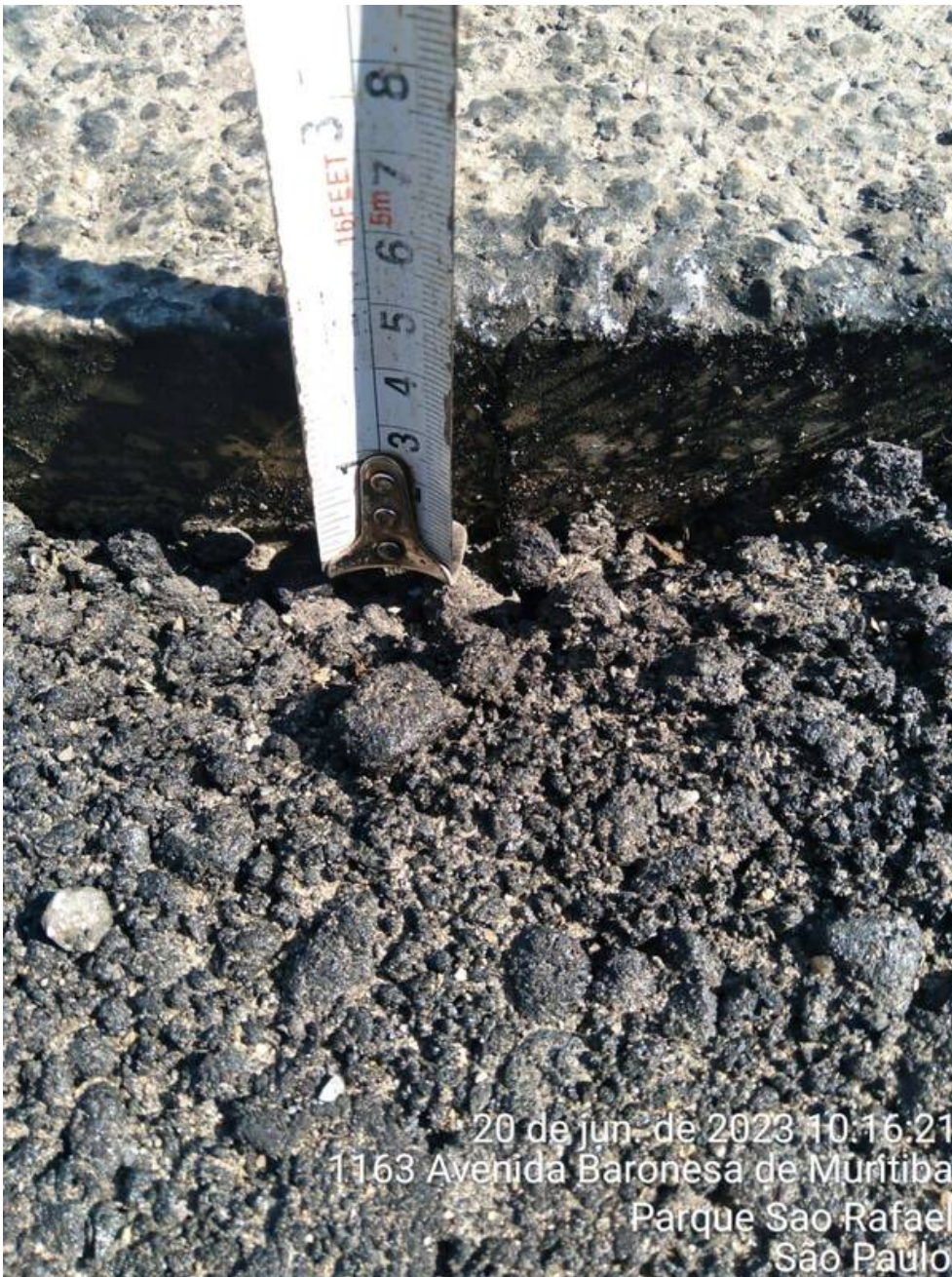
10 | ACABAMENTO → IRRE. DA VIA (CAIXA PRONTA): Item de OS APLICAÇÃO DE MASSA DA CONCORDÂNCIA Origem: 7569308 - (Foto Capturada Em: 21/06/23 11:05, Por: mxintadm)
