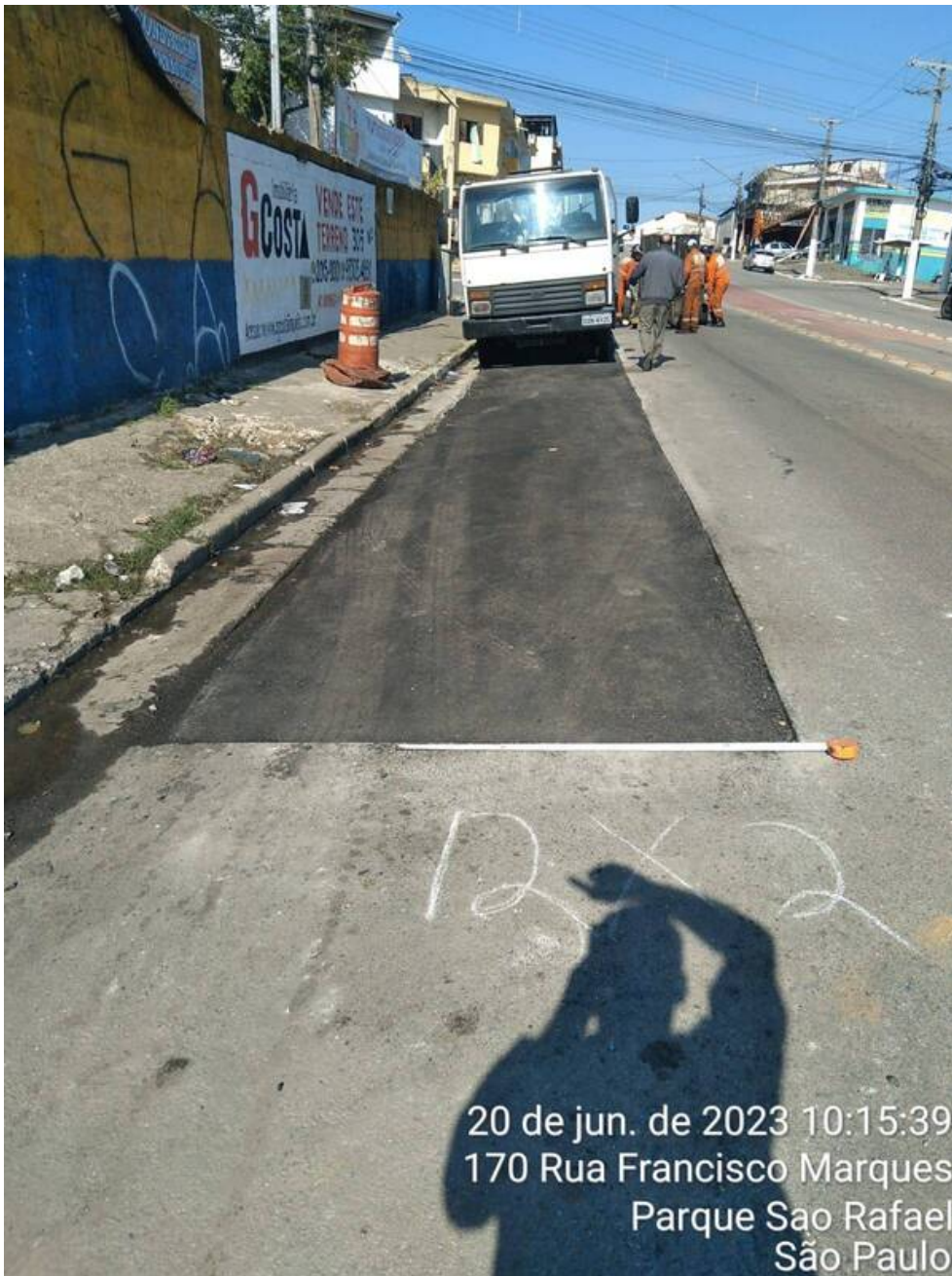
12 | ACABAMENTO → IRRE. DA VIA (CAIXA PRONTA): Item de OS APLICAÇÃO DE MASSA DA CONCORDÂNCIA Origem: 7569308 - (Foto Capturada Em: 21/06/23 11:05, Por: mxintadm)
