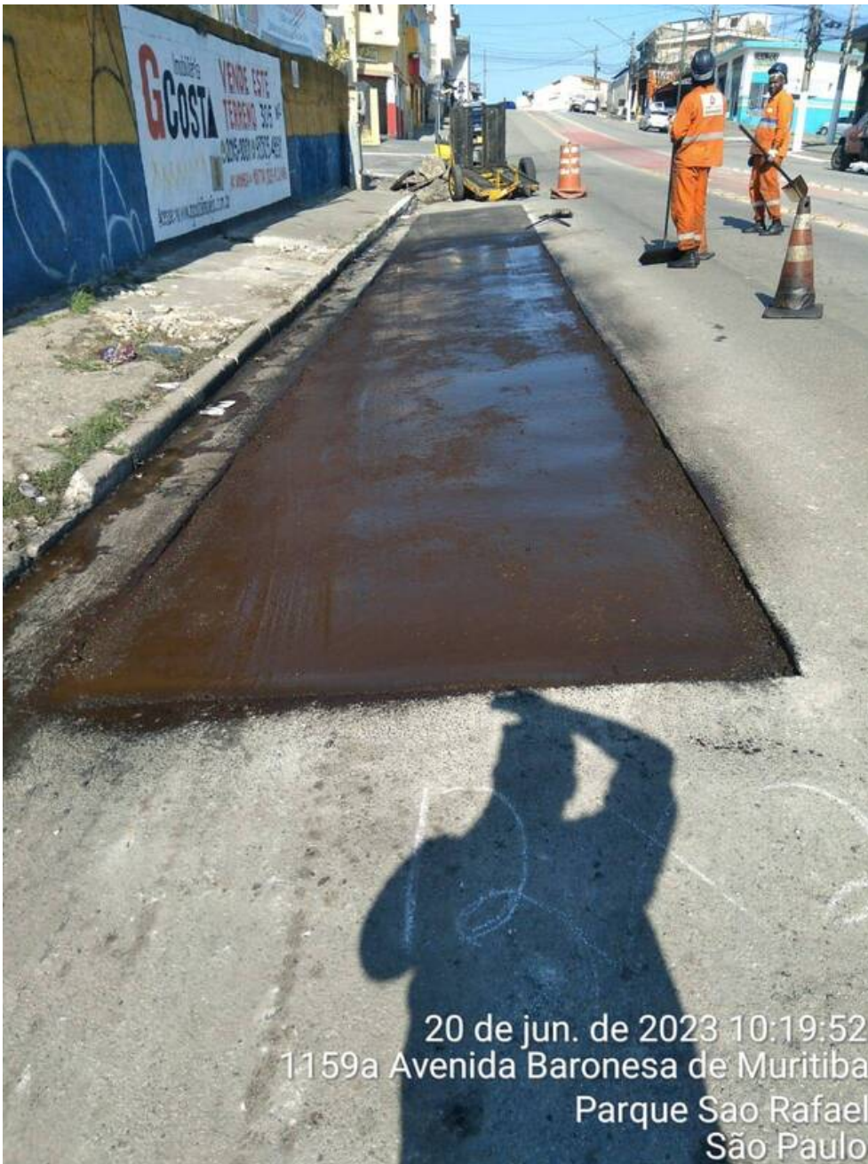
8 | APLICAÇÃO → M.ASFÁLTICA (HASTE): Item de OS APLICAÇÃO DE MASSA DA CONCORDÂNCIA Origem: 7569308 - (Foto Capturada Em: 21/06/23 11:05, Por: mxintadm)
