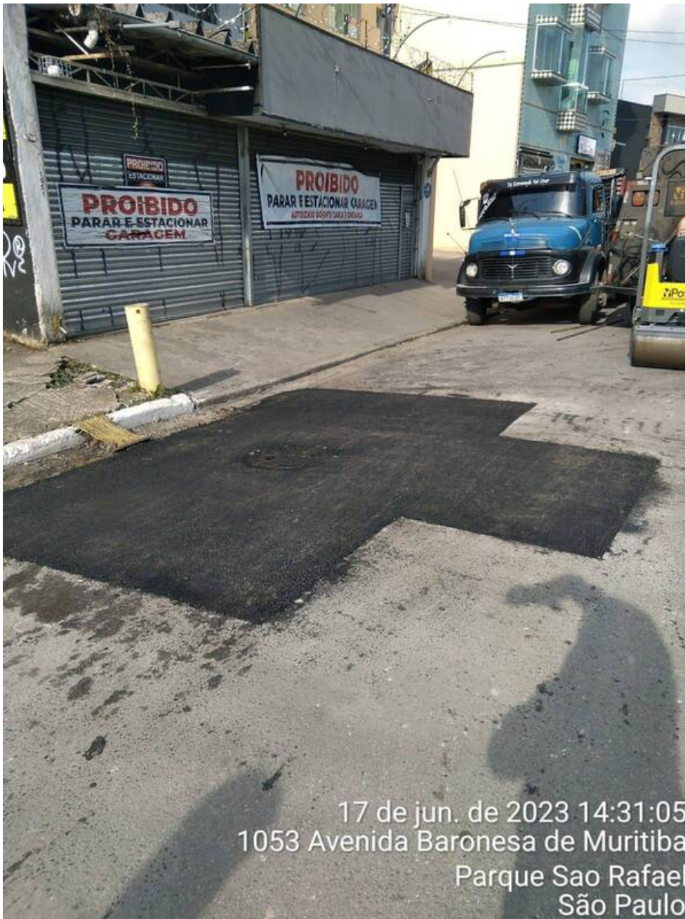
7 | ACABAMENTO → IRRE. DA VIA (CAIXA PRONTA); Item de OS APLICAÇÃO DE MASSA DA CONCORDÂNCIA Origem: 7157386 - (Foto Capturada Em: 20/06/23 13:55, Por: mxintadm)
