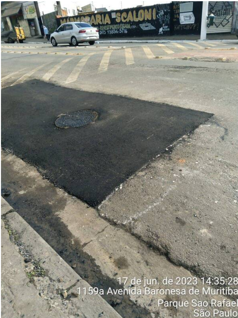
11 | ACABAMENTO → IRRE. DA VIA (CAIXA PRONTA): Item de OS APLICAÇÃO DE MASSA DA CONCORDÂNCIA Origem: 7562311 - (Foto Capturada Em: 20/06/23 13:55, Por: mxintadm)
