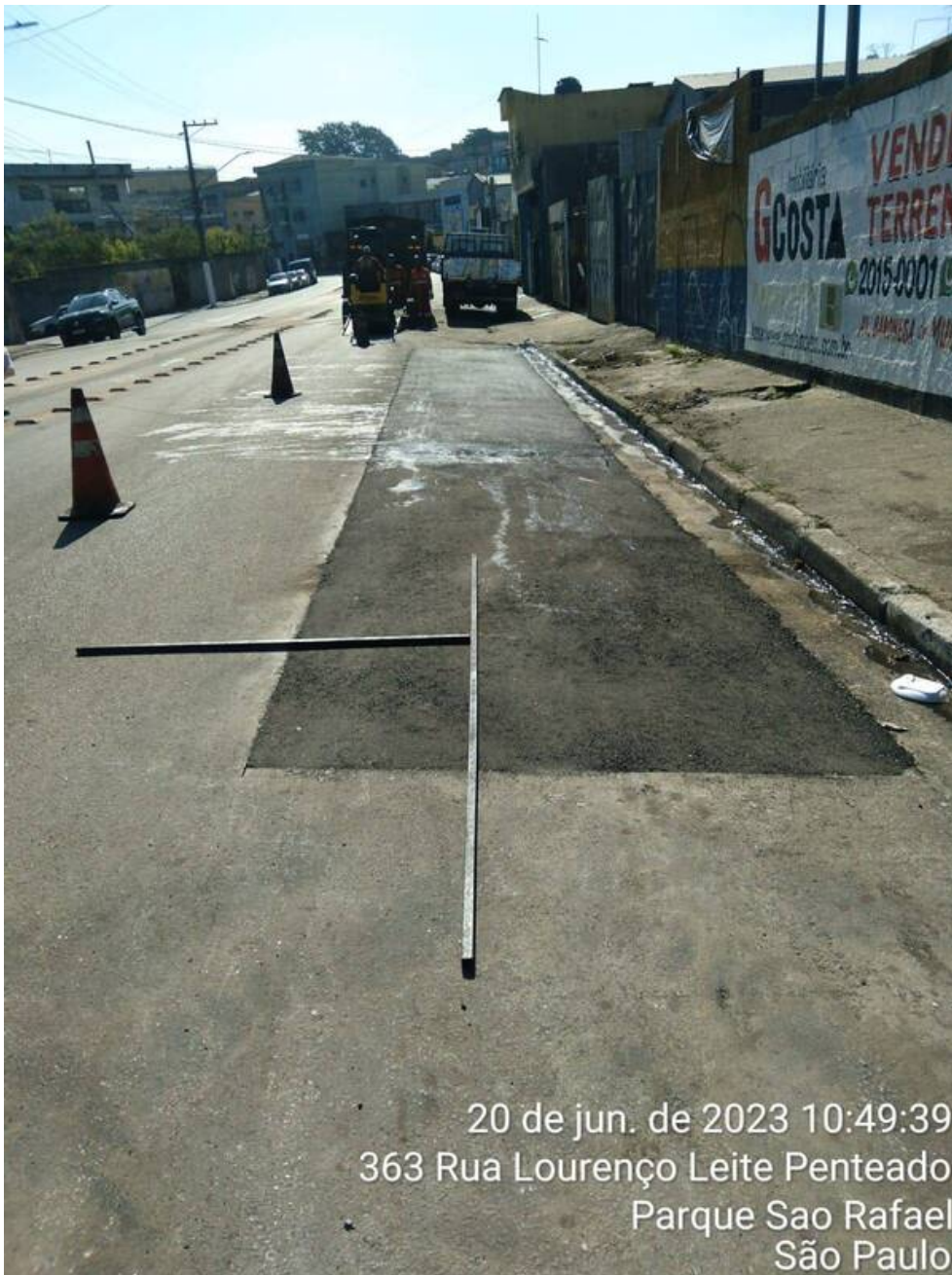
8 | ACABAMENTO → IRRE. DA VIA (CAIXA PRONTA); Item de OS APLICAÇÃO DE MASSA DA CONCORDÂNCIA Origem: 7562313 - (Foto Capturada Em: 21/06/23 09:48, Por: mxintadm)
