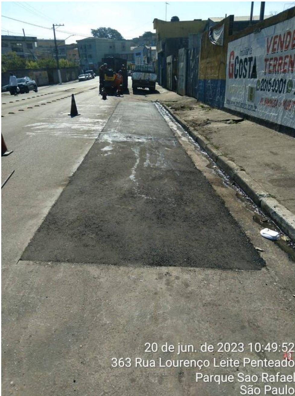
2 | ACABAMENTO → IRRE. DA VIA (CAIXA PRONTA); Item de OS APLICAÇÃO DE MASSA DA CONCORDÂNCIA Origem: 7569308 - (Foto Capturada Em: 21/06/23 11:05, Por: mxintadm)
