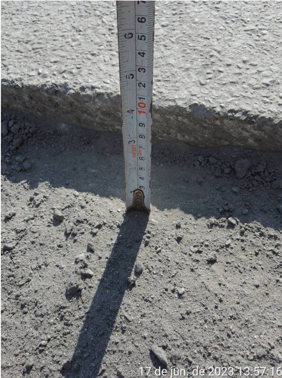
3 | ACABAMENTO → NÍVEL C/RÉGUA (CAIXA PRONTA); Item de OS APLICAÇÃO DE MASSA DA CONCORDÂNCIA Origem: 7157386 - (Foto Capturada Em: 20/06/23 13:55, Por: mxintadm)
