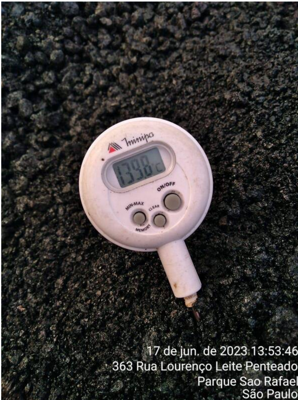
9 | ACABAMENTO → IRRE. DA VIA (CAIXA PRONTA); Item de OS APLICAÇÃO DE MASSA DA CONCORDÂNCIA Origem: 7562311 - (Foto Capturada Em: 20/06/23 13:55, Por: mxintadm)
