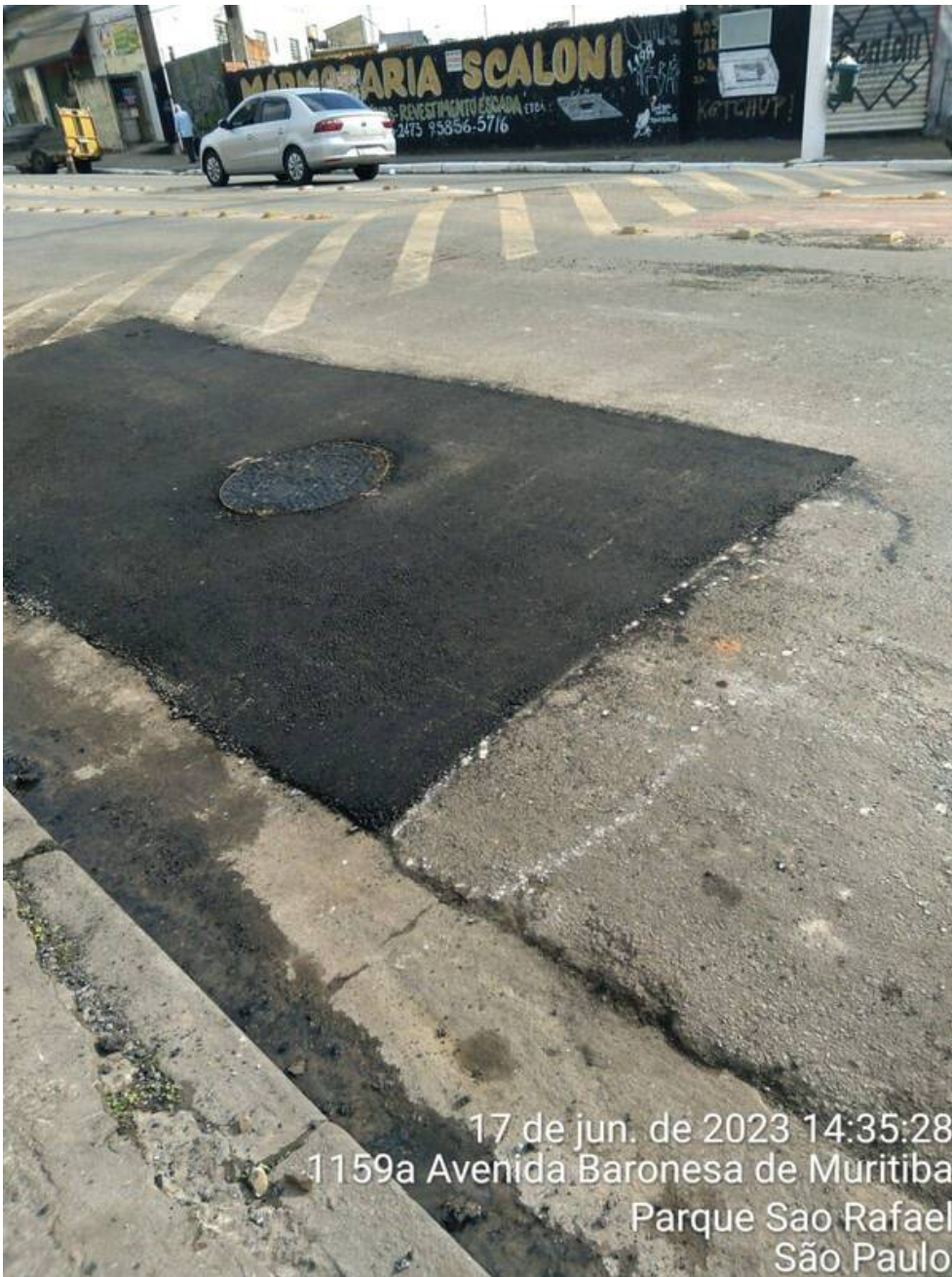
7 | ACABAMENTO → NÍVEL C/RÉGUA (CAIXA PRONTA); Item de OS APLICAÇÃO DE MASSA DA CONCORDÂNCIA Origem: 7562311 - (Foto Capturada Em: 20/06/23 13:55, Por: mxintadm)
