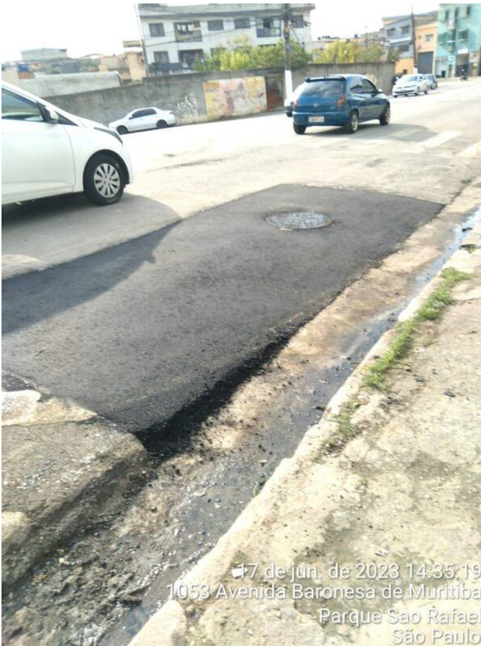
10 | ACABAMENTO → IRRE. DA VIA (CAIXA PRONTA): Item de OS APLICAÇÃO DE MASSA DA CONCORDÂNCIA Origem: 7562311 - (Foto Capturada Em: 20/06/23 13:55, Por: mxintadm)
