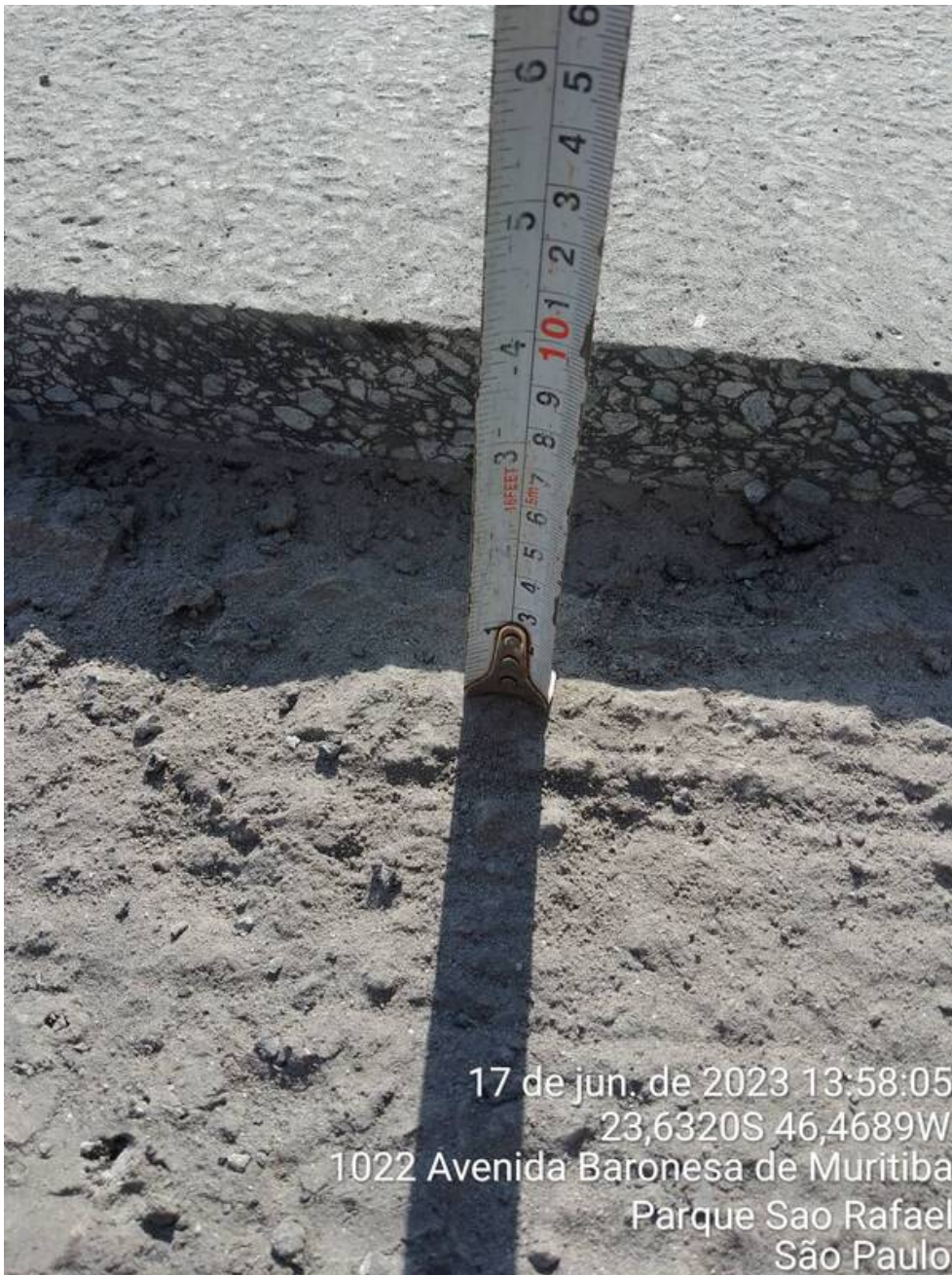
9 | ACABAMENTO → IRRE. DA VIA (CAIXA PRONTA); Item de OS APLICAÇÃO DE MASSA DA CONCORDÂNCIA Origem: 7157386 - (Foto Capturada Em: 20/06/23 13:55, Por: mxintadm)
