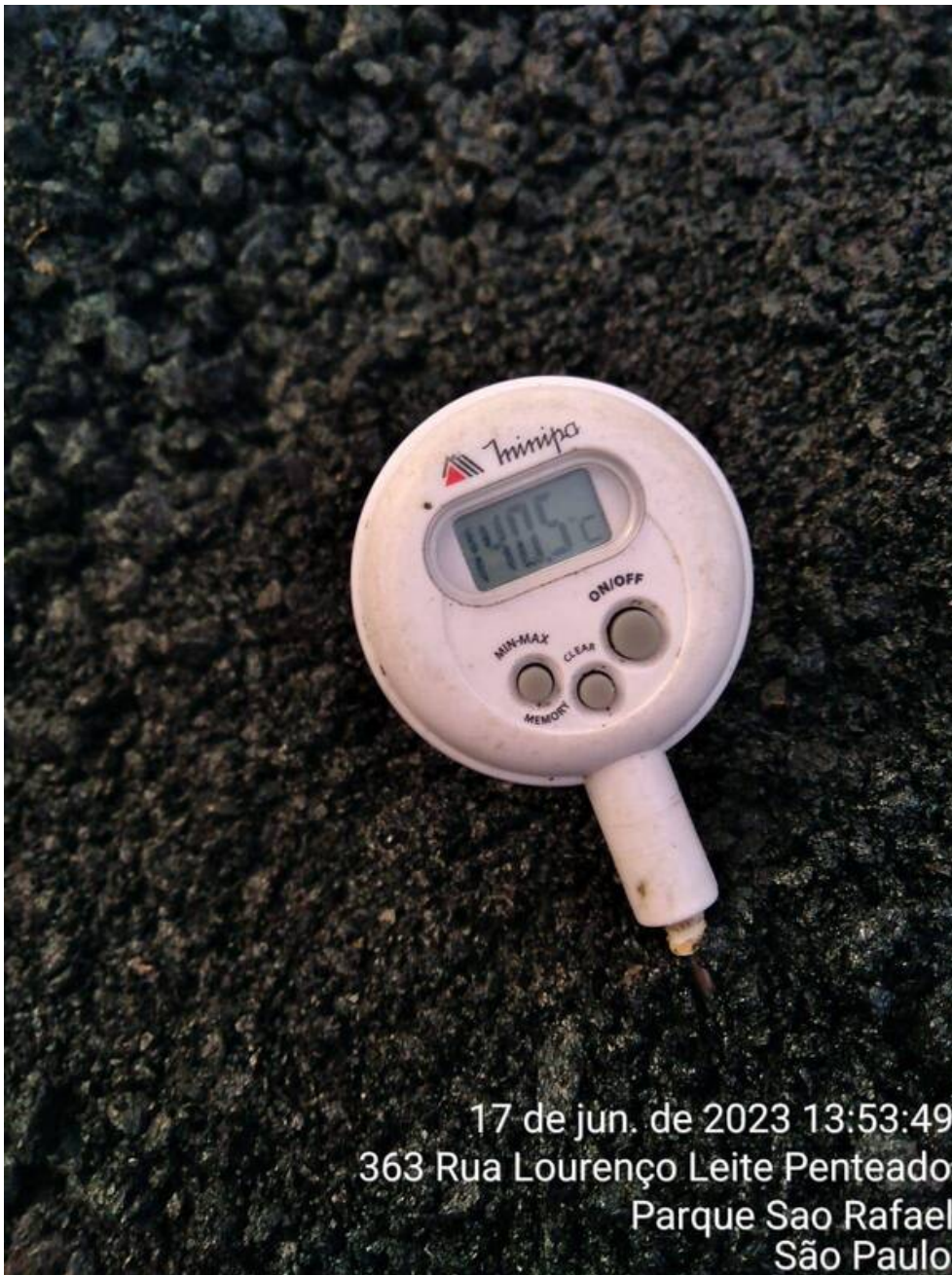
7 | ACABAMENTO → NÍVEL C/RÉGUA (CAIXA PRONTA); Item de OS APLICAÇÃO DE MASSA DA CONCORDÂNCIA Origem: 7562313 - (Foto Capturada Em: 21/06/23 09:48, Por: mxintadm)
