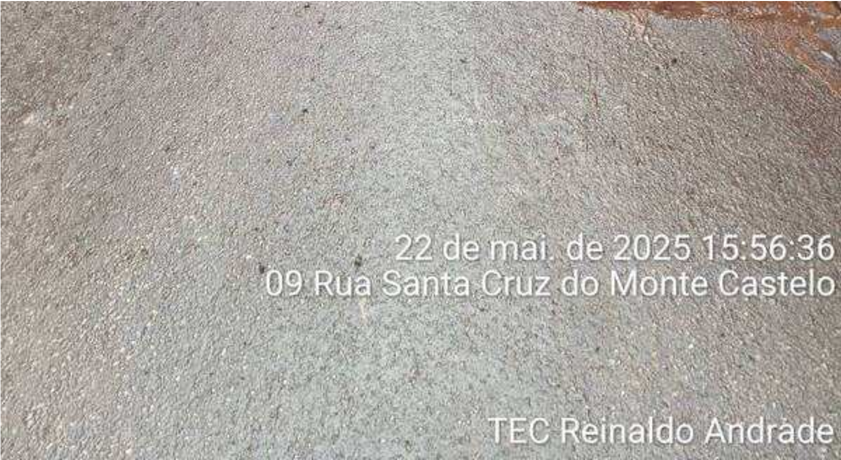
12 | APLICAÇÃO → Aplicação Massa Asfáltica (haste): Item de OS APLICAÇÃO DE MASSA Origem: 12303118 - (Foto Capturada Em: 23/05/25 23:59, Por: mxintadm)
