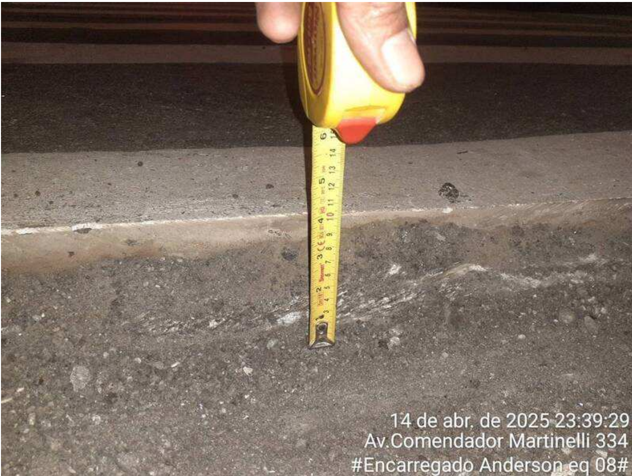
4 | APLICAÇÃO → Aplicação da Emulsão: Item de OS APLICAÇÃO DE MASSA Origem: 11267652 - (Foto Capturada Em: 15/04/25 17:39, Por: mxintadm)
