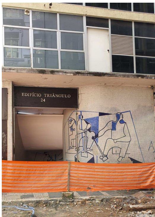
Figura 16. Obras de infraestrutura em andamento na Rua José Bonifácio, que interferem na visualização do painel. Foto: Ana Carolina Modinger, 19/03/2025. Fonte: Acervo DPH/NMOA.
