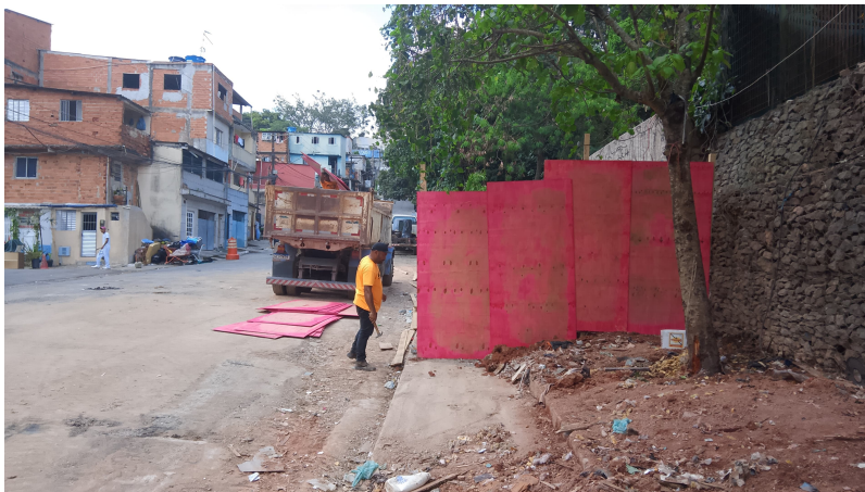
Tapumes colocados pela USP,
