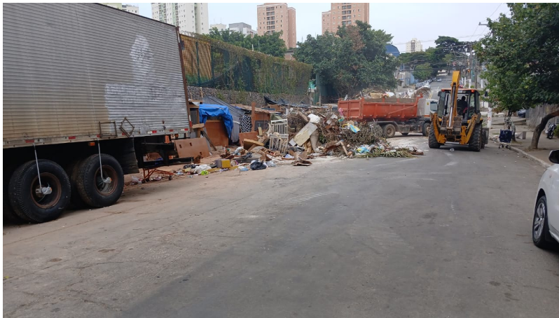
Muro da USP em reforma e moradores já reocupando ao lado.
