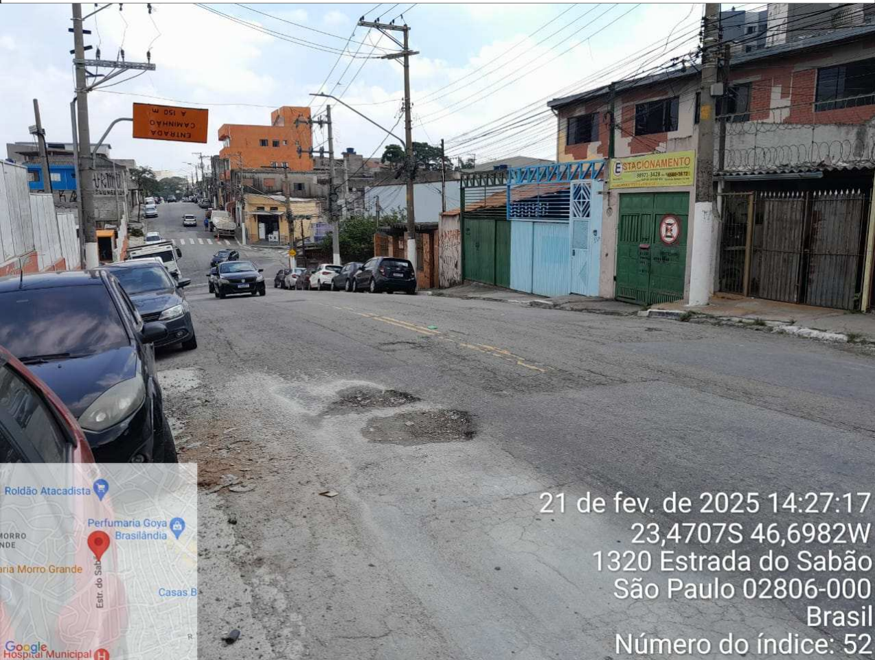
2 | OS TAPA BURACO CONSERVACAO PAVIMENTO Origem: 11261124 - (Foto Capturada Em: 21/02/25 15:37, Por: Daniele Amelia dos Santos Rocha)
