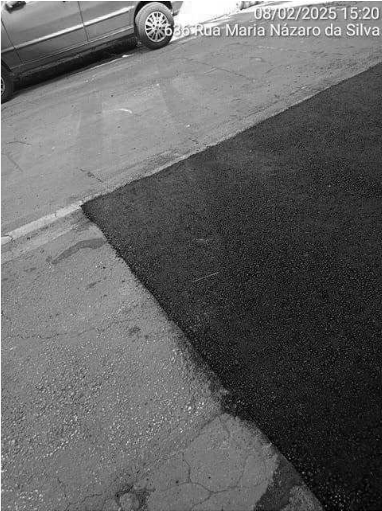
9 | APLICAÇÃO → Aplicação Massa Asfáltica (haste): Item de OS Origem: 11201798 - (Foto Capturada Em: 10/02/25 22:32, Por: mxintadm)
