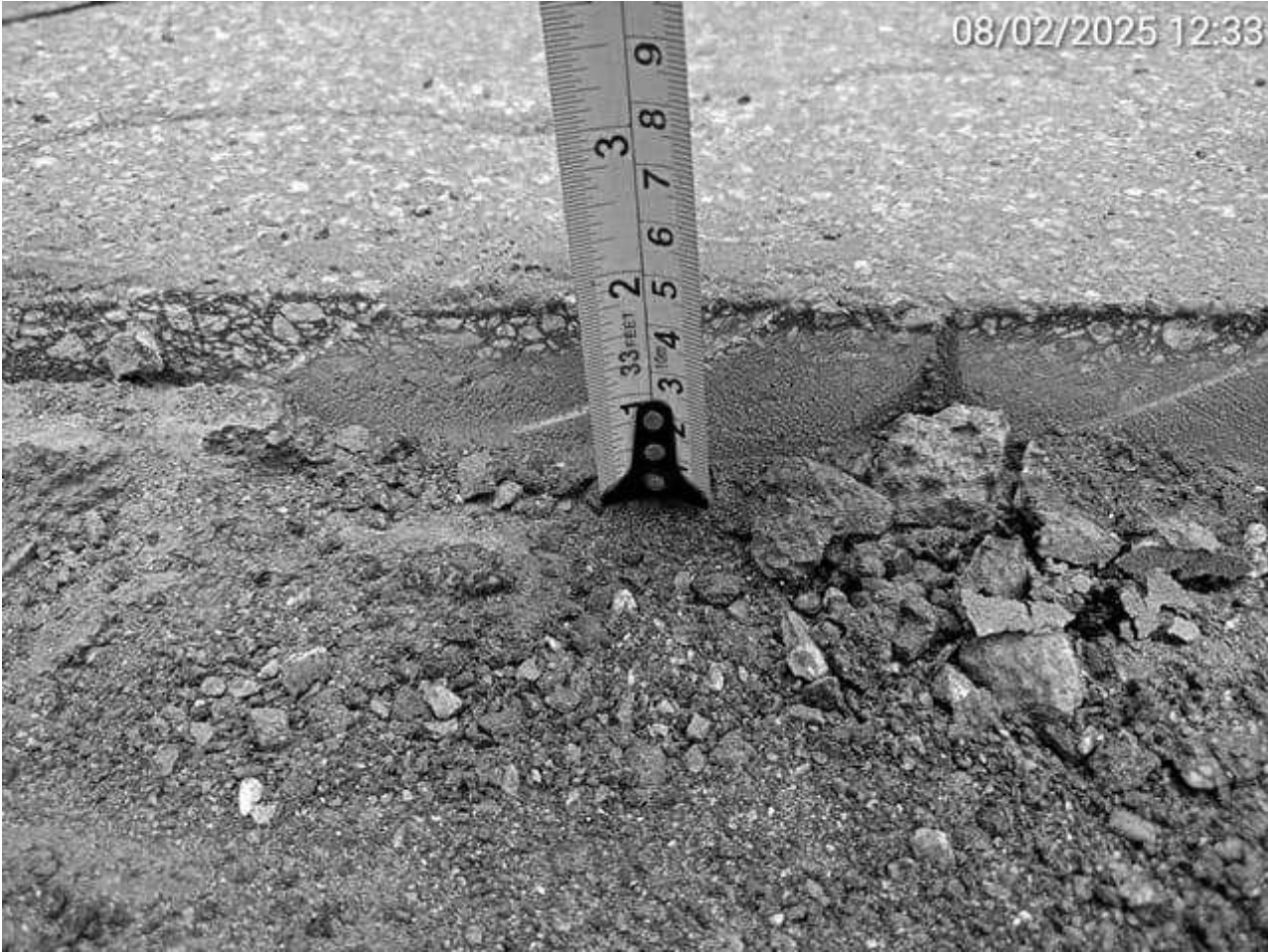
12 | PROFUNDIDADE → Registro da profundidade mais funda da caixa com uso da trena: Item de OS Origem: 11195497 - (Foto Capturada Em: 09/02/25 21:51, Por: mxintadm)
