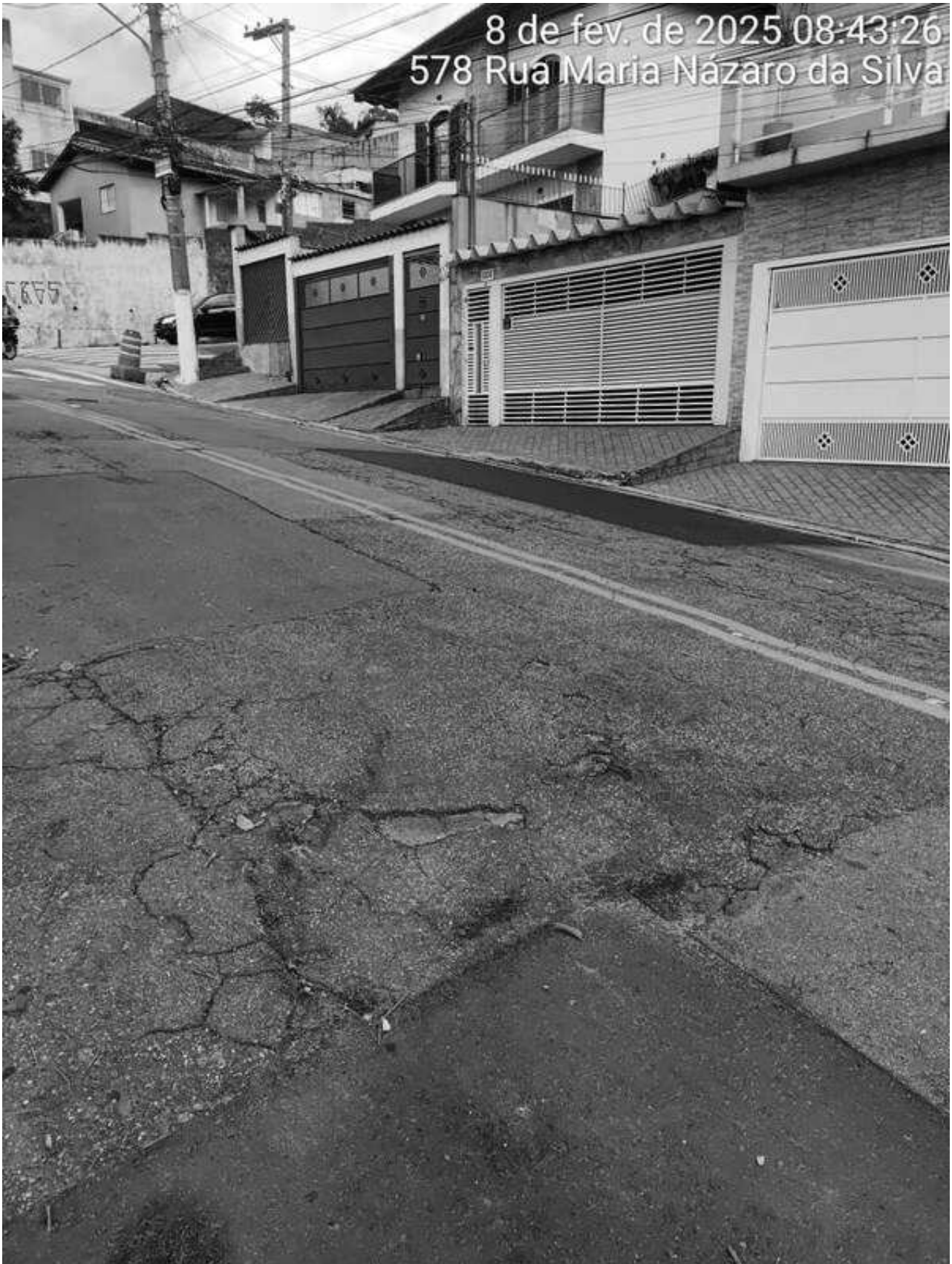
2 | Demarcação da caixa: Item de OS Origem: 11201839 - (Foto Capturada Em: 08/02/25 08:44, Por: mxintadm)
