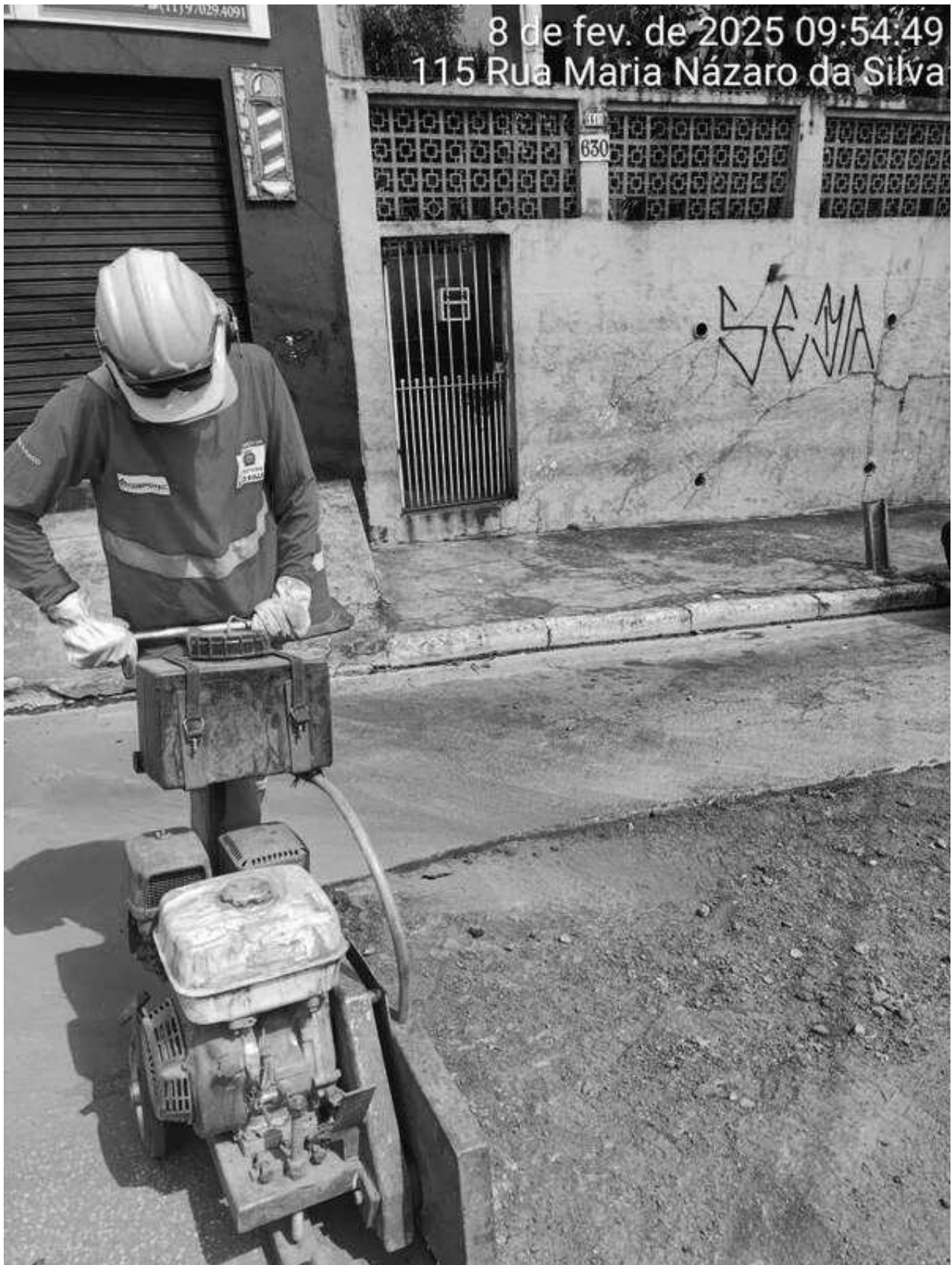
5 | RECORTE → Limpeza da caixa com a trena de 1m, após a serra clipper: Item de OS Origem: 11201799 - (Foto Capturada Em: 08/02/25 09:56, Por: mxintadm)
