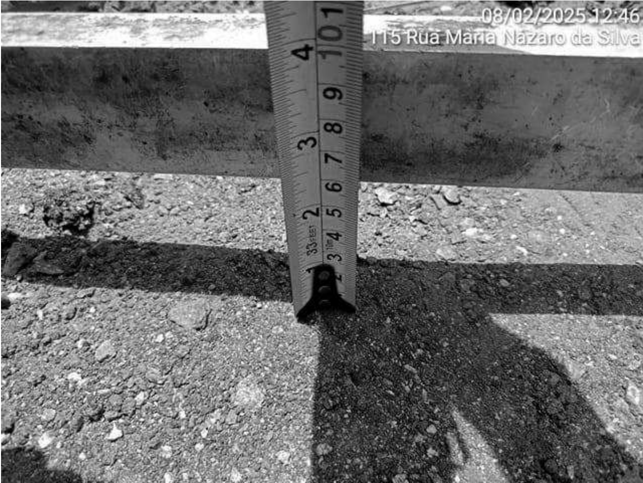
12 | PROFUNDIDADE → Registro da profundidade mais rasa da caixa com uso da trena: Item de OS Origem: 11201798 - (Foto Capturada Em: 10/02/25 22:33, Por: mxintadm)
