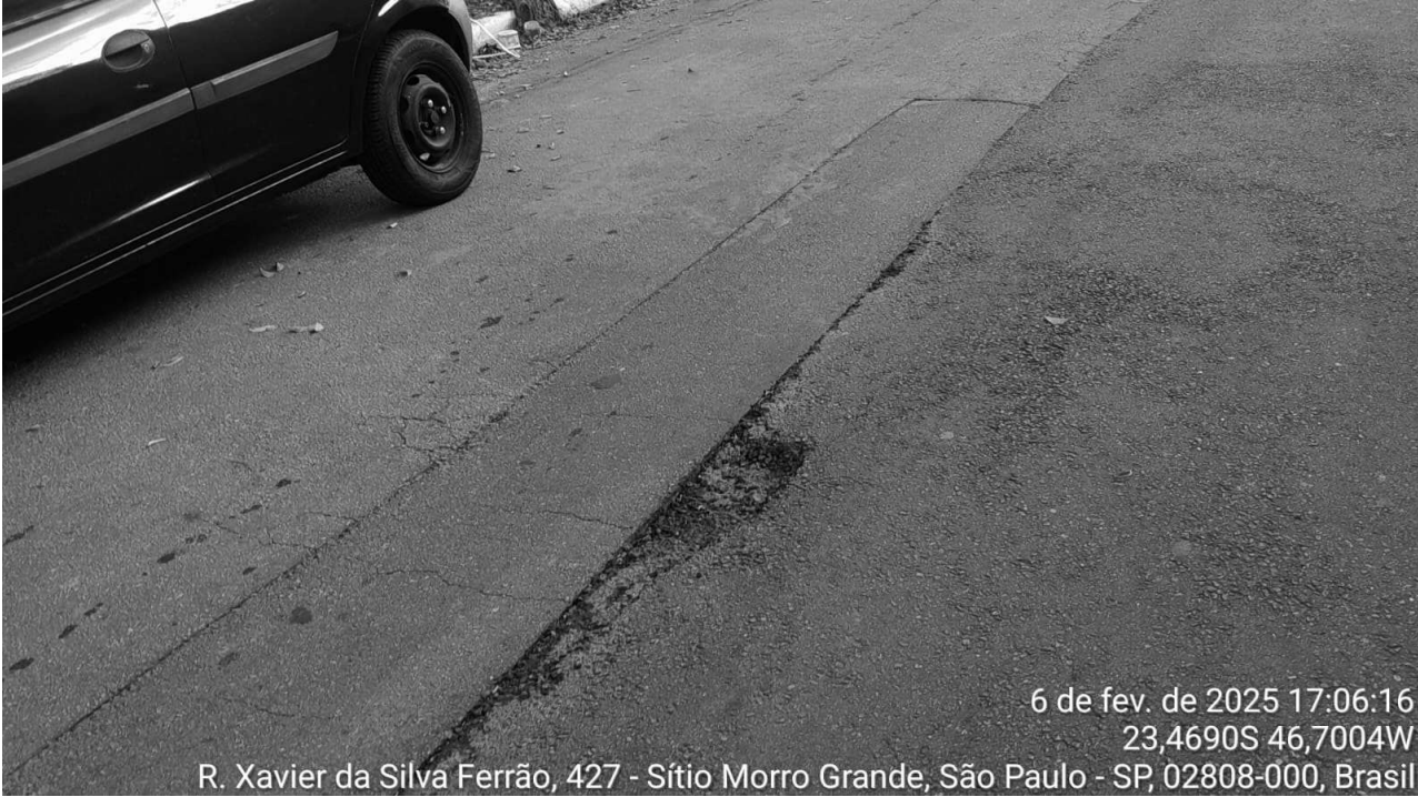
4 | OS TAPA BURACO CONSERVACAO PAVIMENTO Origem: 11194177 - (Foto Capturada Em: 06/02/25 19:17, Por: Marta Aparecida Dias Reimberg)
