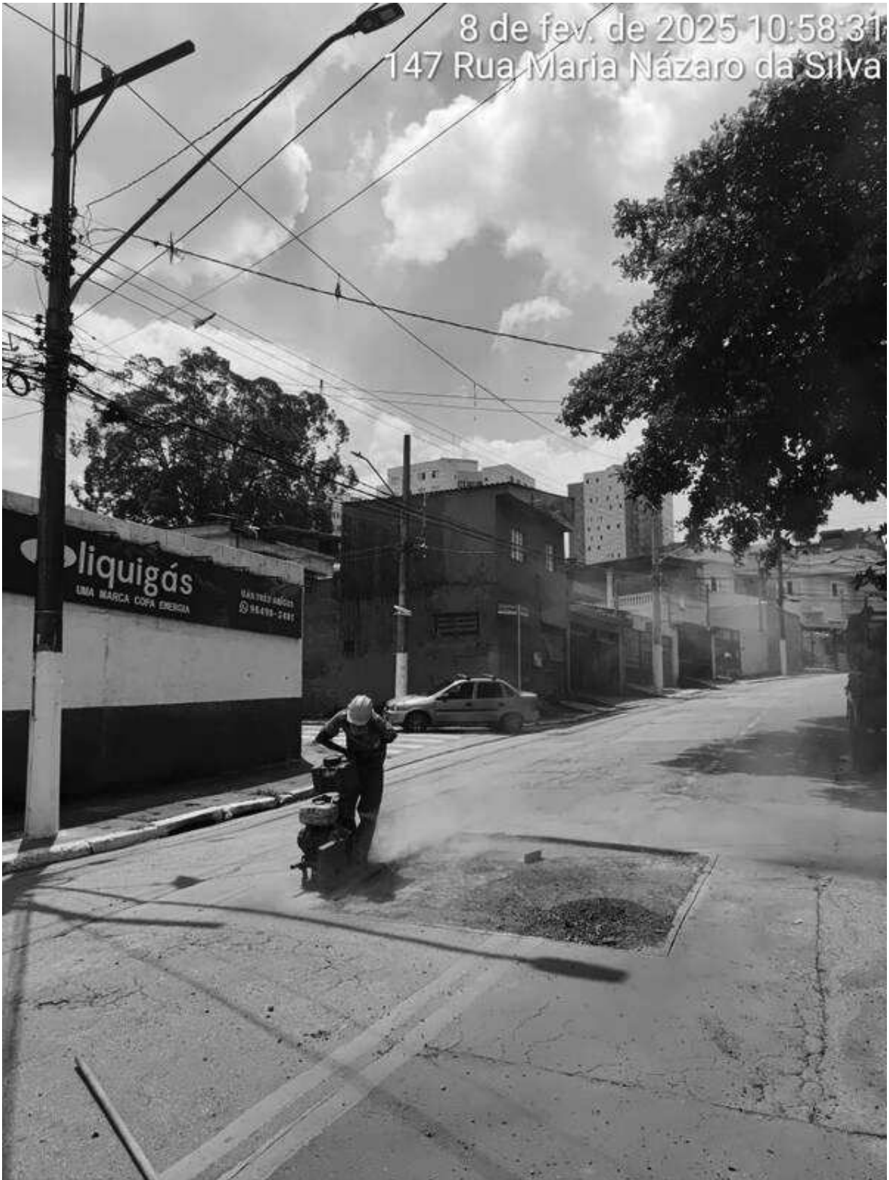
5 | RECORTE → Limpeza da caixa com a trena de 1m, após a serra clipper: Item de OS Origem: 11195496 - (Foto Capturada Em: 08/02/25 11:08, Por: mxintadm)
