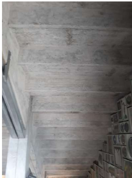
ES - 13 – SETOR 10 – Estrutura vista por baixo Recuperação feita durante a construção do Museu do Futebol.
