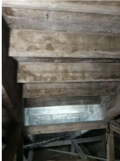
ES - 12 – SETOR 10 – Estrutura vista por baixo Recuperação feita durante a construção do Museu do Futebol.
