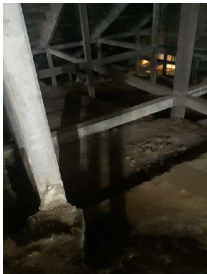
ES - 9 – SETOR 10 – Visão geral da estrutura – por baixo -
