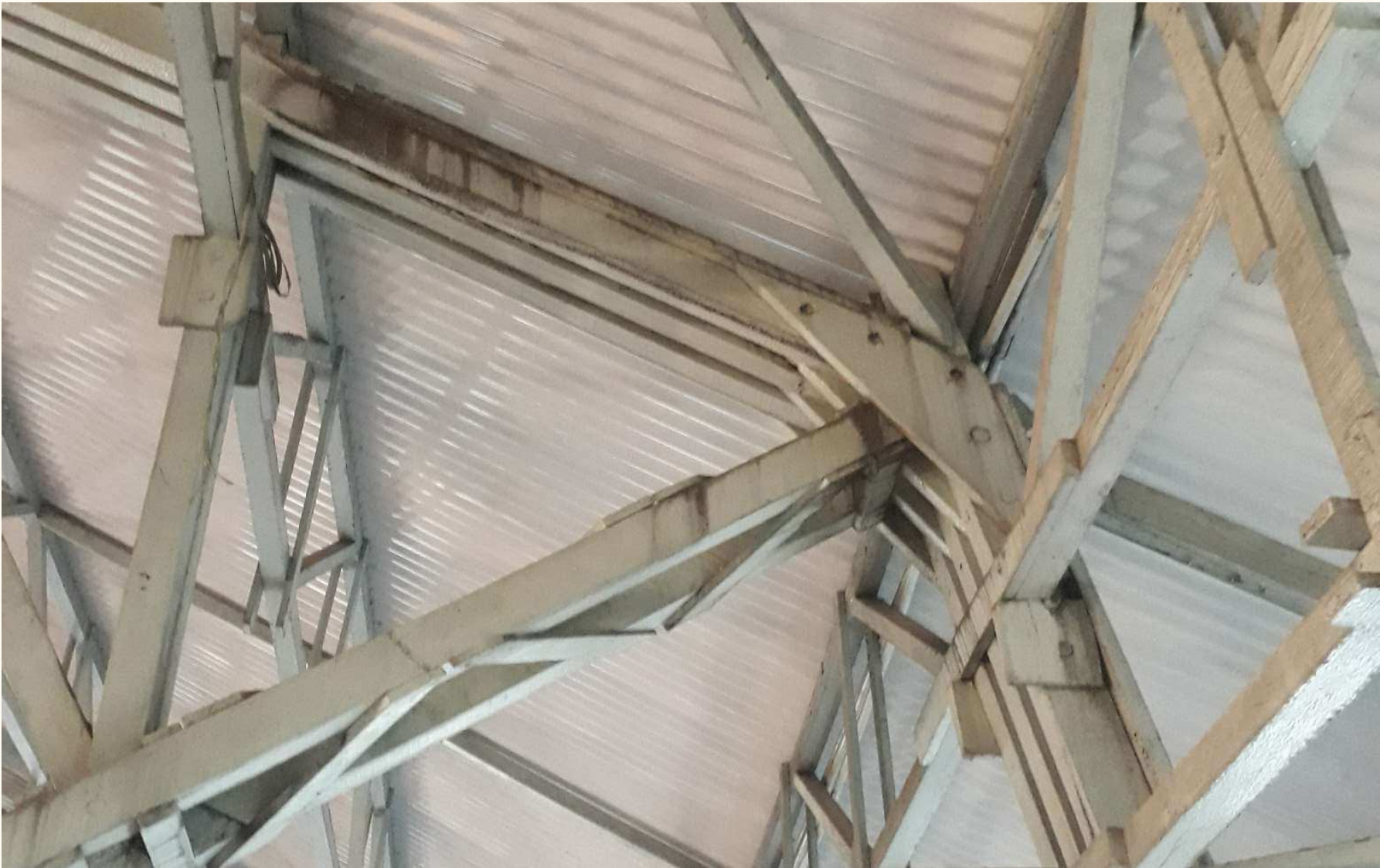
FOTO DE DETALHES DE ELEMENTOS APRESENTANDO APODRECIMENTO OU ROMPIMENTO
