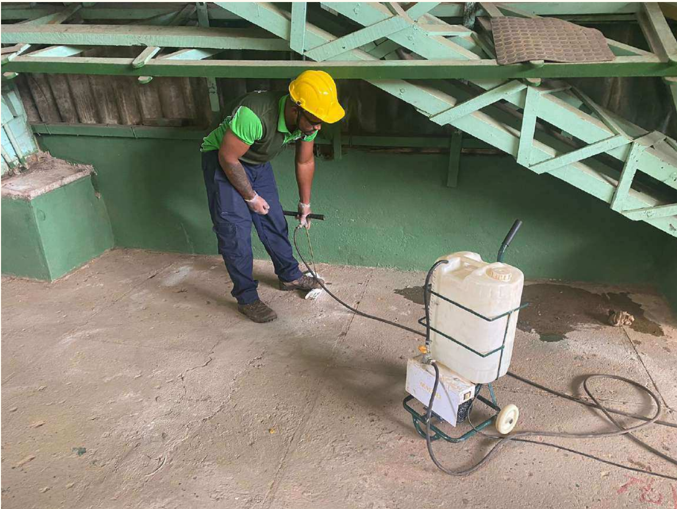
INJEÇÃO DE CALDA CUPINICIDA NO GINÁSIO DE TÊNIS
