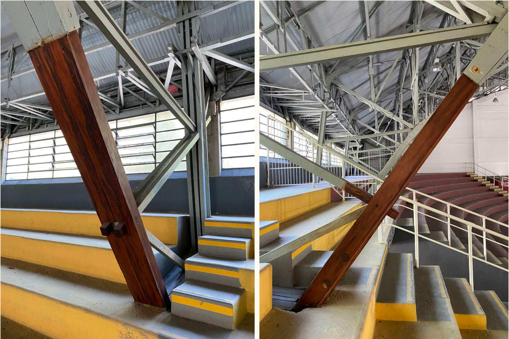
TESTES DE REMOÇÃO DE PINTURA REALIZADOS EM 2021
