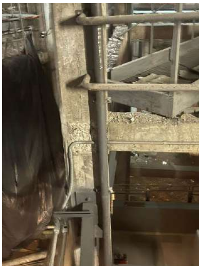
ES - 23 – Vista de viga metálica fixada no pilar da arquibancada
