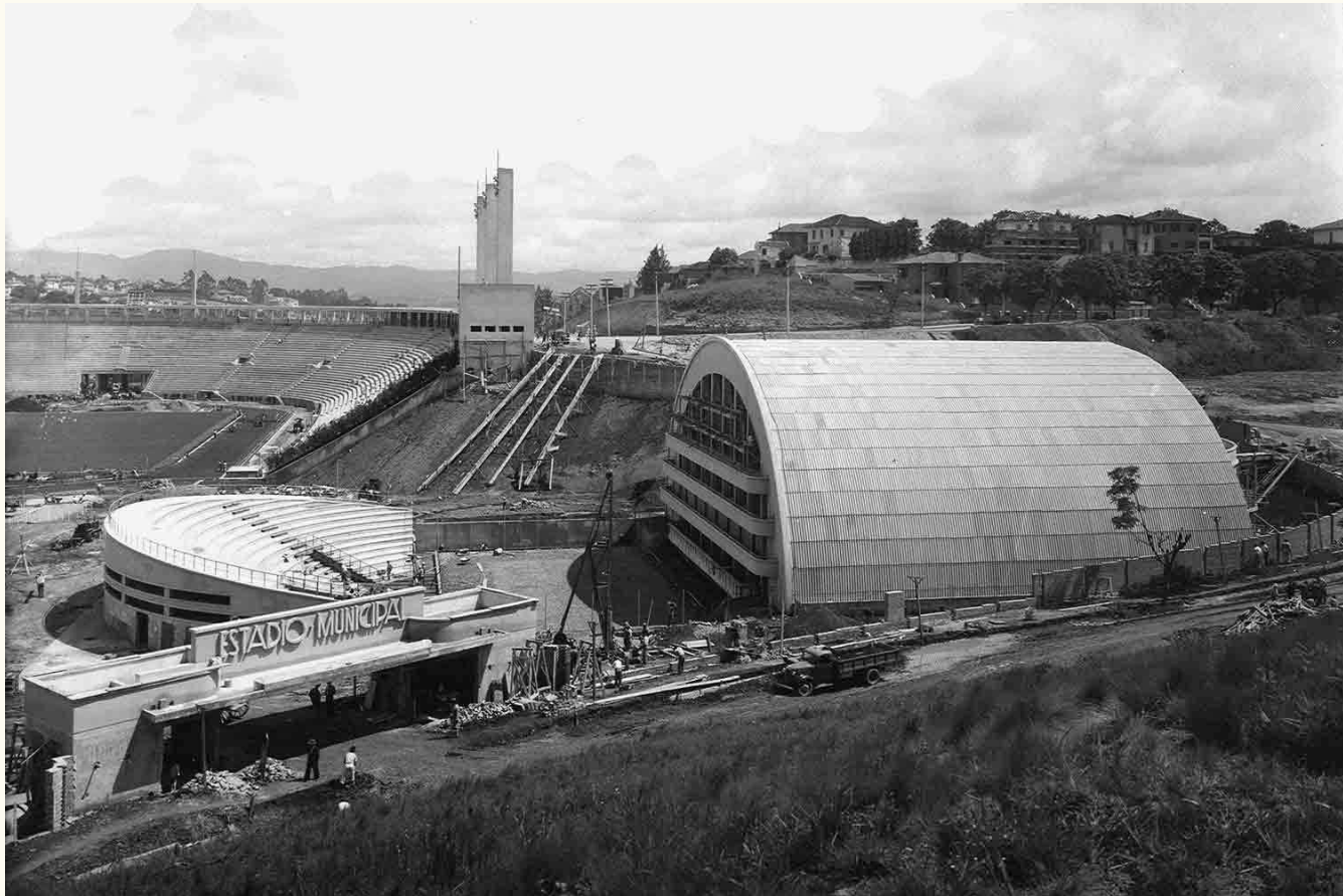
TÊNIS - ESTRUTURA CONCLUÍDA - SEM DATA
