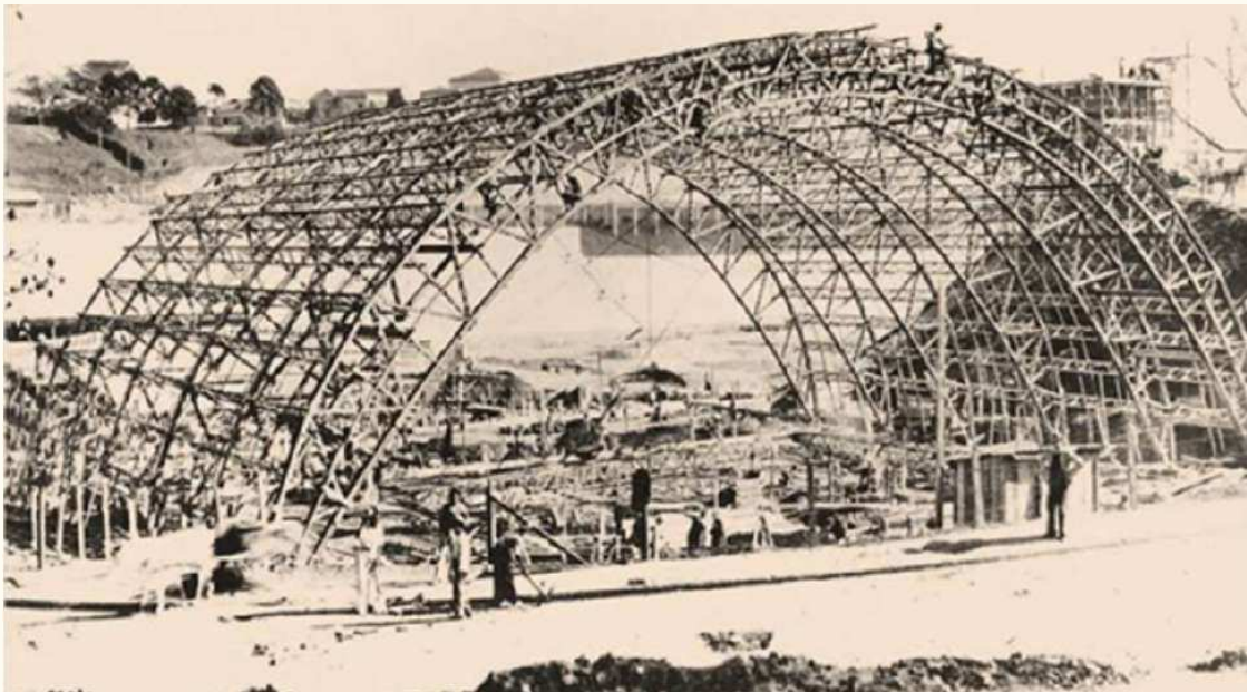
TÊNIS - ESTRUTURA EM CONSTRUÇÃO - 1939
