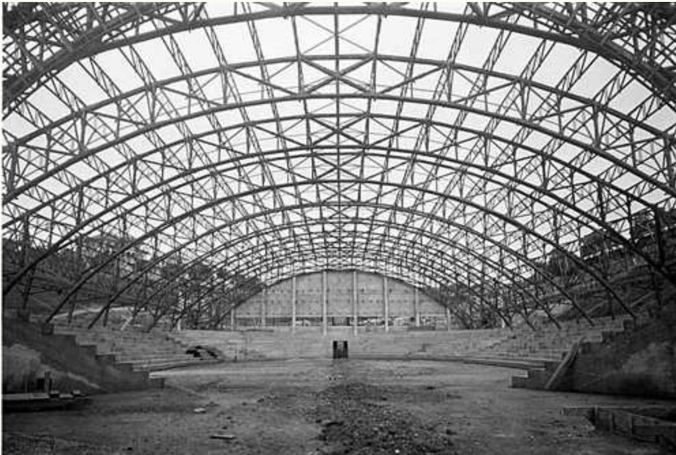
GINÁSIO POLIESPORTIVO EM CONSTRUÇÃO - 1938
