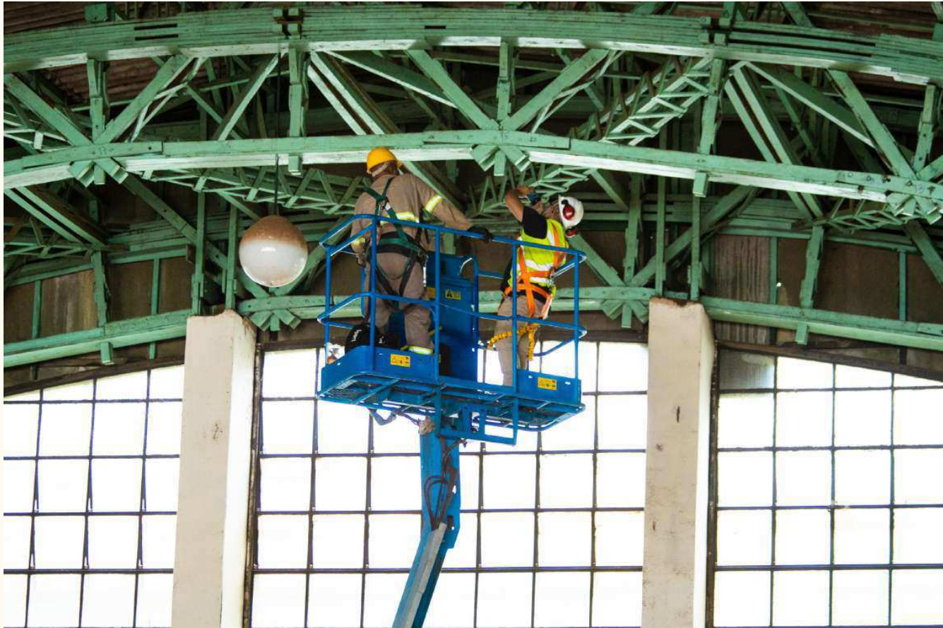
DOCUMENTAÇÃO FOTOGRÁFICA DOS NÓS NO GINÁSIO DE TÊNIS
