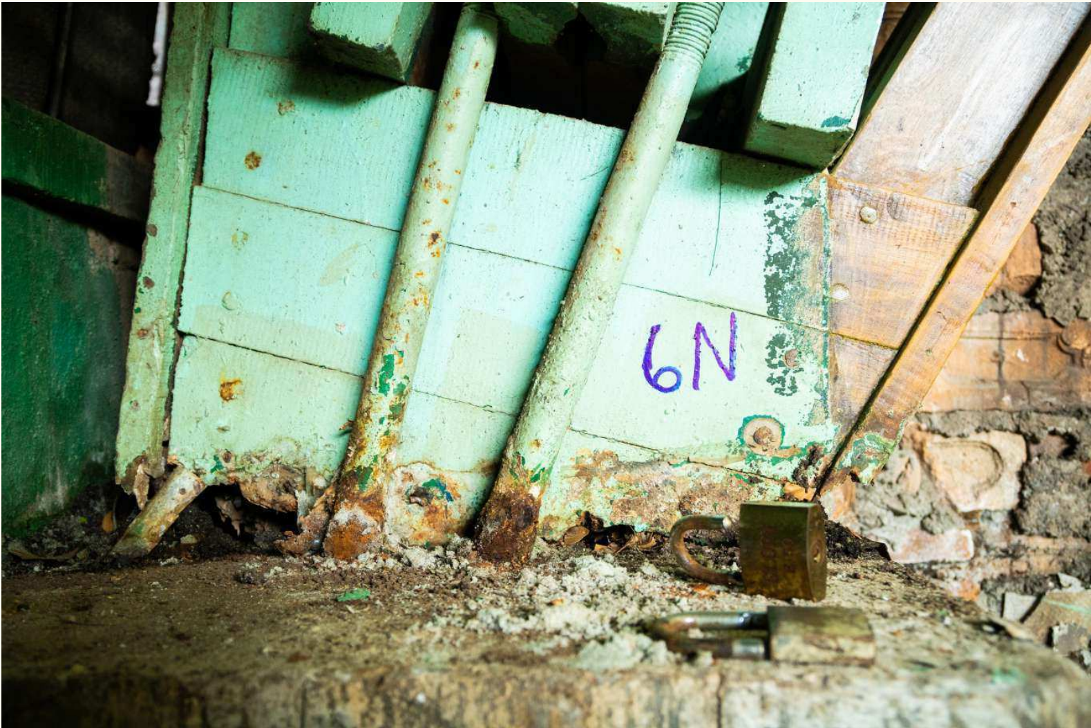
TESTES DE REMOÇÃO DE PINTURA REALIZADOS EM 2021
