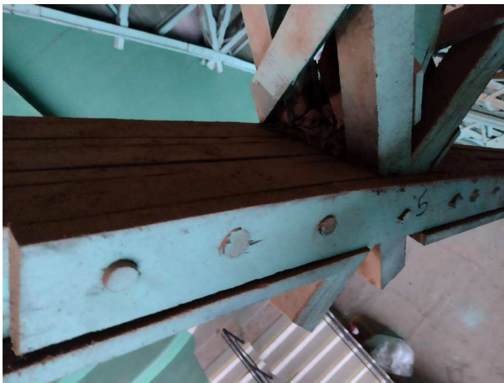
Foto ligação de banzo inferior com cobrejuntas e cavilhas
