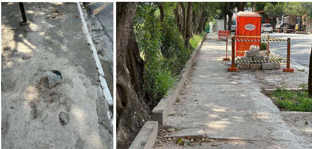
Imagens acima: arquivo da ALLEGRA PACAEMBU tiradas do eixo da Rua Itápolis, passeios públicos do lado Leste do estádio e percurso para a Praça Charles Miller, com destaque para um dos canteiros de obras da Concessionária Linha Universidade S.A. à execução da Linha 6 - Laranja do Metrô de São Paulo.
