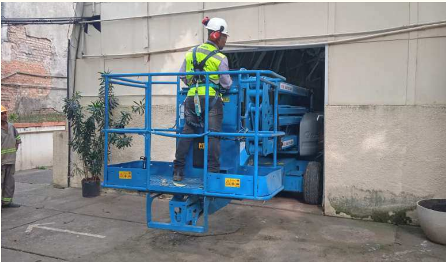
ACESSO DA PLATAFORMA ELEVATÓRIA AO GINÁSIO DE TÊNIS
