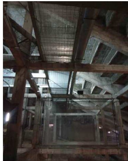
ES - 21 - Vista de passarela metálica fixada na estrutura da arquibancada
