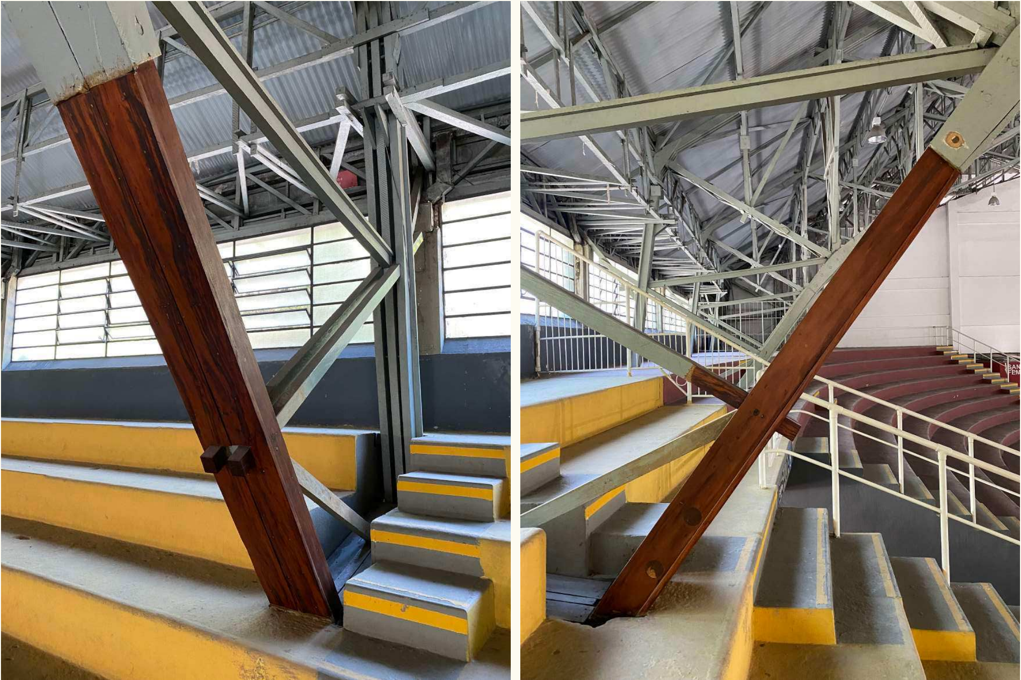
TESTES DE REMOÇÃO DE PINTURA REALIZADOS EM 2021
