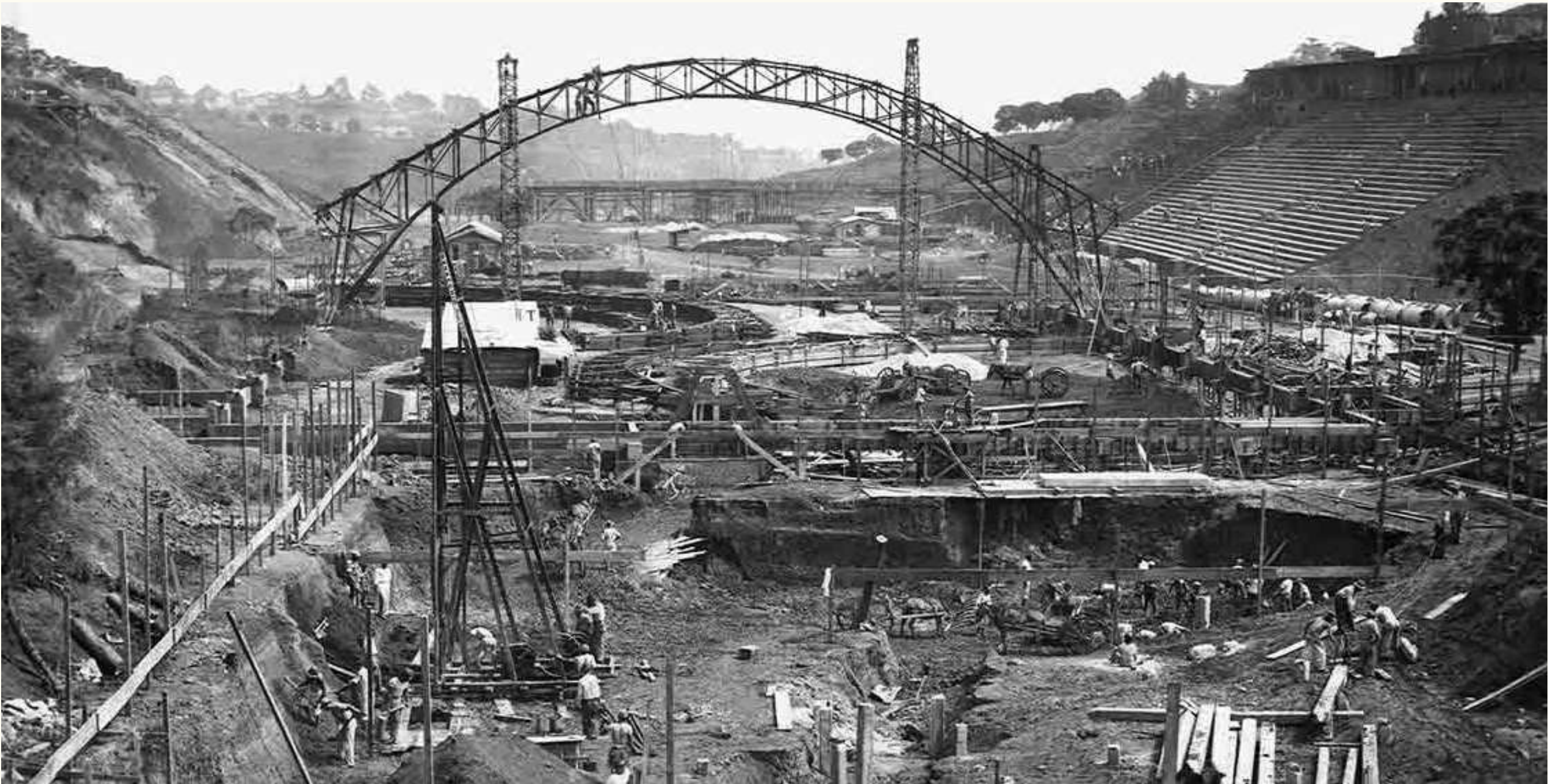
GINÁSIO POLIESPORTIVO - ARCO INICIAL
