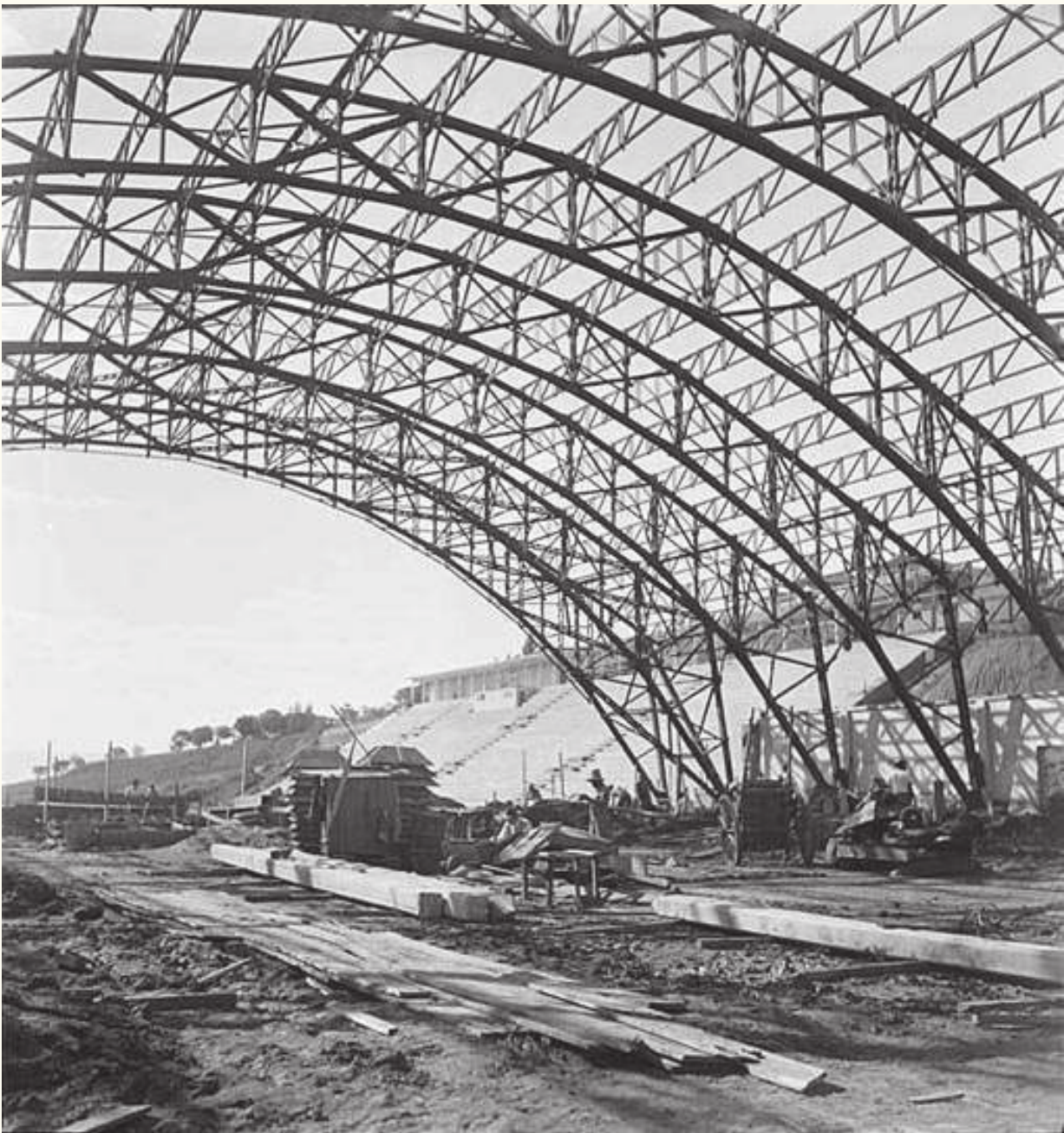
GINÁSIO POLIESPORTIVO EM CONSTRUÇÃO - 1938
