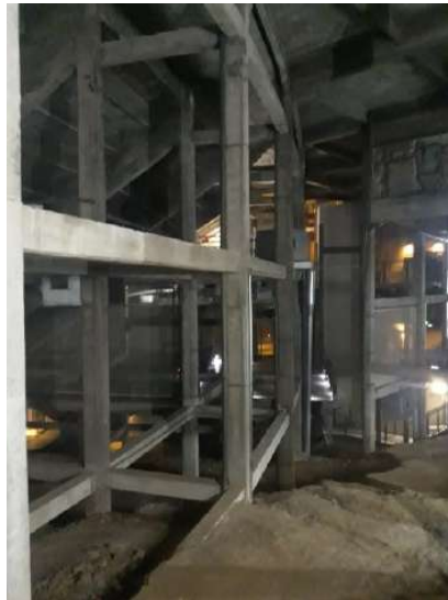
ES - 8 – SETOR 10 – Visão geral da estrutura – por baixo -
