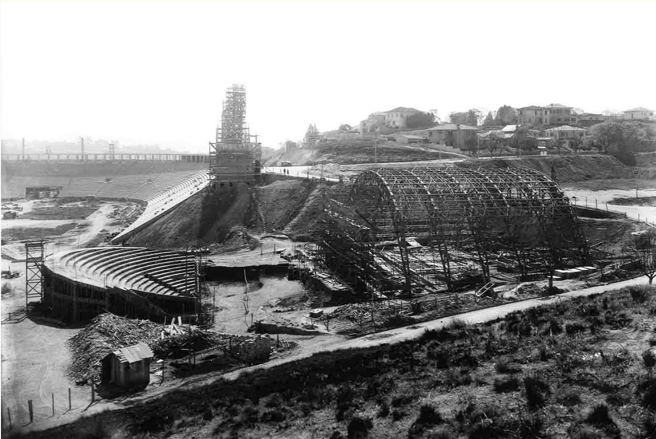
TÊNIS - ESTRUTURA EM CONSTRUÇÃO - 1939
