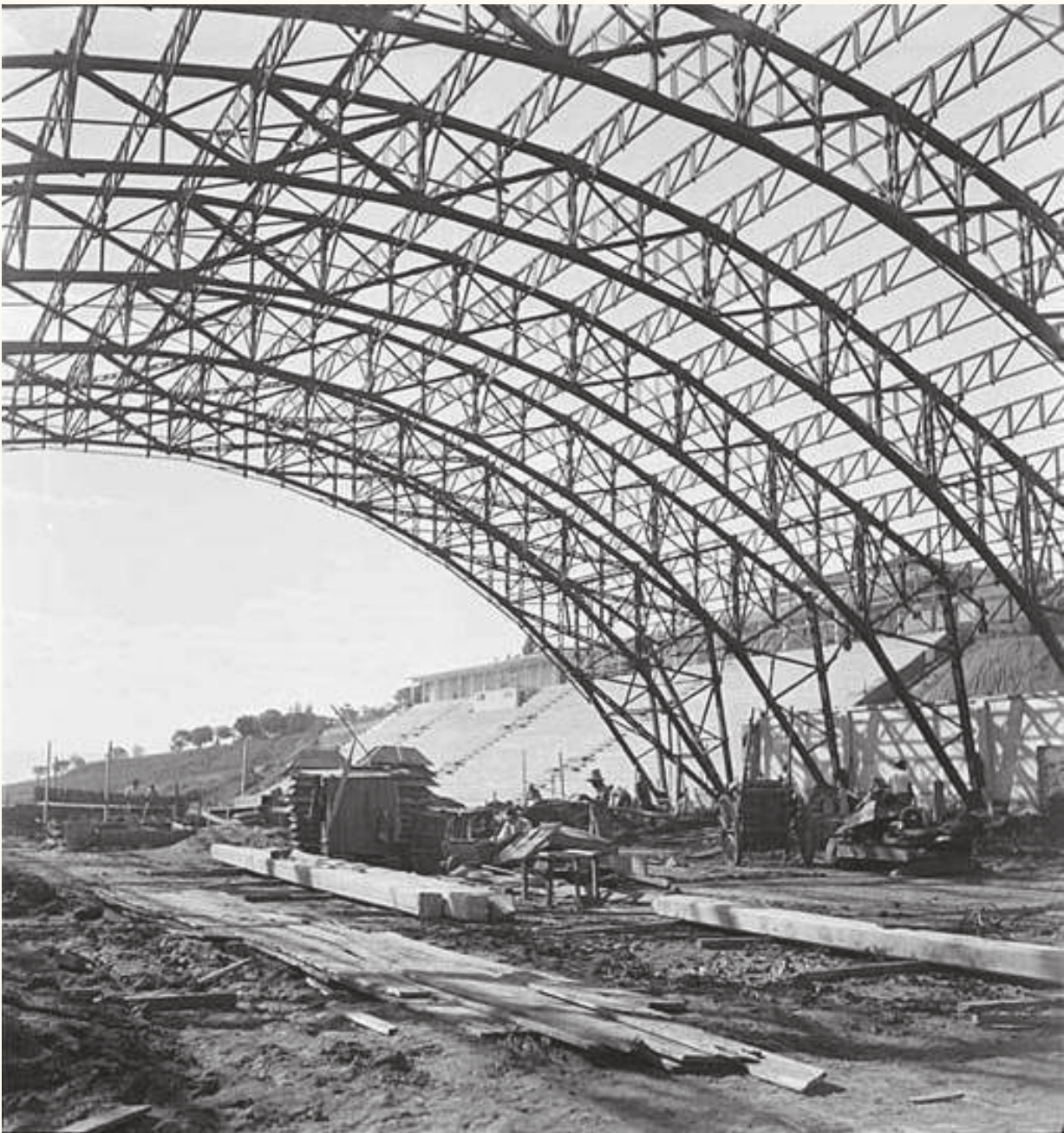
GINÁSIO POLIESPORTIVO EM CONSTRUÇÃO - 1938
