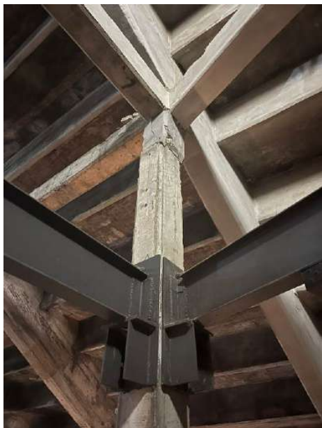
ES - 16 – Vigas metálicas fixadas nos pilares da arquibancada
