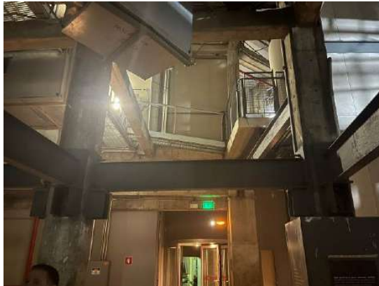
ES - 25 - Vista de passarela metálica fixada na estrutura da arquibancada
