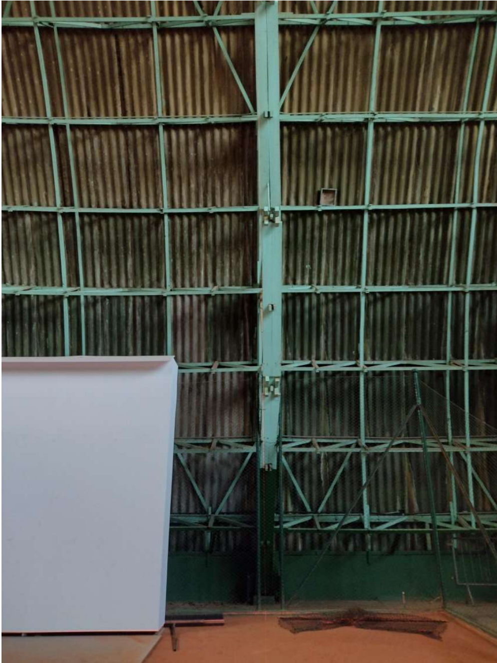
Nós em que o montante atravessa o banzo e interrompe apenas uma das três barras
