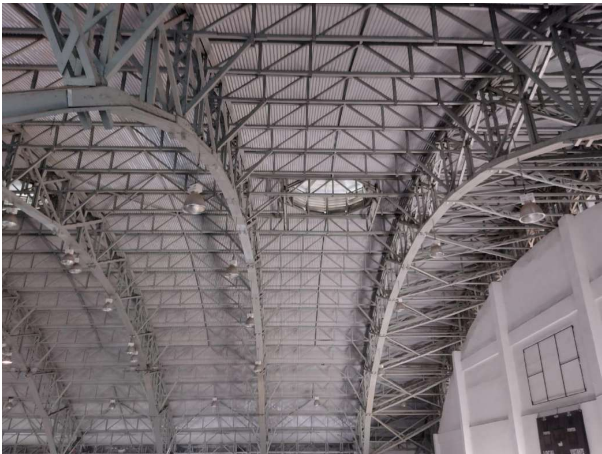
Contraventamento em X junto do banzo inferior do arco e de um parede estruturada em concreto
