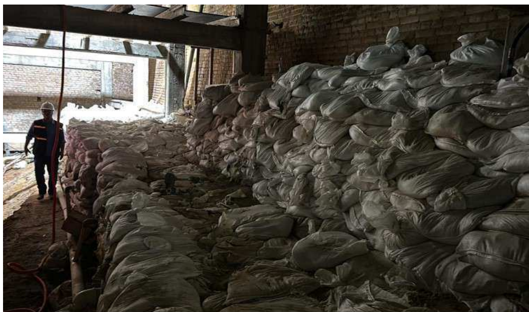
ES - 26 - Vista da contenção em sacos de areia colocados pelo Metrô de SP.
