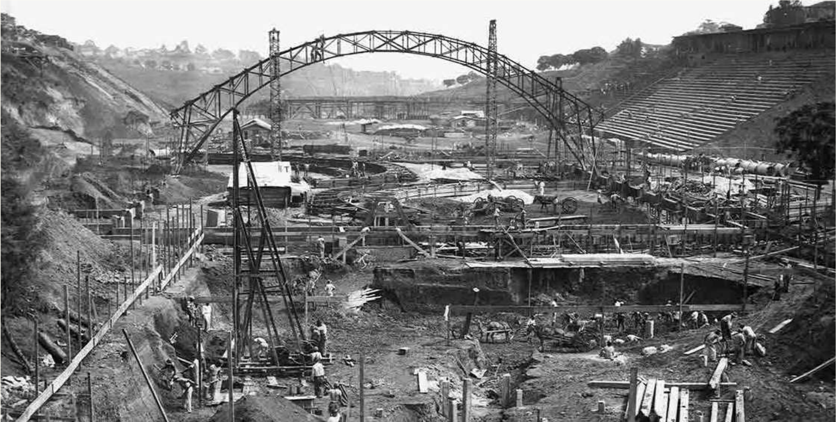
GINÁSIO POLIESPORTIVO - ARCO INICIAL
