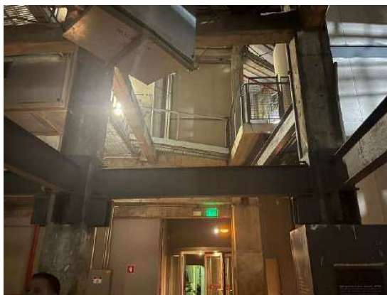
ES - 25 - Vista de passarela metálica fixada na estrutura da arquibancada
