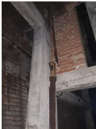
ES - 10 – SETOR 10 – Visão geral da estrutura
