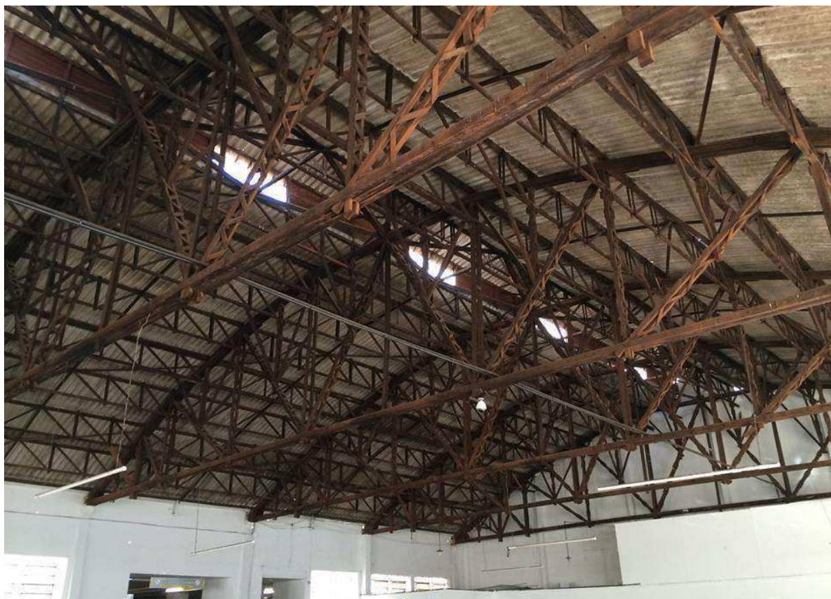
Seção tripla com peças interpostas nos banzos.
