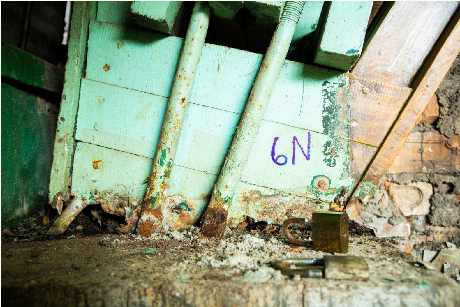
TESTES DE REMOÇÃO DE PINTURA REALIZADOS EM 2021
