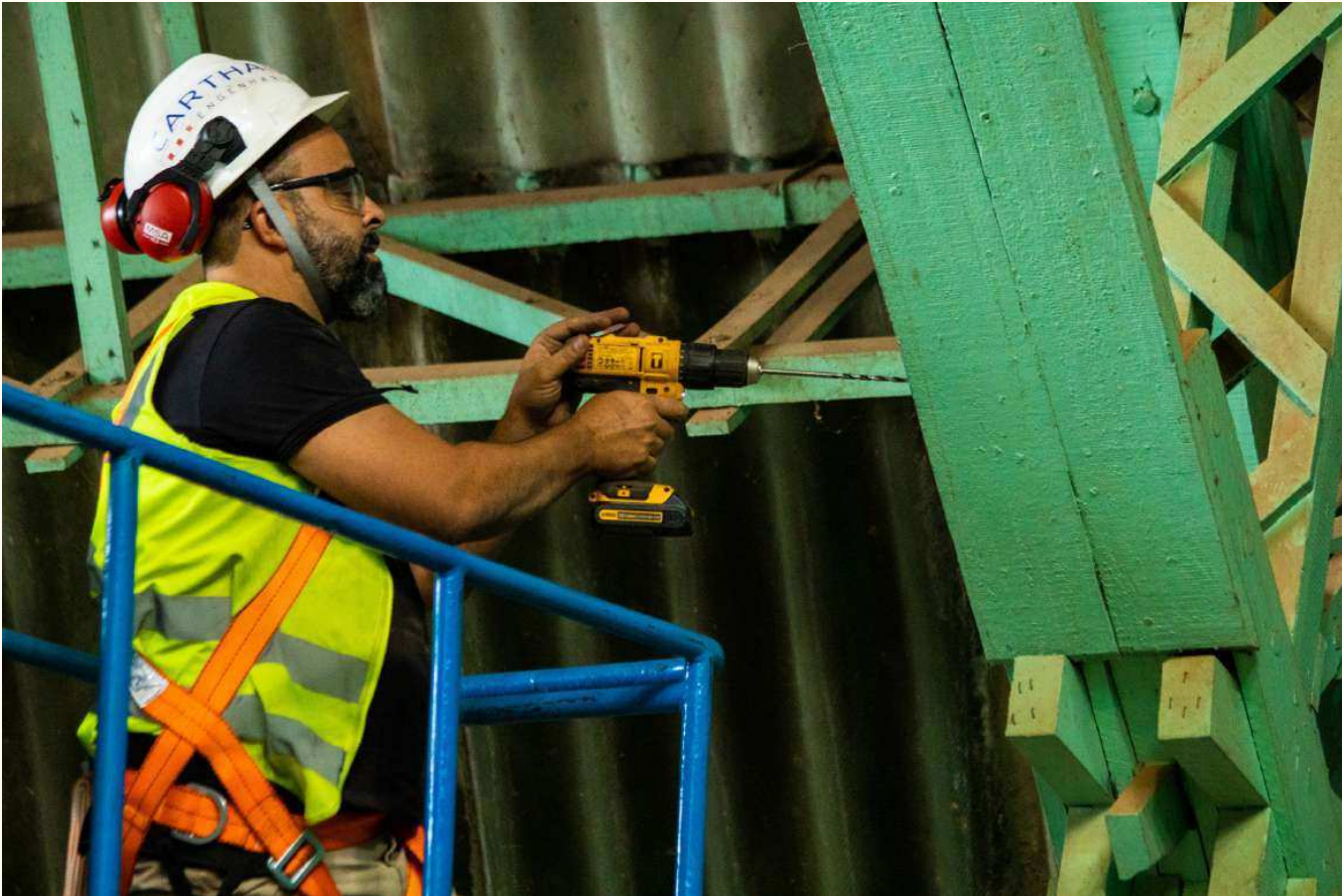
TESTE DE PERFURAÇÃO NO GINÁSIO DE TÊNIS
