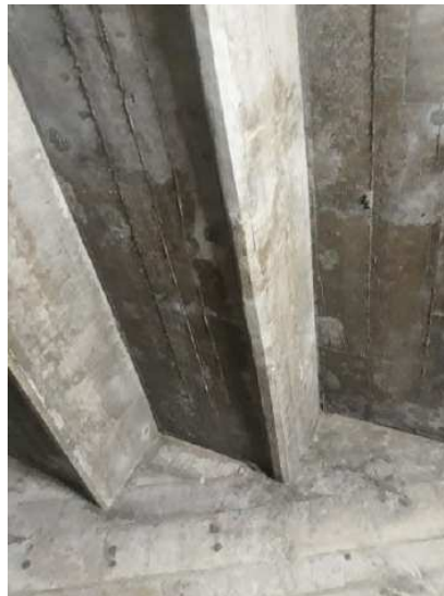
ES - 11 – SETOR 10 – Estrutura vista por baixo Recuperação feita durante a construção do Museu do Futebol.
