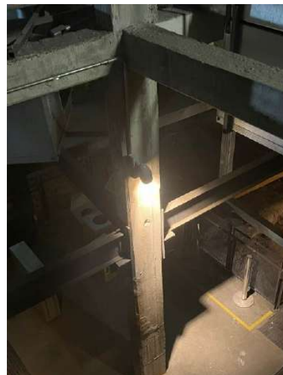
ES - 24 - Vista de viga metálica fixada no pilar da arquibancada
