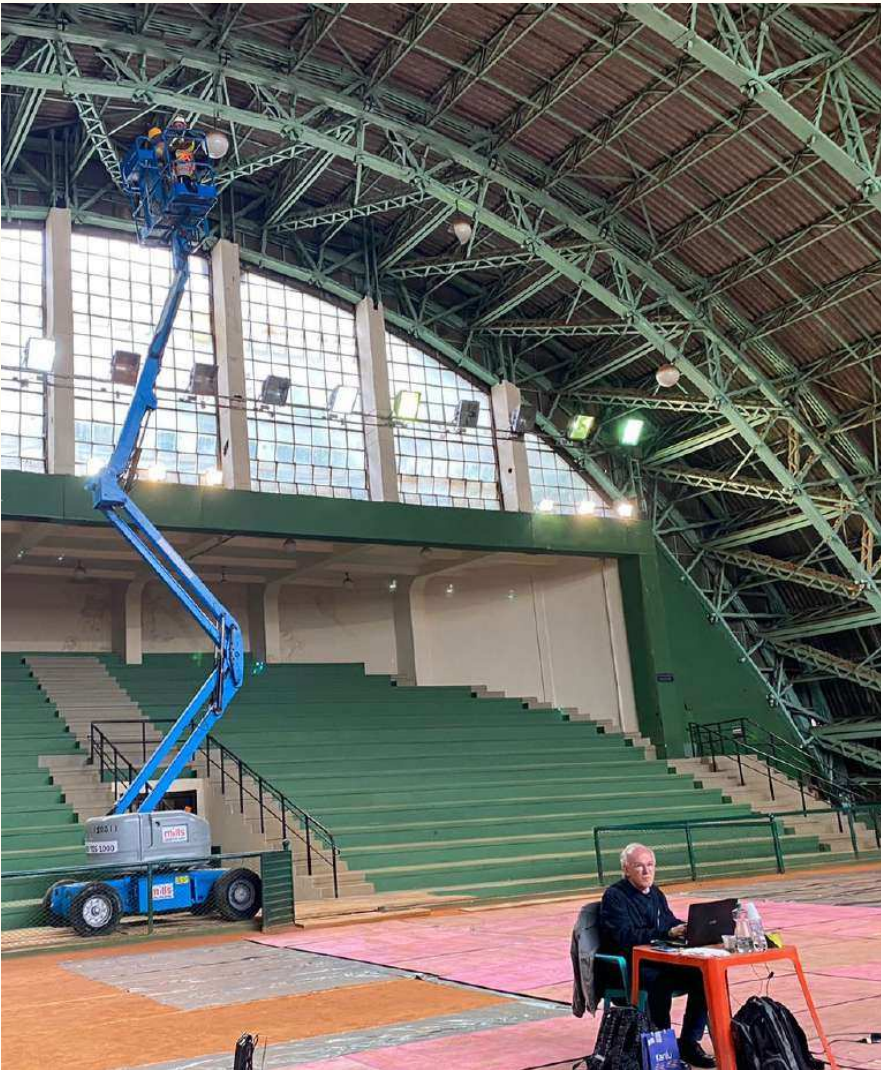
INSPEÇÃO NO GINÁSIO DE TÊNIS
