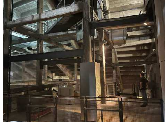
ES - 19 - Vista geral de passarelas metálicas fixadas na estrutura da arquibancada
