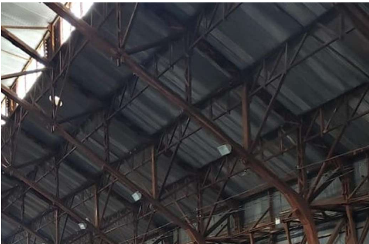
Construção típica do sistema Hauff
