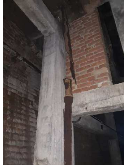
ES - 10 – SETOR 10 – Visão geral da estrutura
