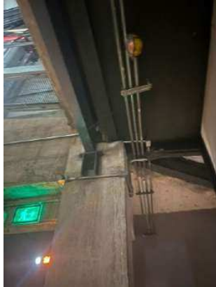
ES - 18 – Vista de viga metálica fixada na estrutura da arquibancada
