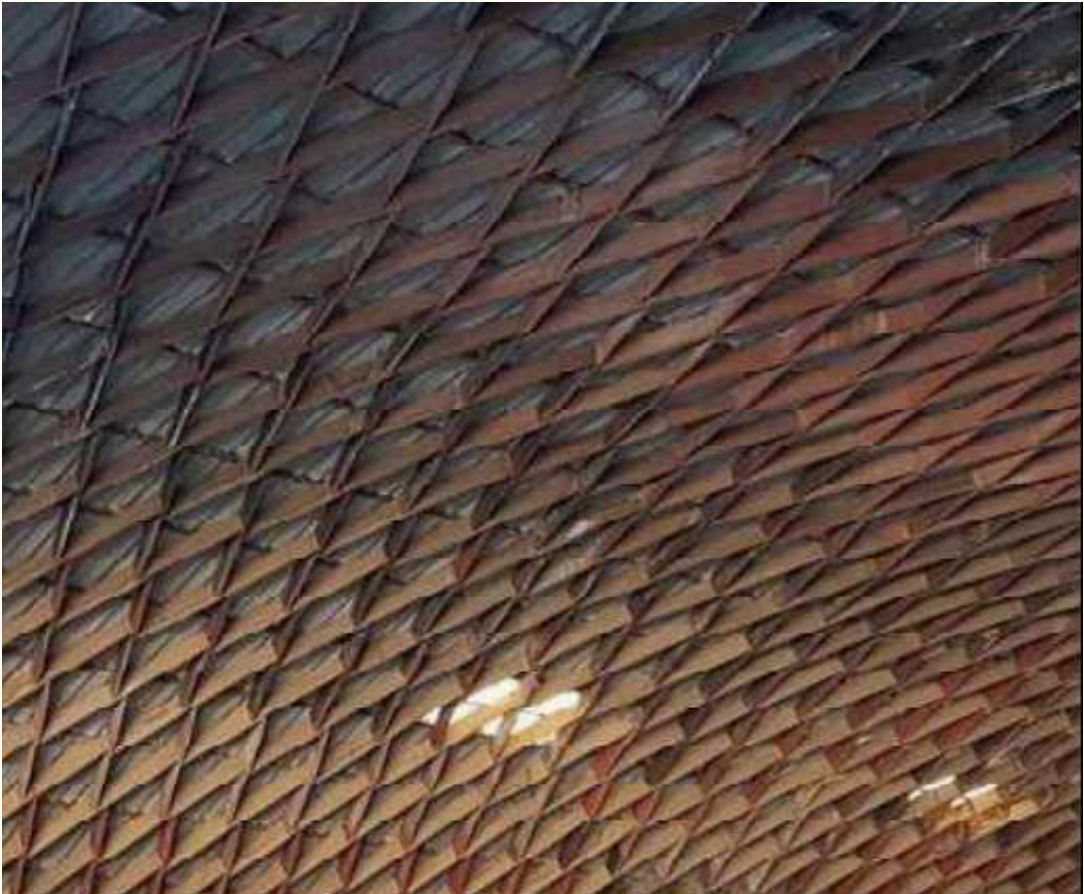
EXEMPLO ESTRUTURA HAUFF SEM PINTURA COBERTURA DO AERoclube POÇOS DE CALDAS - MG FONTE: ACERVO, BIBLIOTECA LaMEM
