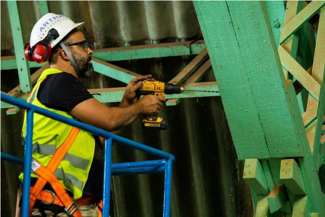
TESTE DE PERFURAÇÃO NO GINÁSIO DE TÊNIS
