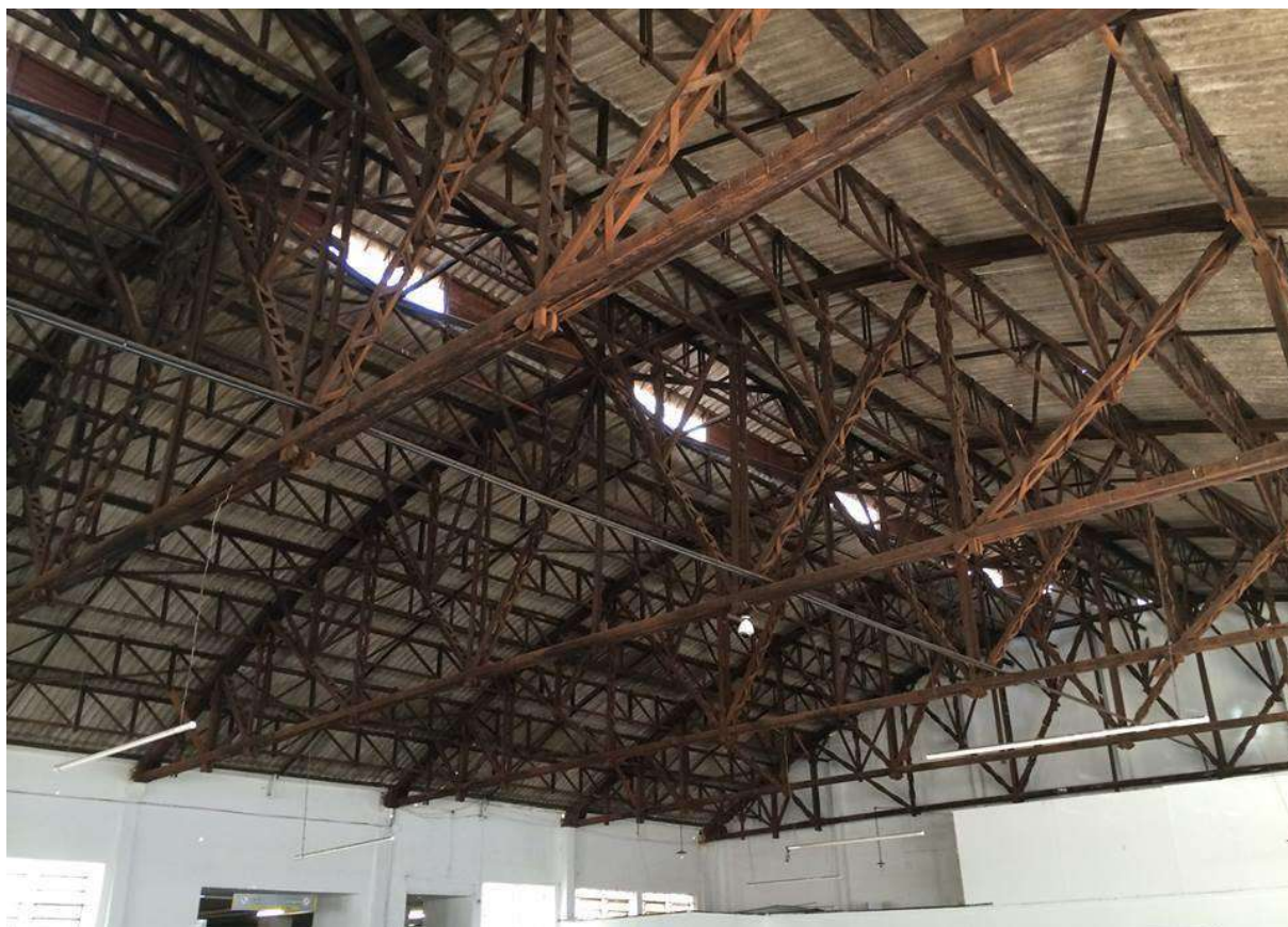
Seção tripla com peças interpostas nos banzos.
