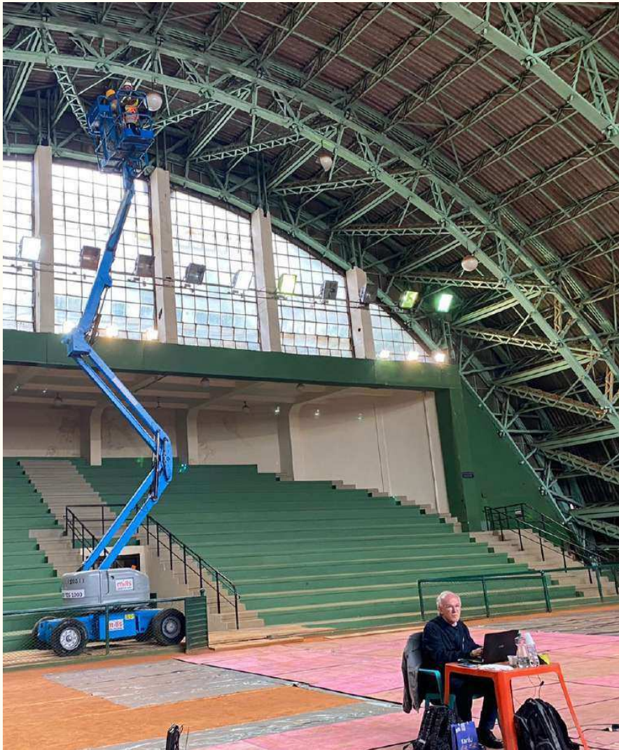
INSPEÇÃO NO GINÁSIO DE TÊNIS
