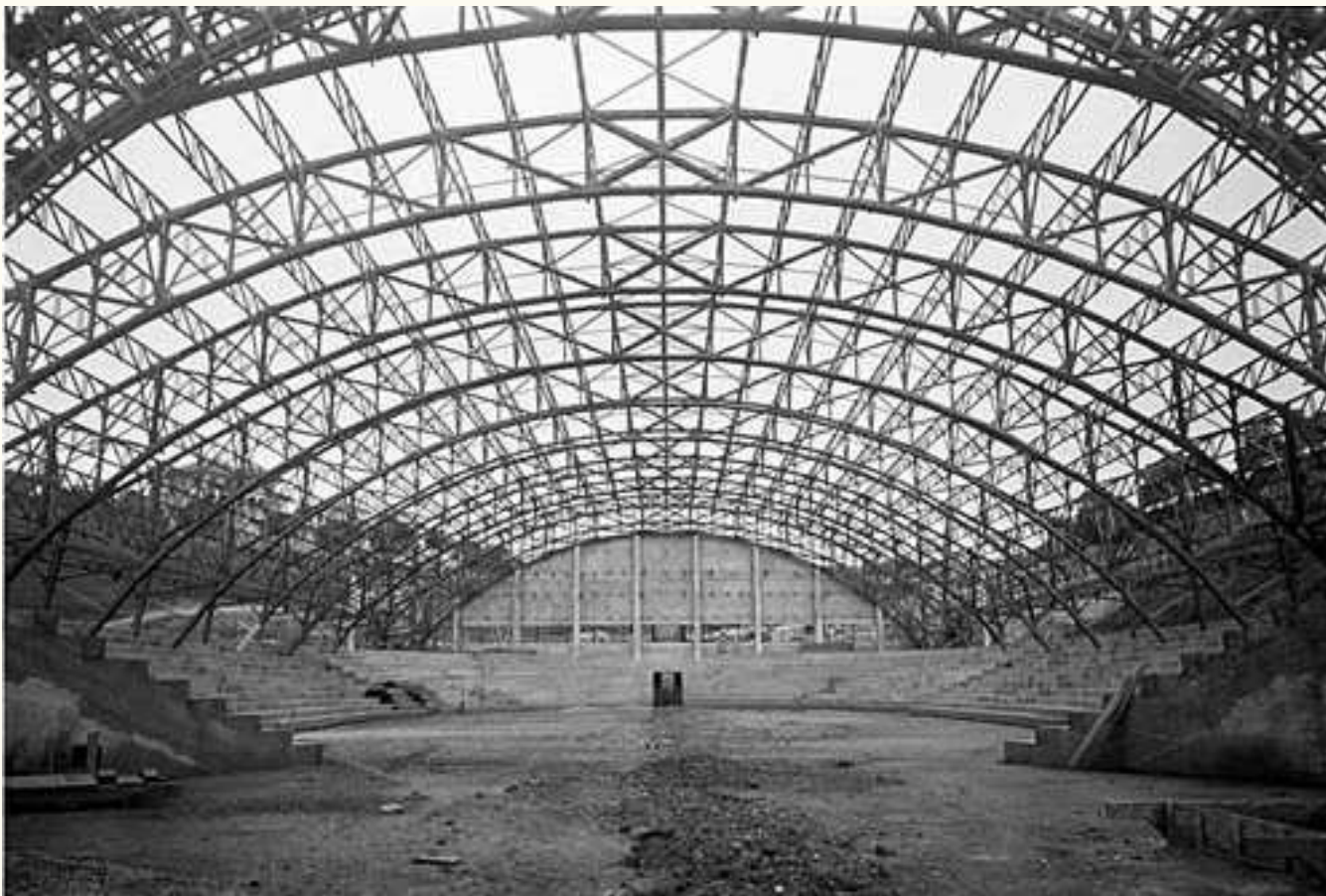
GINÁSIO POLIESPORTIVO EM CONSTRUÇÃO - 1938
