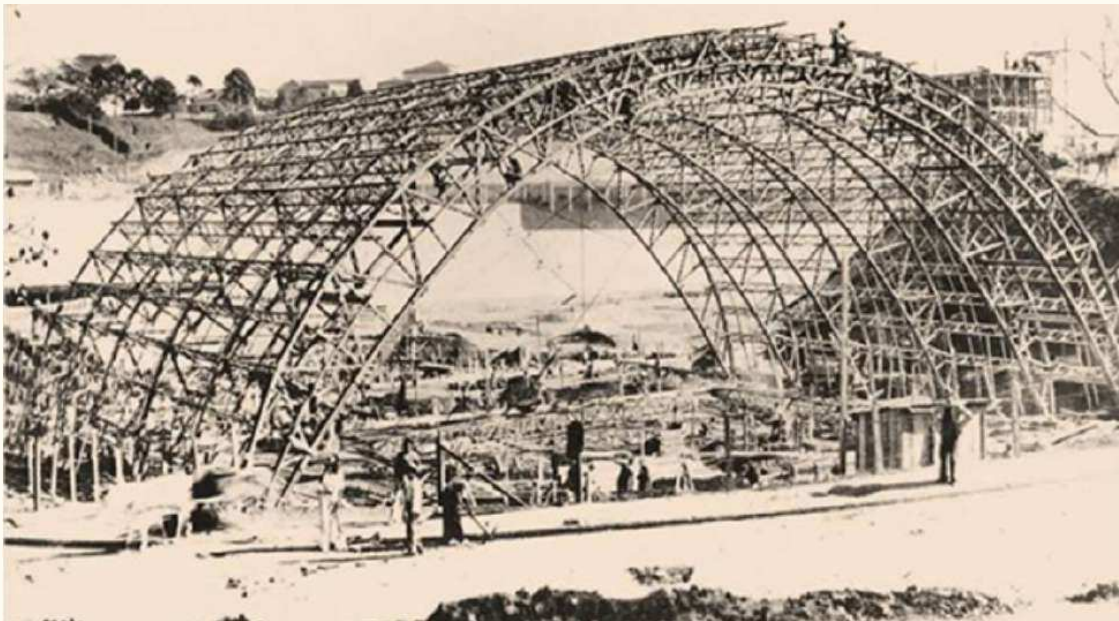
TÊNIS - ESTRUTURA EM CONSTRUÇÃO - 1939
