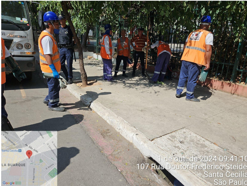
Figura 42 – Local restituído à condição original após intervenção de DESFAZIMENTO.
