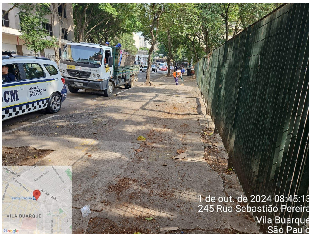
Figura 13 - Conforme na f. 09, local após intervenção de SUBSE/EZU.
