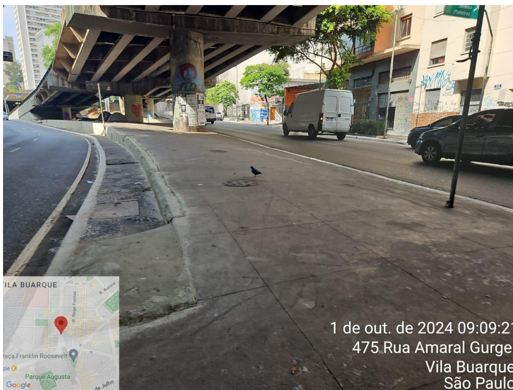
Figura 34 - Local recomposto após intervenção de DESFAZIMENTO.
