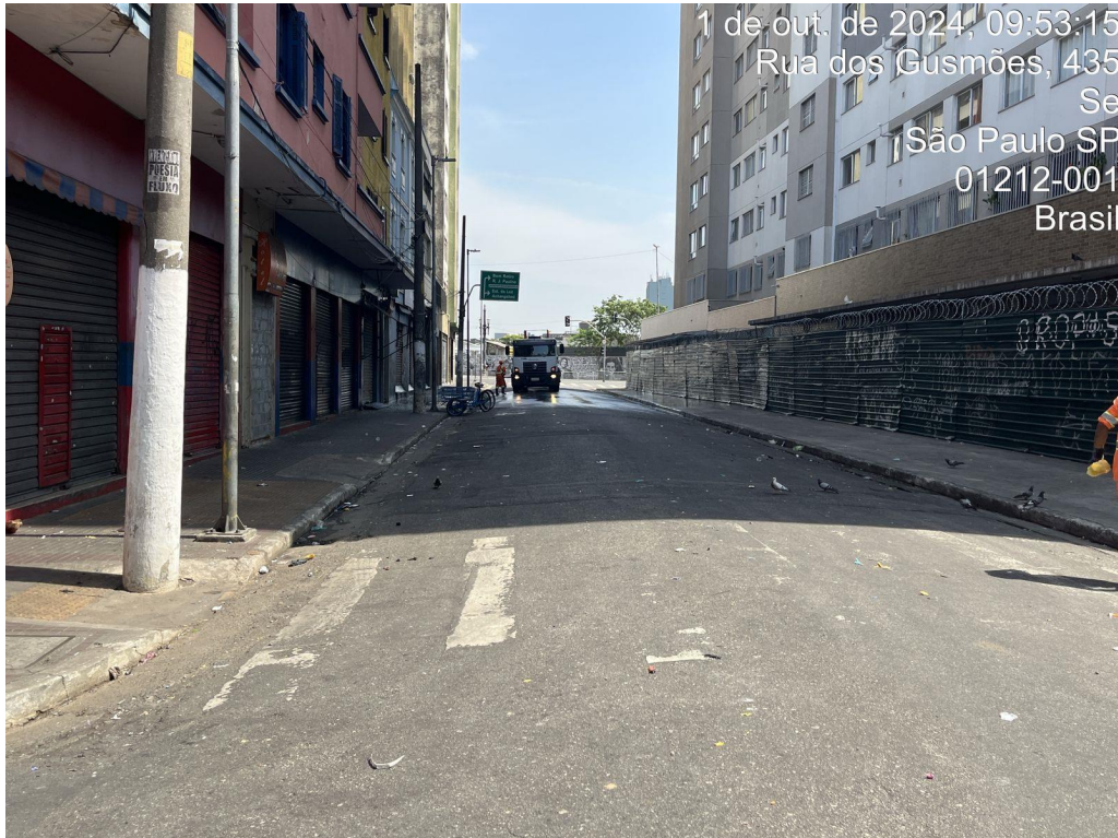
Figura 19 – Como nas ff. 17-8, só que já na fase final, pós intervenção de SUBSE/EZU.
