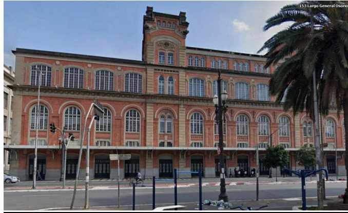
Foto 10 – Edifício do Antigo DOPS/Armazém Central da Estrada de Ferro Sorocabana, onde atualmente está instalado o Memorial da Resistência Edifício Fonte: Google Earth.
