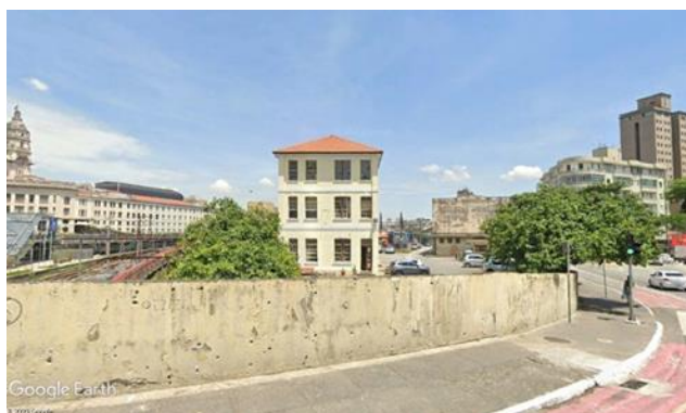
Foto 9 – Vista dos Remanescentes da Primitiva Estação da Estrada de Ferro Sorocabana. Fonte: Google Earth
