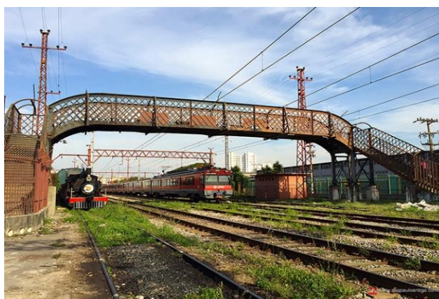
Foto 1 – Travessia sobre Estrada de Ferro na altura da Hospedaria dos Imigrantes – Rua Visconde de Parnaíba (bem removido do local). Fonte: São Paulo Antiga ( https://saopauloantiga.com.br )
