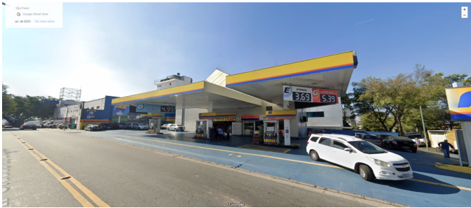
Fig. 5: Ocupação do lote 23 por Posto de Combustível (imagem Google Street View, acessada em 16/07/2024).
