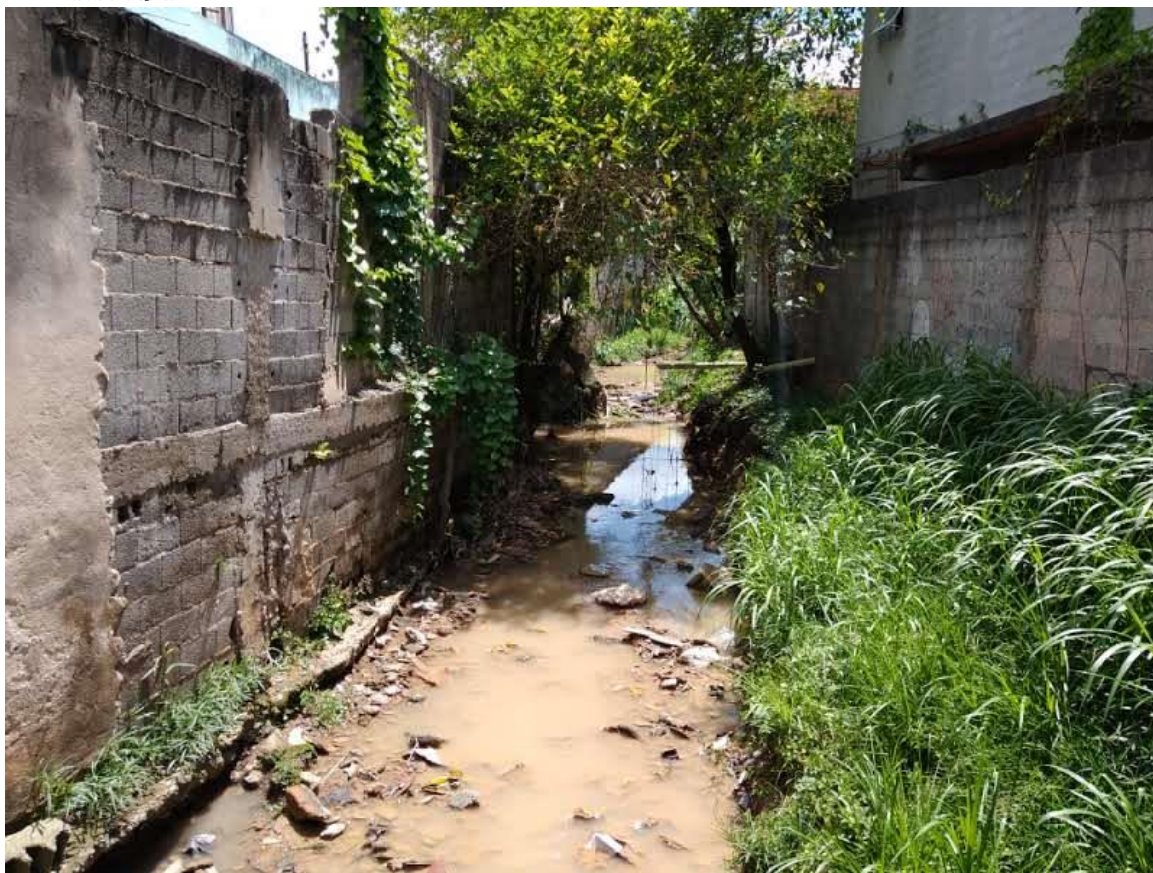
FOTO 6- VEGETAÇÃO CONSTATADA NA PORÇÃO À JUSANTE NO TRECHO DO NÚCLEO URBANO LOTEAMENTO SD/ AC. R. LUIZ ROTTA. REGISTRO EM 28/12/2023.
