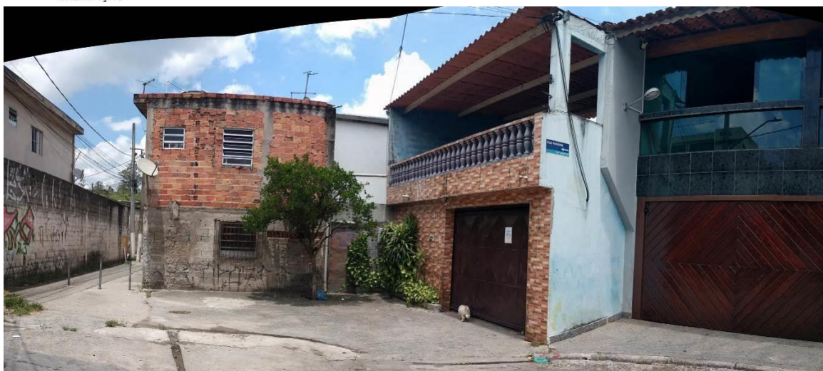
FOTO 16- EDIFICAÇÕES NA RUA PANAMÁ ONDE OS LOTES À DIREITA (NA FOTO) ESTÃO INTEGRALMENTE SOBRE A ÁREA DE PRESERVAÇÃO PERMANENTE – APP DO CURSO D'ÁGUA. REGISTRO EM 28/12/2023.
