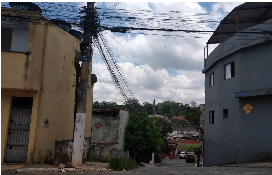
FOTO 24- INTERSECÇÃO ENTRE AS RUAS PANORAMA E LUIZ ROTTA NO TRECHO DO NÚCLEO URBANO LOTEAMENTO SD/ AC. R. LUIZ ROTTA. REGISTRO EM 28/12/2023.
