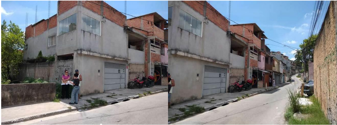
FOTO 18- EDIFICAÇÕES NA EXTENSÃO DA RUA SAMARINDA, ONDE OS LOTES ESTÃO SOBRE A ÁREA DE PRESERVAÇÃO PERMANENTE – APP DO CURSO D'ÁGUA. REGISTRO EM 28/12/2023.
