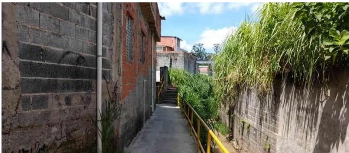
FOTO 1- VISTA DA ESCADA DE ACESSO A PASSARELA EXISTENTE NA ÁREA DE PRESERVAÇÃO PERMANENTE – APP NO TRECHO DO NÚCLEO URBANO LOTEAMENTO SD/ AC. R. LUIZ ROTTA. REGISTRO EM 28/12/2023.
