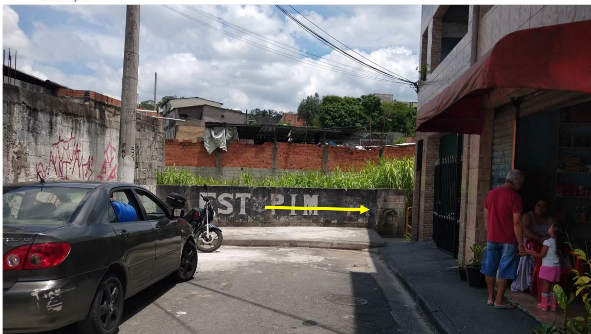
FOTO 14- TRECHO SOBRE A ÁREA DE PRESERVAÇÃO PERMANENTE – APP NA RUA DA PASSAGEM E O ACESSO A PASSARELA SOB O CURSO D'ÁGUA QUE CONECTA AO BAIRRO VIZINHO. REGISTRO EM 28/12/2023.
