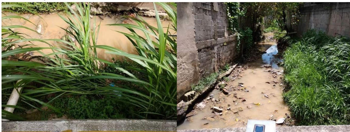
FOTO 3- REGISTRO DAS CONDIÇÕES DO CURSO D'ÁGUA NA PORÇÃO A MONTANTE (ESQUERDA) E A JUSANTE (DIREITA) NO TRECHO DO NÚCLEO URBANO LOTEAMENTO SD/ AC. R. LUIZ ROTTA. REGISTRO EM 28/12/2023.
