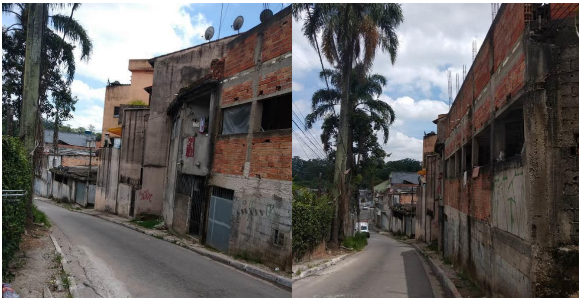
FOTO 20- EDIFICAÇÕES DO NÚCLEO URBANO LOTEAMENTO SD/ AC. R. LUIZ ROTTA NA EXTENSÃO DA RUA SAMARINDA ONDE OS LOTES NAS COTAS SUPERIORES ESTÃO FORA DA ÁREA DE PRESERVAÇÃO PERMANENTE – APP DO CURSO D'ÁGUA. REGISTRO EM 28/12/2023.
