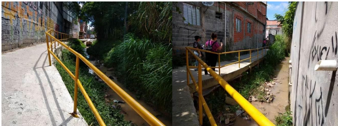
FOTO 9- VISTA DO TRECHO DO CURSO D'ÁGUA COM PROPOSTA DE MANUTENÇÃO E LIMPEZA DO CANAL. REGISTRO EM 28/12/2023.
