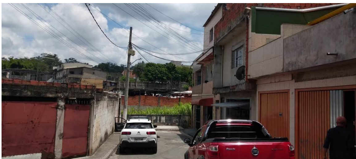
FOTO 13- VISTA DAS EDIFICAÇÕES NA RUA DA PASSAGEM, ONDE OS LOTES ESTÃO INTEGRALMENTE SOBRE A ÁREA DE PRESERVAÇÃO PERMANENTE – APP DO CURSO D'ÁGUA. REGISTRO EM 28/12/2023.
