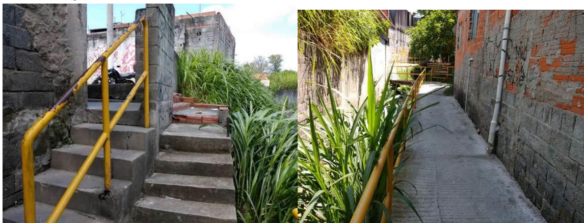
Foto 10- Vista da escada parcialmente executada e trecho adjacente a passarela sem o guarda-corpo. Registro em 28/12/2023.
