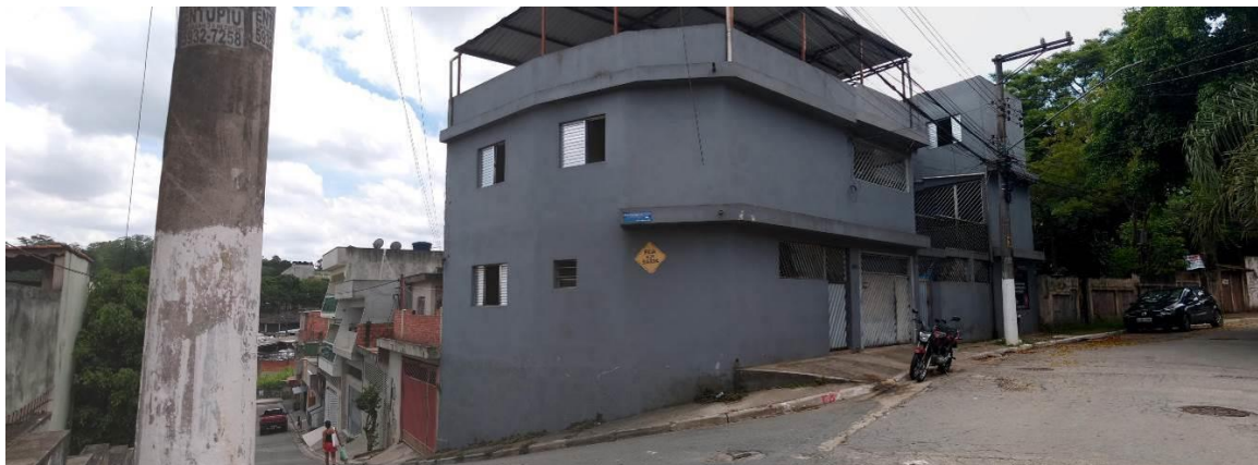
FOTO 23- INTERSECÇÃO ENTRE AS RUAS PANORAMA E LUIZ ROTTA NO TRECHO DO NÚCLEO URBANO LOTEAMENTO SD/ AC. R. LUIZ ROTTA. REGISTRO EM 28/12/2023.
