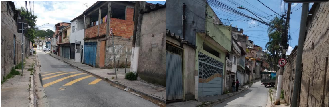
FOTO 19- EDIFICAÇÕES DO NÚCLEO URBANO LOTEAMENTO SD/ AC. R. LUIZ ROTTA NA EXTENSÃO DA RUA SAMARINDA. REGISTRO EM 28/12/2023.
