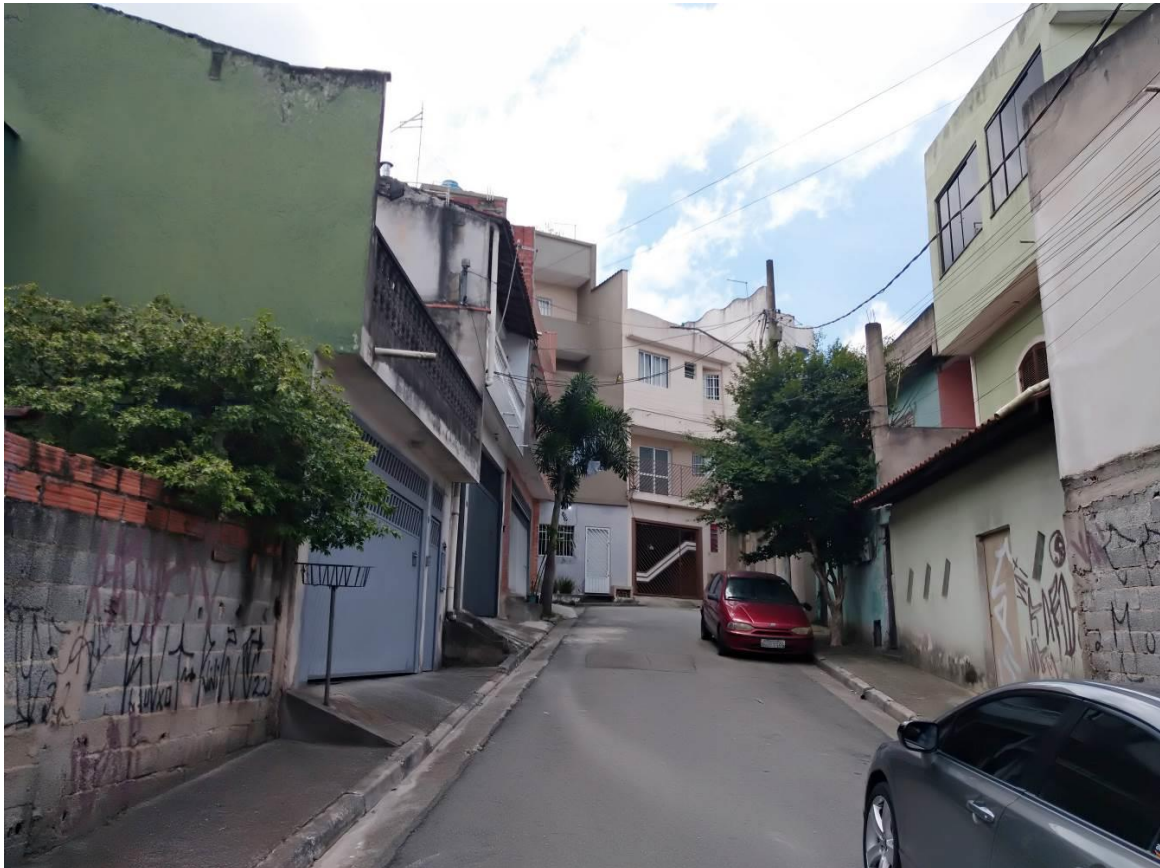
FOTO 17- VISTA DAS EDIFICAÇÕES NA RUA PANAMÁ ONDE OS LOTES NAS COTAS SUPERIORES ESTÃO FORA DA ÁREA DE PRESERVAÇÃO PERMANENTE – APP DO CURSO D'ÁGUA. REGISTRO EM 28/12/2023.
