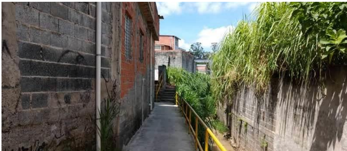
FOTO 1- VISTA DA ESCADA DE ACESSO A PASSARELA EXISTENTE NA ÁREA DE PRESERVAÇÃO PERMANENTE – APP NO TRECHO DO NÚCLEO URBANO LOTEAMENTO SD/ AC. R. LUIZ ROTTA. REGISTRO EM 28/12/2023.
