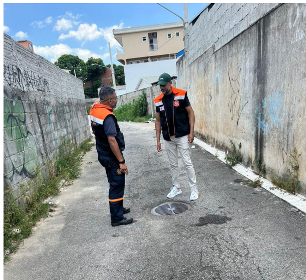
Foto 10 – Visita ao ponto de Alagamento
