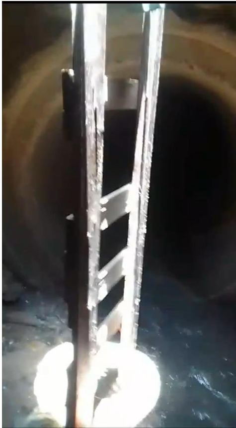
Foto 7 – Equipe de limpeza hidrojoato
