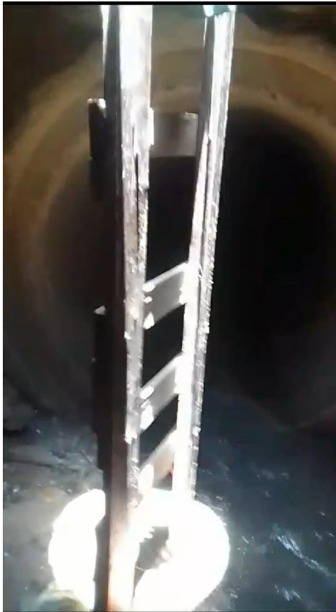
Foto 7 – Equipe de limpeza hidrojoato
