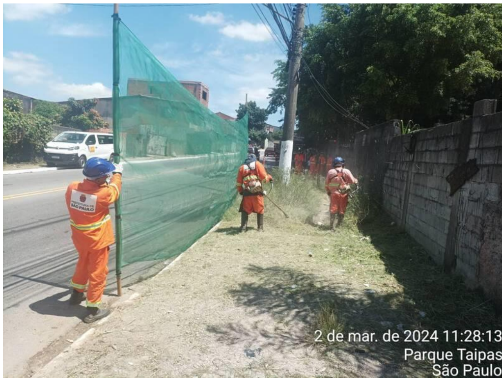
Foto 2 – durante a execução do serviço
