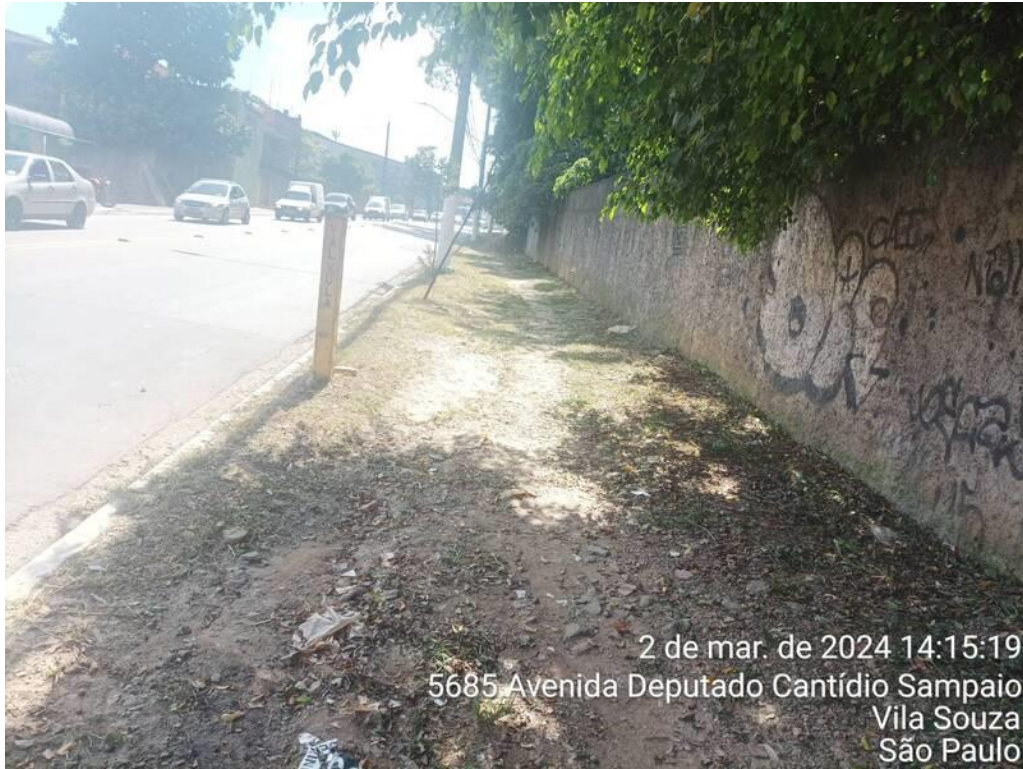
Foto 3 – Após a execução do serviço
