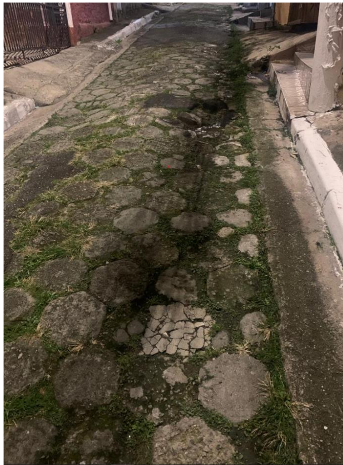
FOTO 01 – ESTADO ORIGINAL DA TRAVESSA
