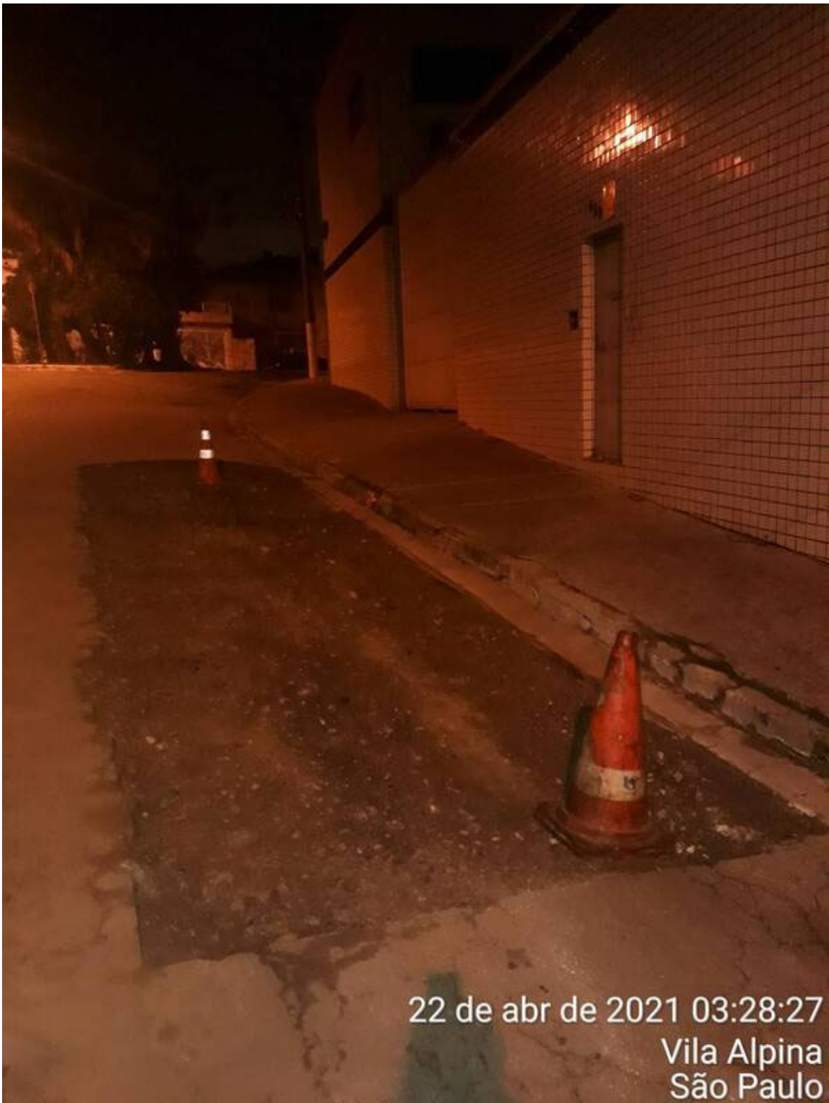
2 | Item de OS APLICAÇÃO DE MASSA Origem: 4703898 - (Foto Capturada Em: 22/04/21 04:21, Por: mxintadm)
