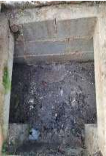
29/01/2024 Limpeza de bocas de lobo Avenida José Higino Neves, 2
