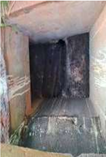
29/01/2024 Limpeza de bocas de lobo Avenida José Higino Neves, 1
