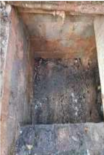
29/01/2024 Limpeza de bocas de lobo Avenida José Higino Neves, 3
