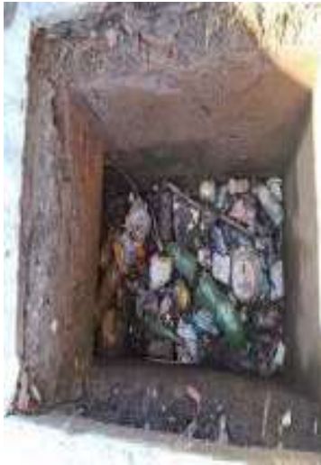
29/01/2024 Limpeza de bocas de lobo Avenida José Higino Neves, 1487
