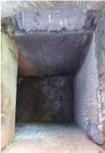
29/01/2024 Limpeza de bocas de lobo Avenida José Higino Neves, 1477
