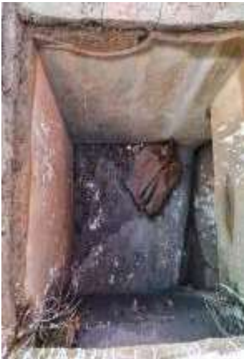
29/01/2024 Limpeza de bocas de lobo Avenida José Higino Neves, 1446
