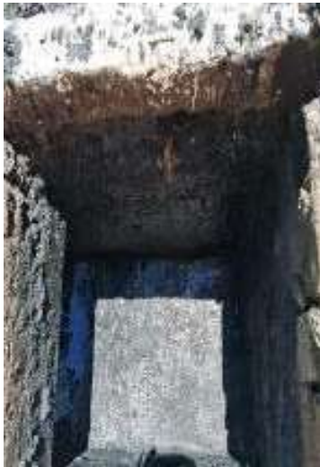
29/01/2024 Limpeza de bocas de lobo Rua Douradinha-do-Campo, 33
