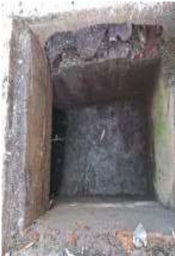
29/01/2024 Limpeza de bocas de lobo Avenida José Higino Neves, 1487
