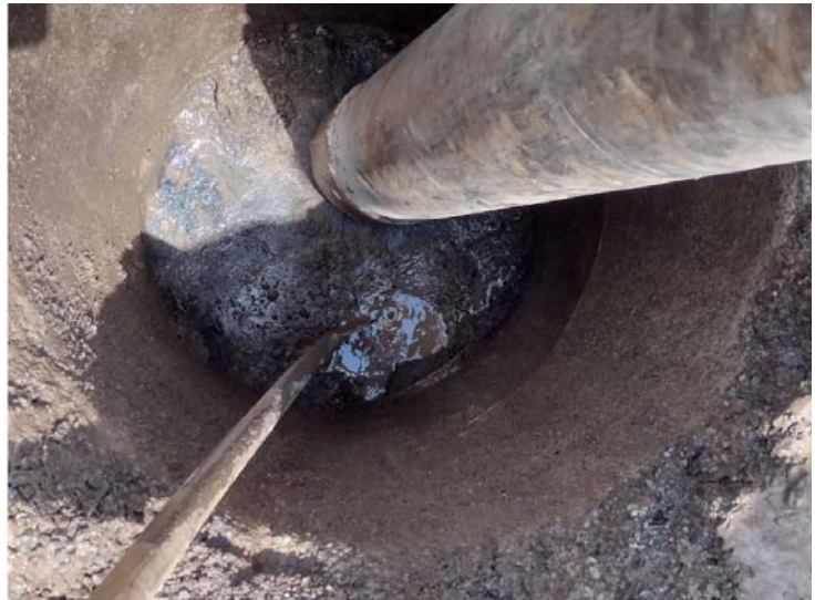
Imagem 11 – Av. José Aristodemo Pinotti – Limpeza de poços de visita
