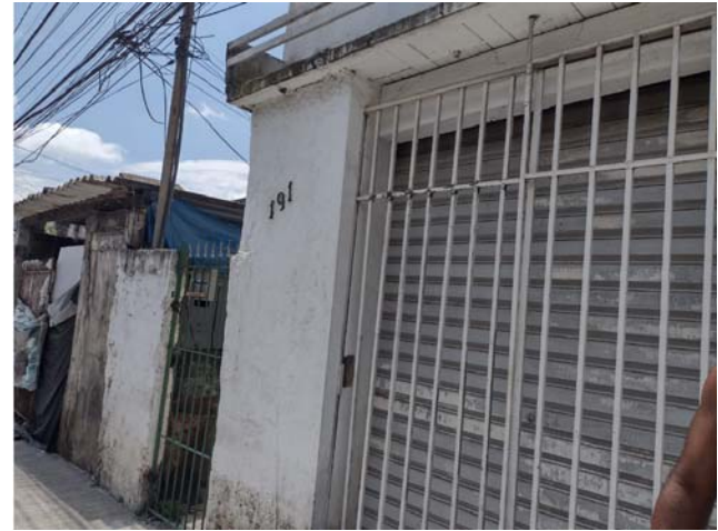
Imagem 09 – Av. José Aristodemo Pinotti, 191 – Limpeza de rede e poços de visita
