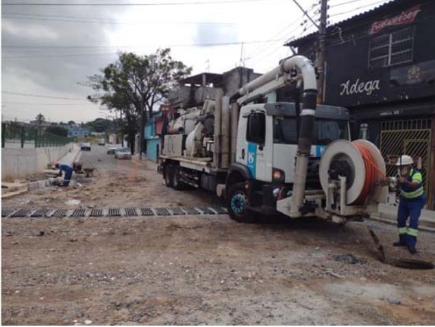
Imagem 06 –Av. José Aristodemo Pinotti x Av Nordestina – Vista da José Aristodemo Pinotti - Limpeza de rede e poços de visita
