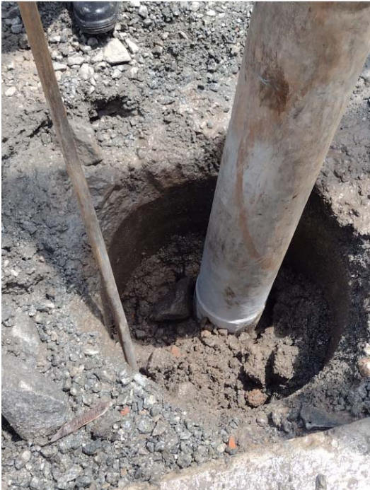
Imagem 10 – Av. José Aristodemo Pinotti – Limpeza de poços de visita
