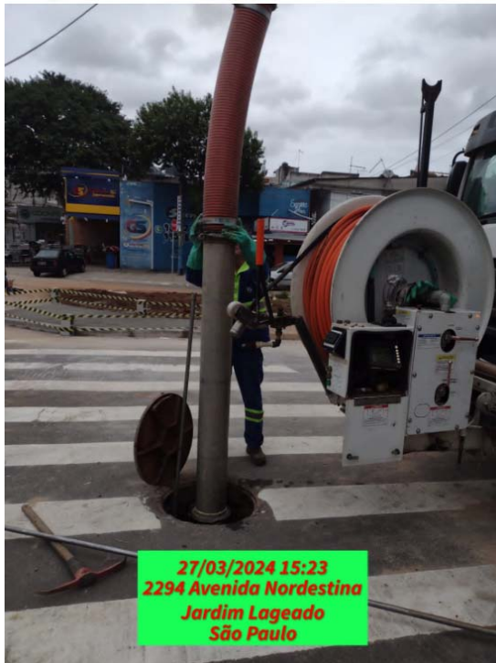
Imagem 18 – Av. Nordestina– Serviço de limpeza de rede de esgoto e poços de visita
