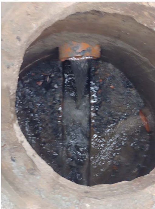
Imagem 12 – Av. José Aristodemo Pinotti – Limpeza de poços de visita
