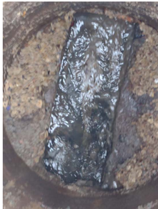
Imagem 13 – Av. José Aristodemo Pinotti – Limpeza de poços de visita
