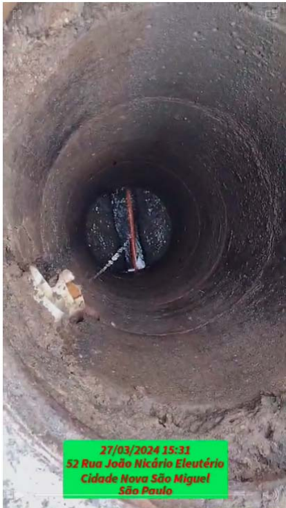
Imagem 25 – Rua João Nicário Eleutério– Serviço de limpeza de rede de esgoto e poços de visita
