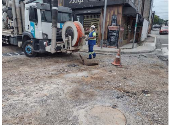
Imagem 07 – Av. José Aristodemo Pinotti x Av Nordestina – Limpeza de rede e poços de visita
