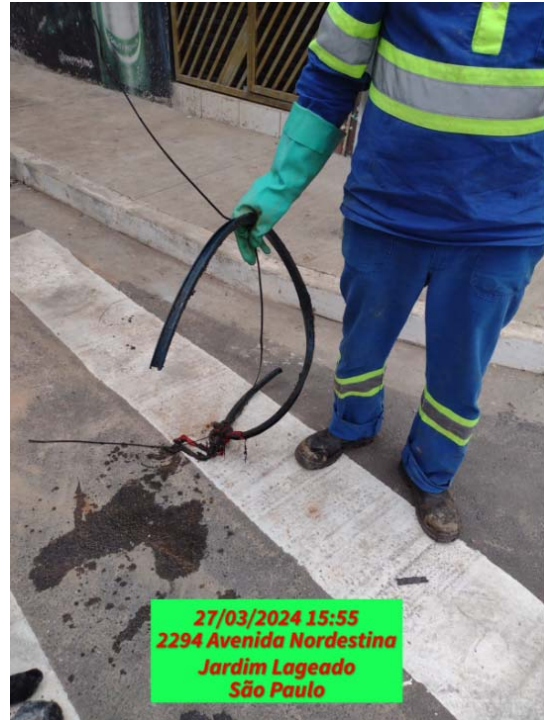
Imagem 19 – Av. Nordestina– Serviço de limpeza de rede de esgoto e poços de visita – Retirada de detritos
