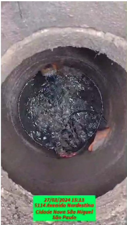
Imagem 22 – Av. Nordestina– Serviço de limpeza de rede de esgoto e poços de visita –
