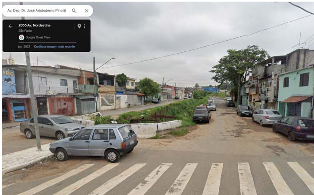
Imagem 02: Av Deputado José Aristodemo Pinotti – Google Maps, janeiro de 2022 – Antes das obras de Contenção das margens
