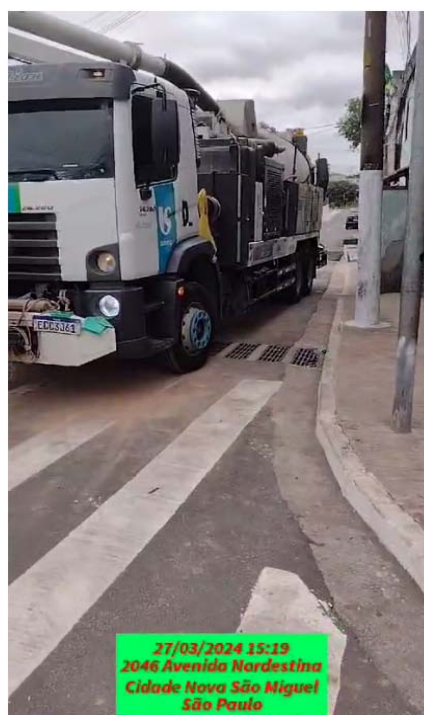
Imagem 17 – Av. José Aristodemo Pinotti x Av. Nordestina– Caminhão para limpeza de rede de esgoto e poços de visita
