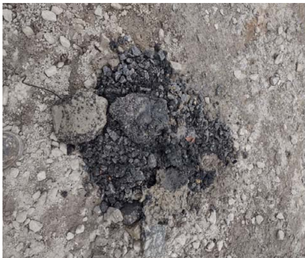
Imagem 14 – Av. José Aristodemo Pinotti – Limpeza de poços de visita – Retirada de detritos
