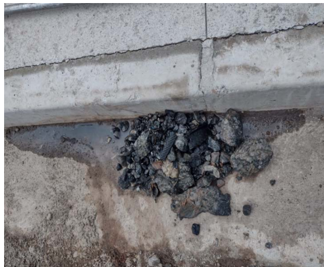
Imagem 15 – Av. José Aristodemo Pinotti – Limpeza de poços de visita – Retirada de detritos
