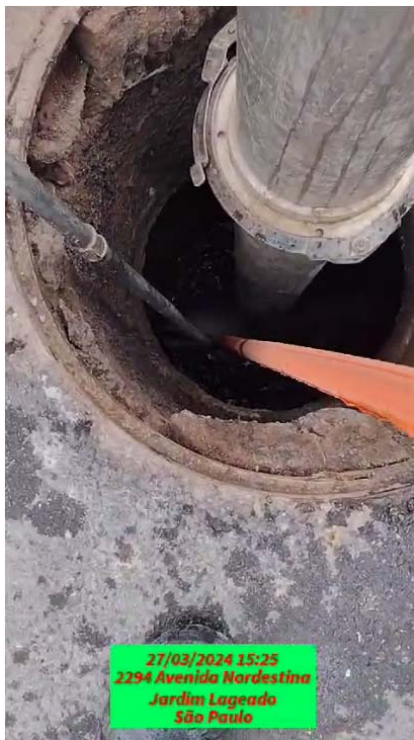
Imagem 20 – Av. Nordestina– Serviço de limpeza de rede de esgoto e poços de visita
