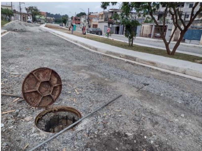
Imagem 08 – Av. José Aristodemo Pinotti – Limpeza de rede e poços de visita
