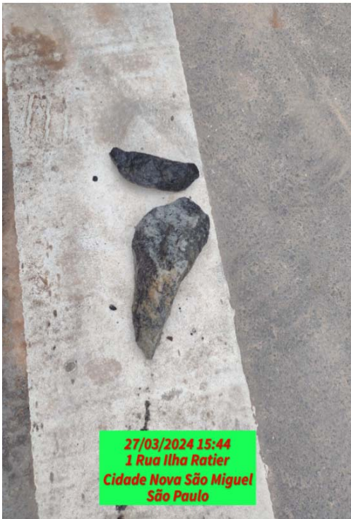
Imagem 24 – Rua Ilha Ratier– Serviço de limpeza de rede de esgoto – Retirada de detritos
