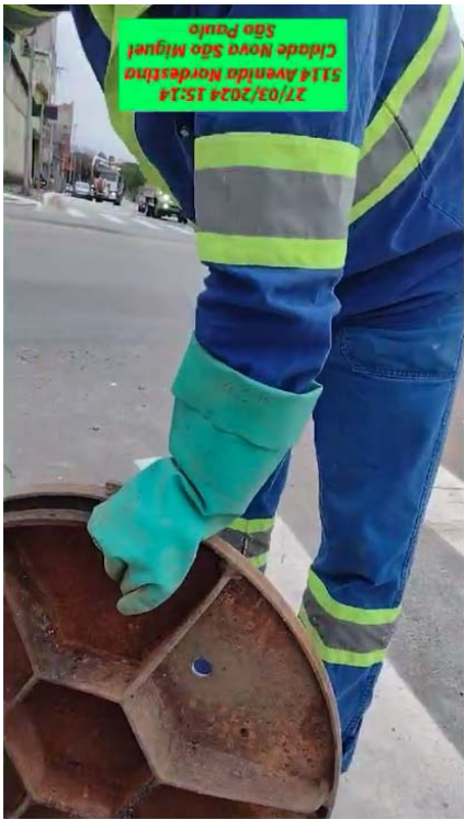
Imagem 23 – Av. Nordestina– Serviço de limpeza de rede de esgoto e poços de visita
