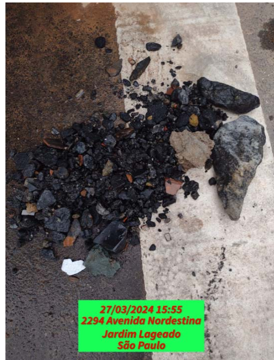
Imagem 21 – Av. Nordestina– Serviço de limpeza de rede de esgoto e poços de visita – Retirada de detritos
