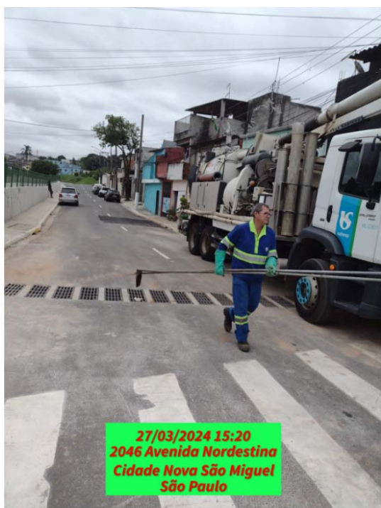
Imagem 16 – Av. José Aristodemo Pinotti x Av. Nordestina– Caminhão para limpeza de rede de esgoto e poços de visita
