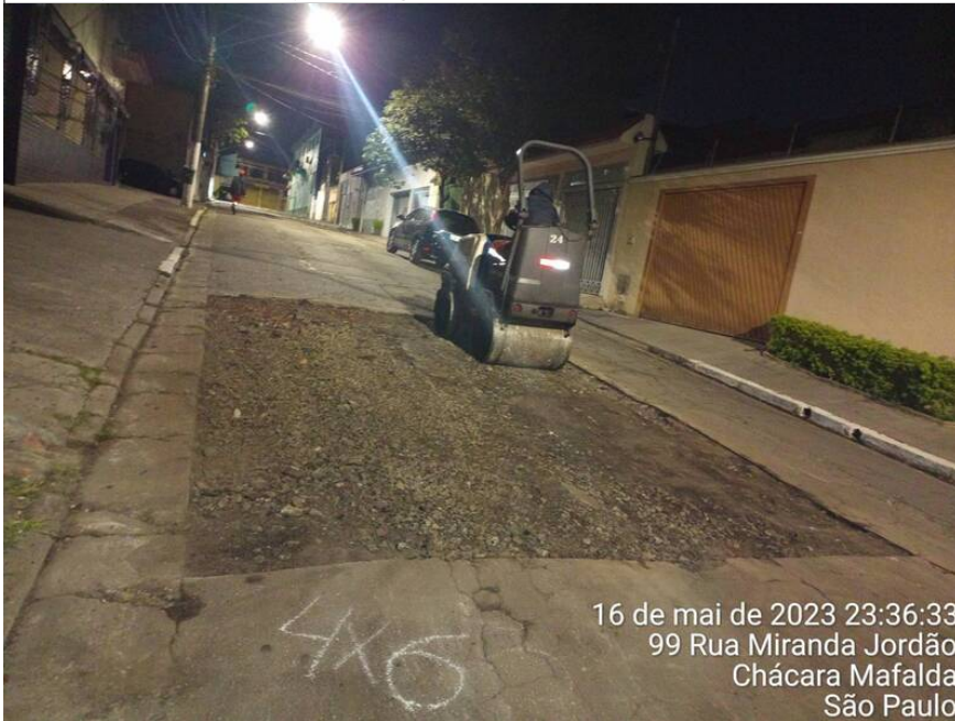
12 | ACABAMENTO → IRRE. DA VIA (CAIXA PRONTA): Item de OS APLICAÇÃO DE MASSA Origem: 7416241 - (Foto Capturada Em: 18/05/23 14:07, Por: mxintadm)
