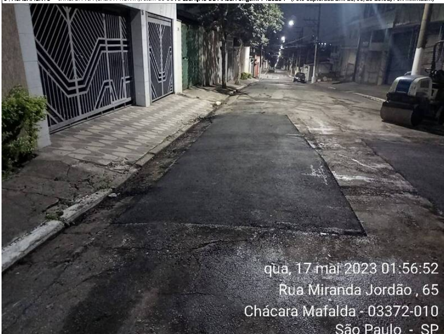
7 | COMPACTAÇÃO → BASE: Item de OS APLICAÇÃO DE MASSA Origem: 7416234 - (Foto Capturada Em: 18/05/23 13:51, Por: mxintadm)
