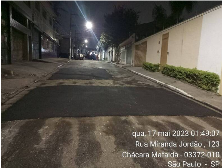
11 | APLICAÇÃO → EMULSÃO: Item de OS APLICAÇÃO DE MASSA Origem: 7412770 - (Foto Capturada Em: 18/05/23 14:07, Por: mxintadm)
