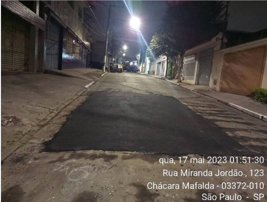
4 | APLICAÇÃO → M.ASFÁLTICA (HASTE): Item de OS APLICAÇÃO DE MASSA Origem: 7416241 - (Foto Capturada Em: 18/05/23 14:07, Por: mxintadm)
