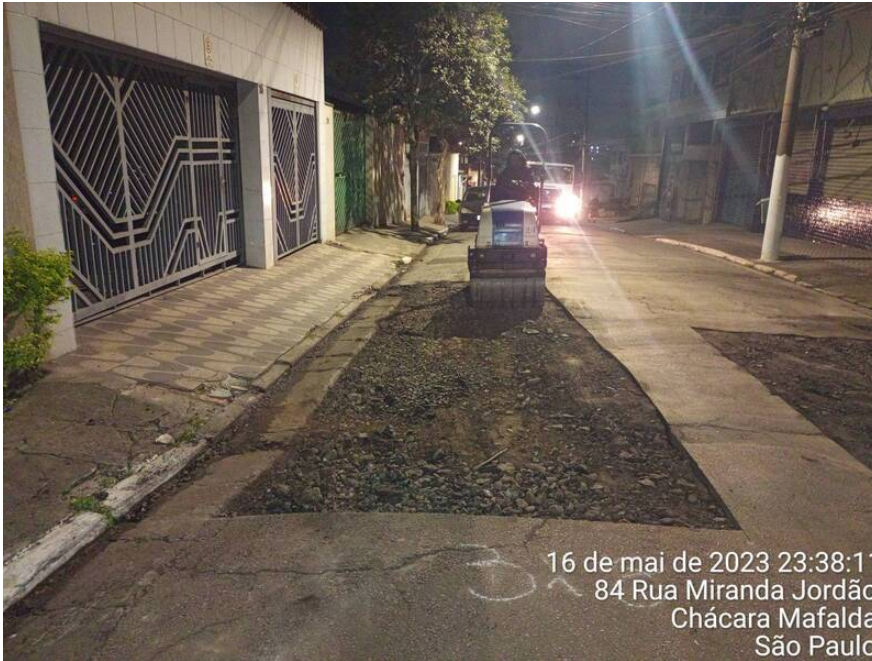
12 | ACABAMENTO → IRRE. DA VIA (CAIXA PRONTA): Item de OS APLICAÇÃO DE MASSA Origem: 7416234 - (Foto Capturada Em: 18/05/23 13:51, Por: mxintadm)
