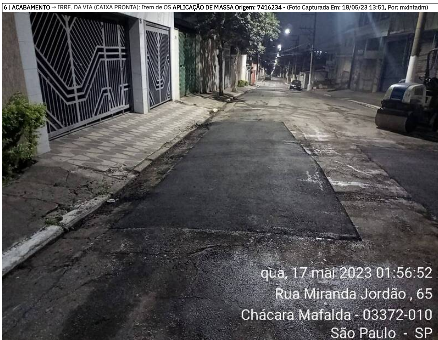
6 | ACABAMENTO → IRRE. DA VIA (CAIXA PRONTA): Item de OS APLICAÇÃO DE MASSA Origem: 7416234 - (Foto Capturada Em: 18/05/23 13:51, Por: mxintadm)
