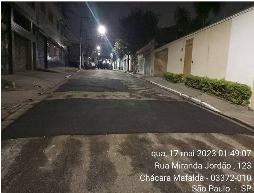
11 | APLICAÇÃO → EMULSÃO: Item de OS APLICAÇÃO DE MASSA Origem: 7412770 - (Foto Capturada Em: 18/05/23 14:07, Por: mxintadm)
