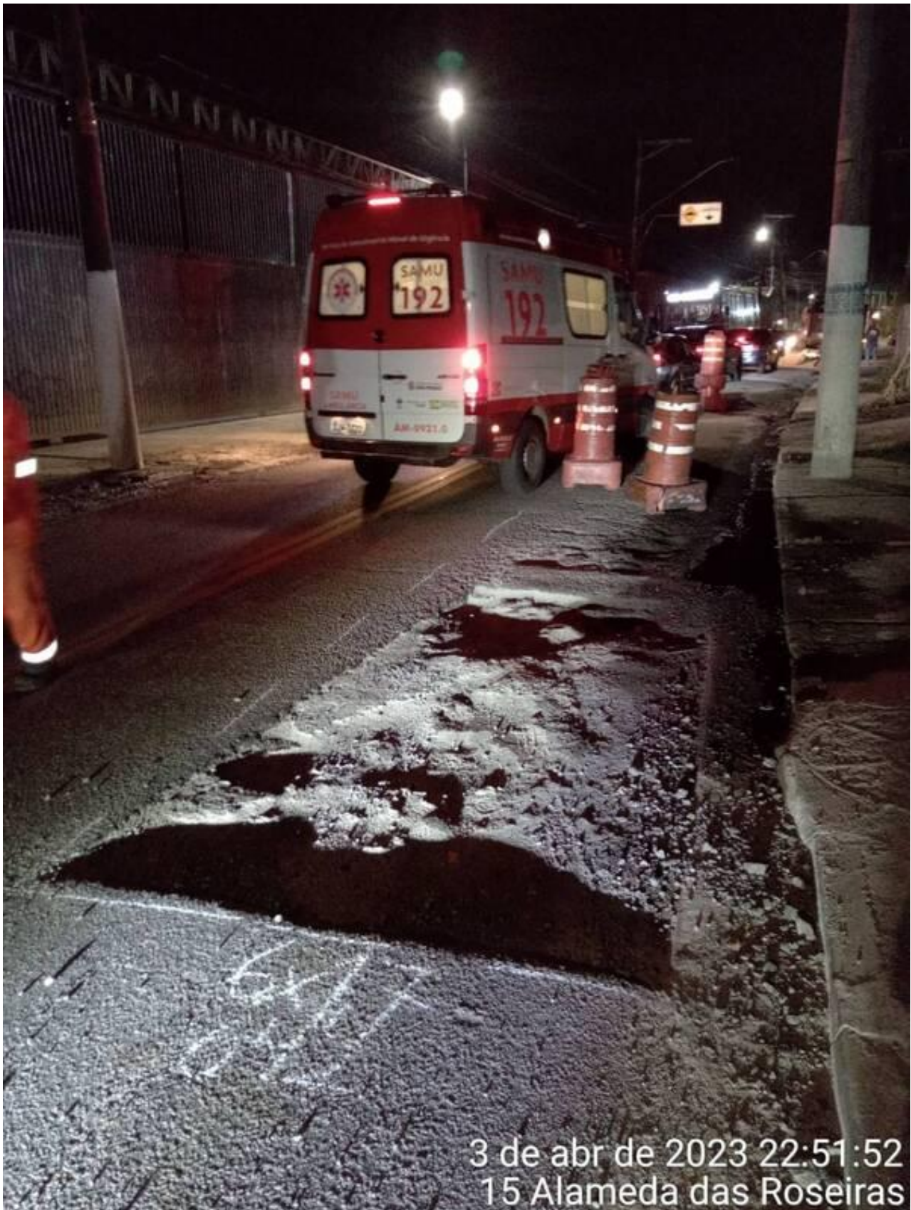
4 | RECORTE → Limpeza da caixa com a trena de 1m, após a serra clipper; Item de OS RECORTE DA CONCORDÂNCIA Origem: 6901643 - (Foto Capturada Em: 05/04/23 01:42, Por: mxintadm)
