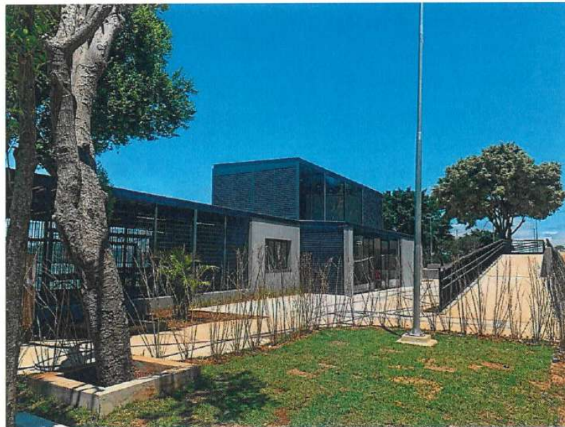
Terminal Hidroviário Parque Linear Cantinho do Céu (em obras) /Fonte: SPTrans – foto: Samuel Alves
