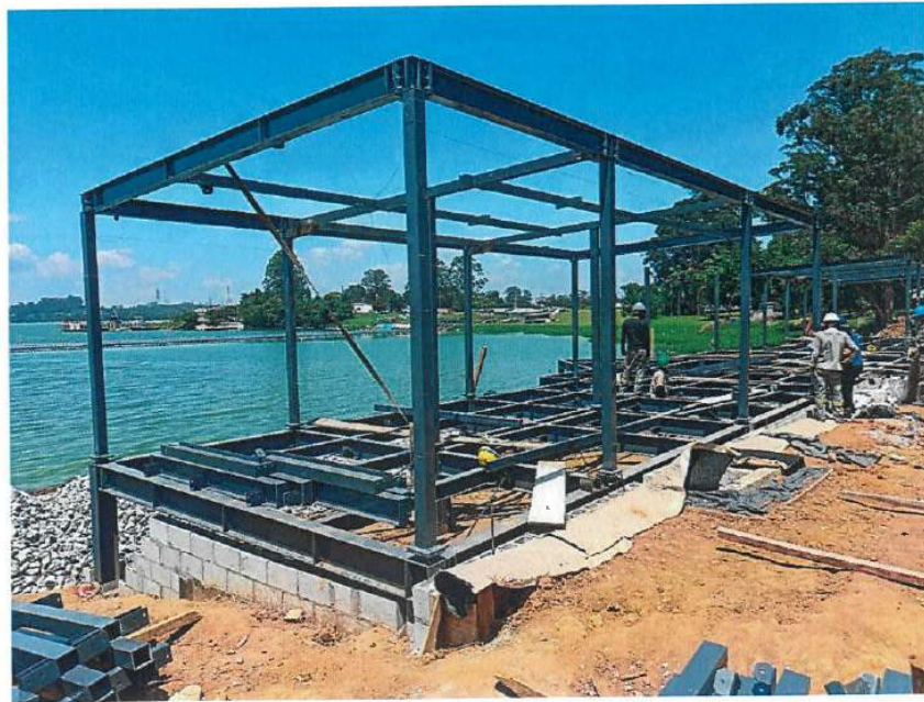
Terminal Hidroviário Parque Mar Paulista (em obras) /Fonte: SPTrans
