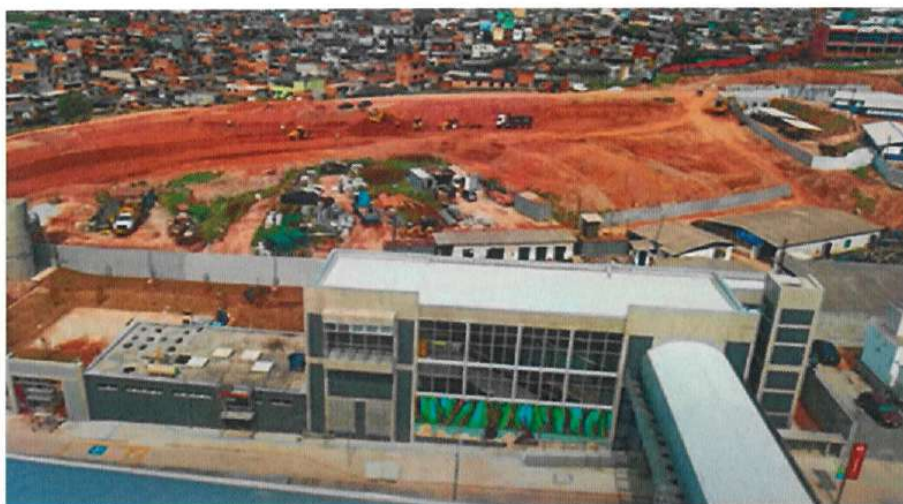
Linha 9 – Esmeralda - obras da Estação Varginha e na área do novo terminal de ônibus Estação Varginha em 2023
