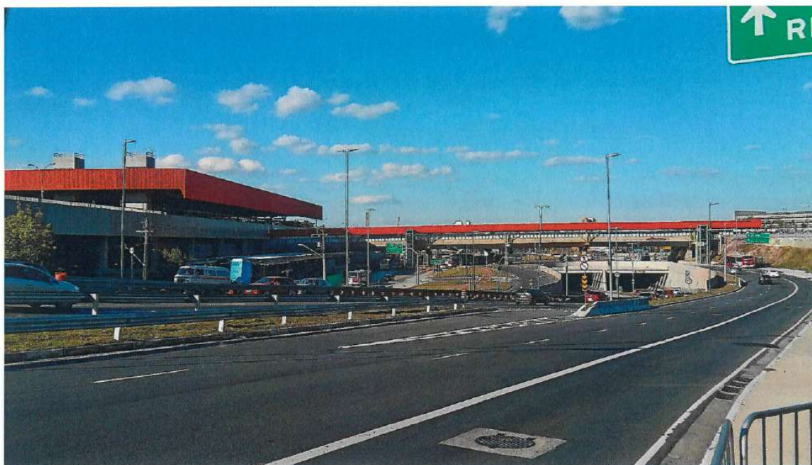
Centralidade de Itaquera com estações, terminal e Polo Institucional – arredores do Novo Terminal Itaquera
