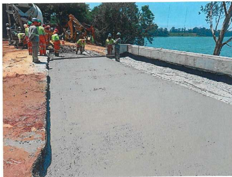
Baia para acomodação de ônibus junto ao Terminal Hidroviário Parque Mar Paulista (em obras) /Fonte: SPTrans
