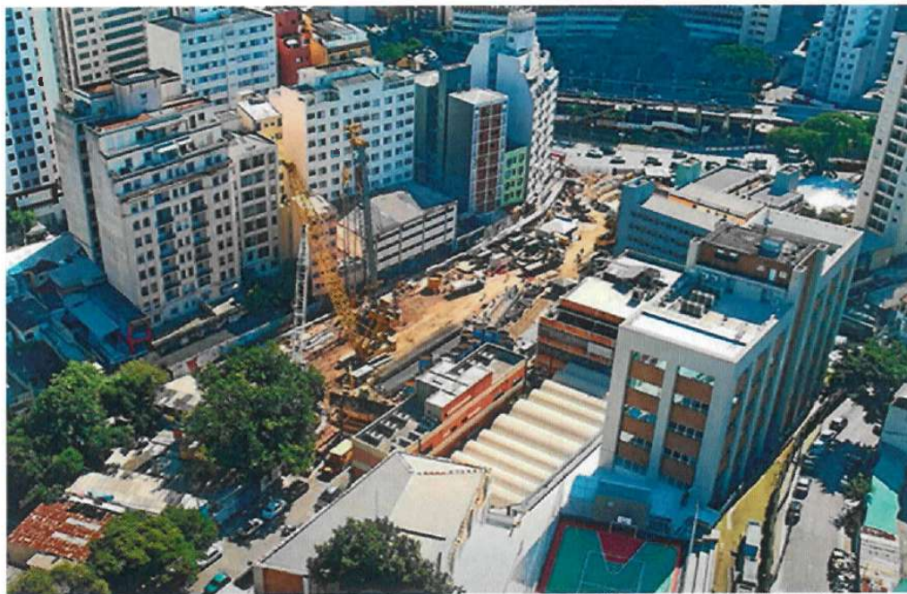
Obras da Linha 6 – Laranja próximo à Parada 14 BIS do Corredor Santo Amaro – Nove de Julho – Centro em 2023/Fonte: site Metrô e CPTM
